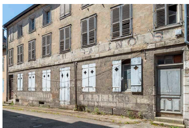
Façade postérieure (rue d'Orgemont). Partie inférieure. Phot. Jérôme Mongreville IVR43_20233900728NUC4A
