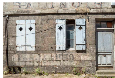
Façade rue d'Orgemont. Rez-de-chaussée des travées nord. Phot. Jérôme Mongreville IVR43_20233900729NUC4A
