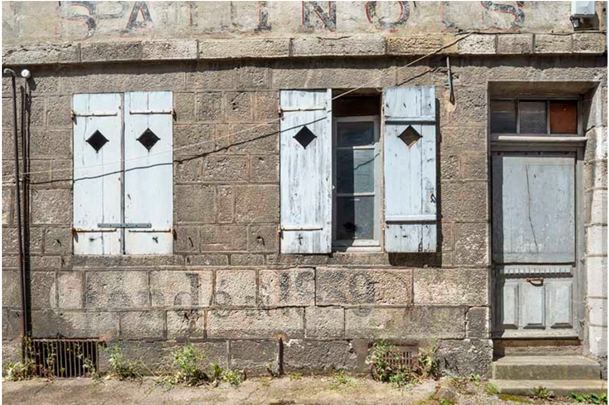
Façade rue d'Orgemont. Rez-de-chaussée des travées nord.
