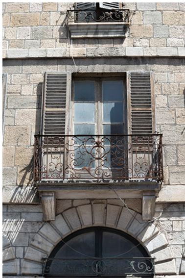
Façade antérieure. Partie inférieure de la travée centrale. Phot. Jérôme Mongreville IVR43_20243900833NUC4A
