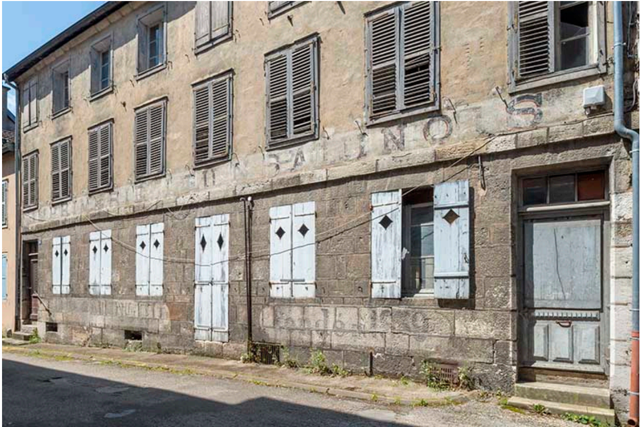
Façade postérieure (rue d'Orgemont). Partie inférieure.
