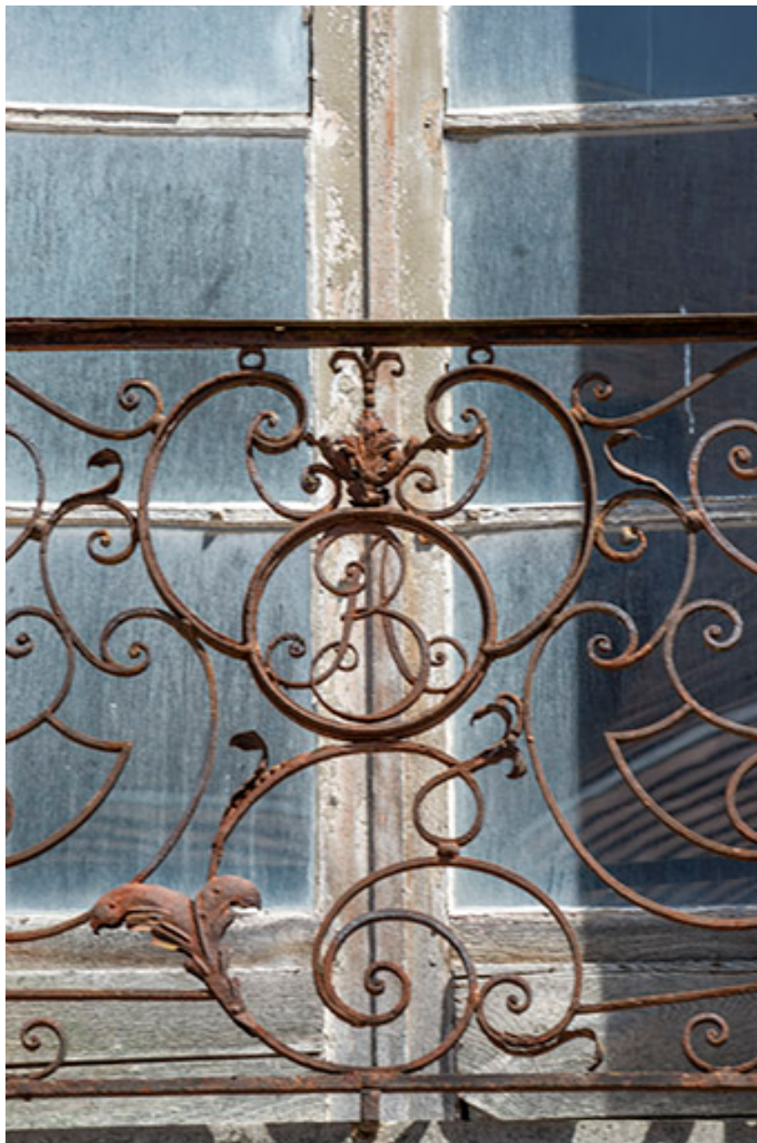
Façade antérieure. Détail de la ferronnerie du balcon (1er étage).
