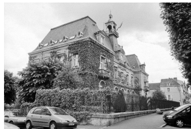
Façade postérieure de l'hôtel de ville, vue du nord. Phot. Frédéric Pillet IVR26_20007100536Z
