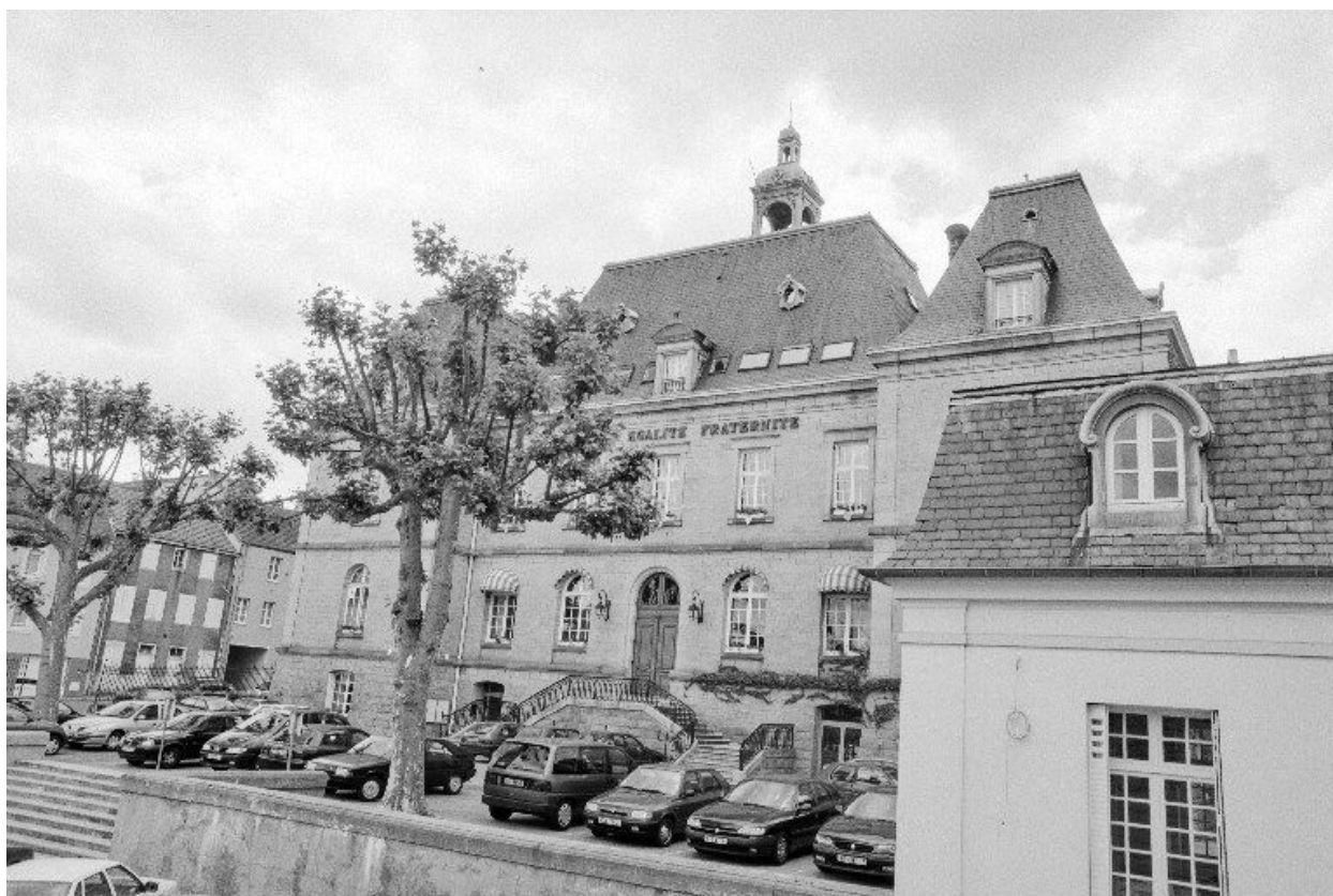
Façade antérieure de l'hôtel de ville.
