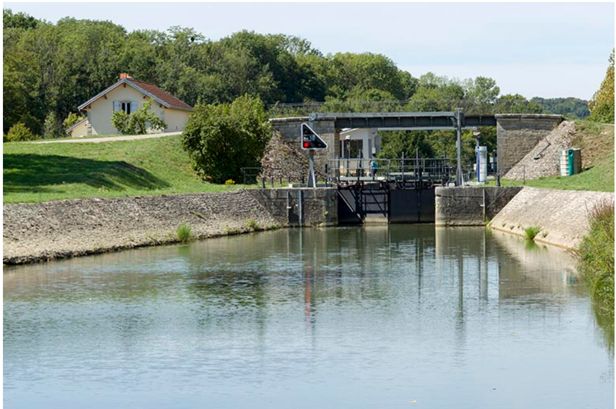
Entrée amont de l'écluse à sas.
