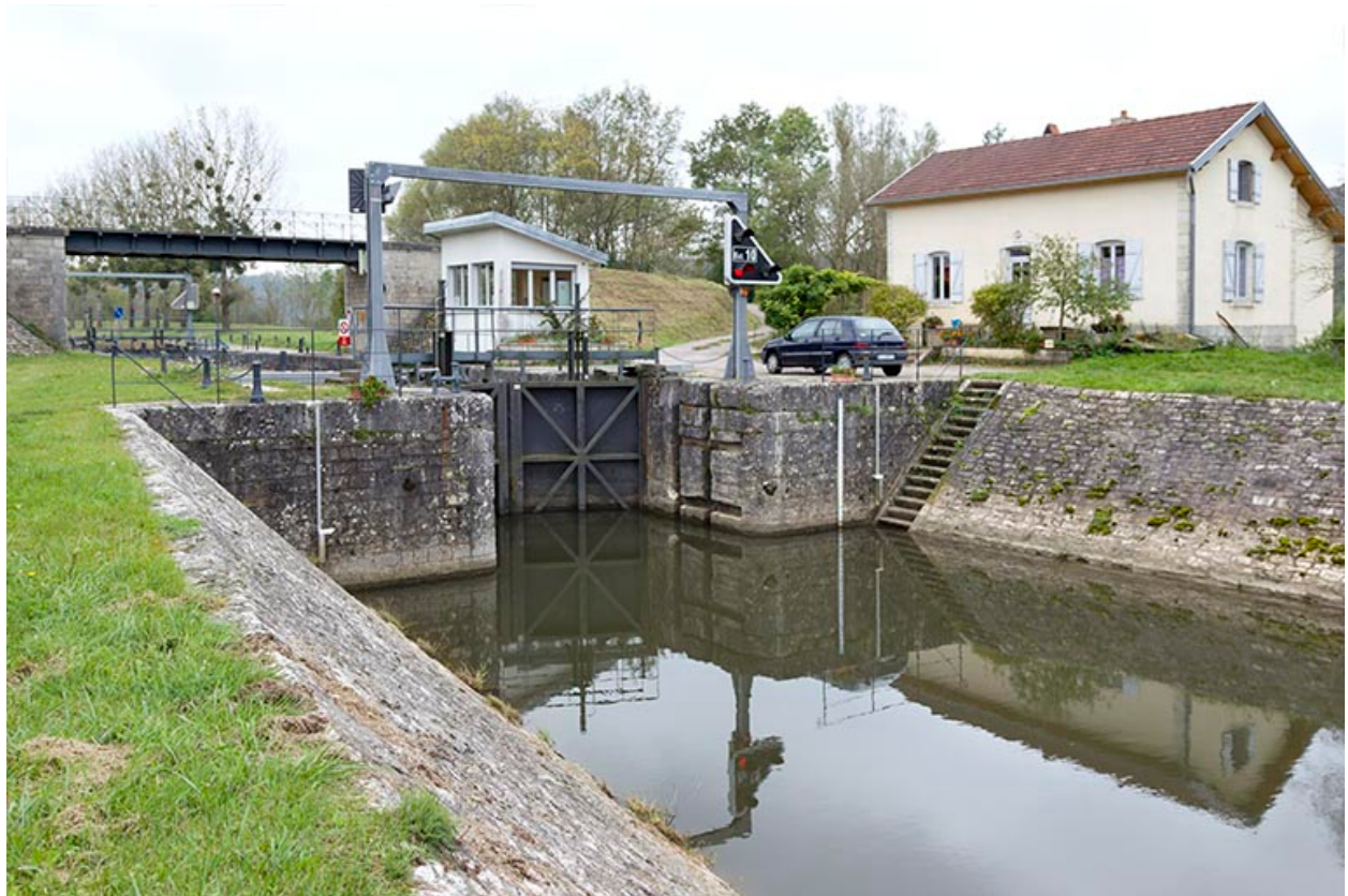
Vue aval de l'entrée du sas.
