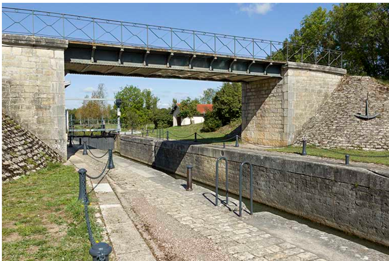
Le pont métallique au dessus de l'écluse.
