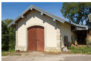
Le magasin attenant au site d'écluse. Phot. Sonia Dourlot IVR43_20157000816NUC2A
