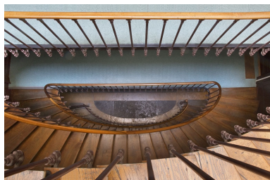
Intérieur, escalier : vue plongeante.
