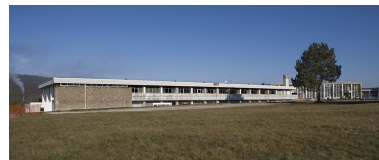
Vue d'ensemble : internat, externat. Phot. Yves Sancey IVR43_20063900428NUCA
