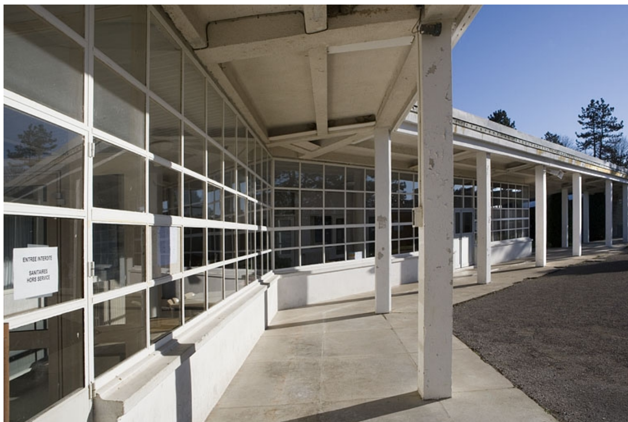
Façade de l'externat : détail
