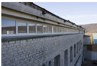
Façade : coursive intérieure, baies. Phot. Yves Sancey IVR43_20063900441NUCA
