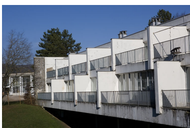
Logements : façades Phot. Yves Sancey
