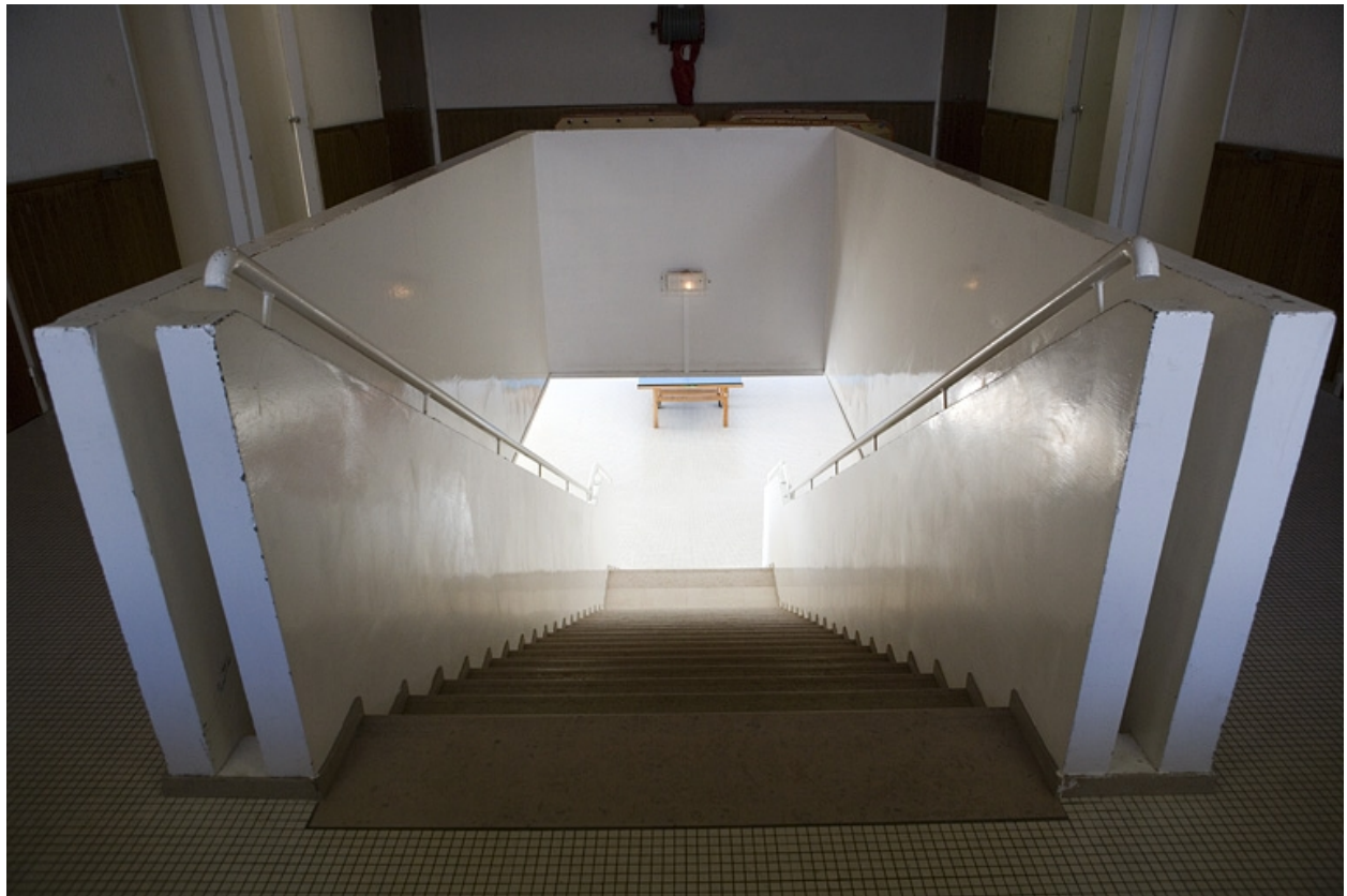
Escalier intérieur : la rampe béton.
