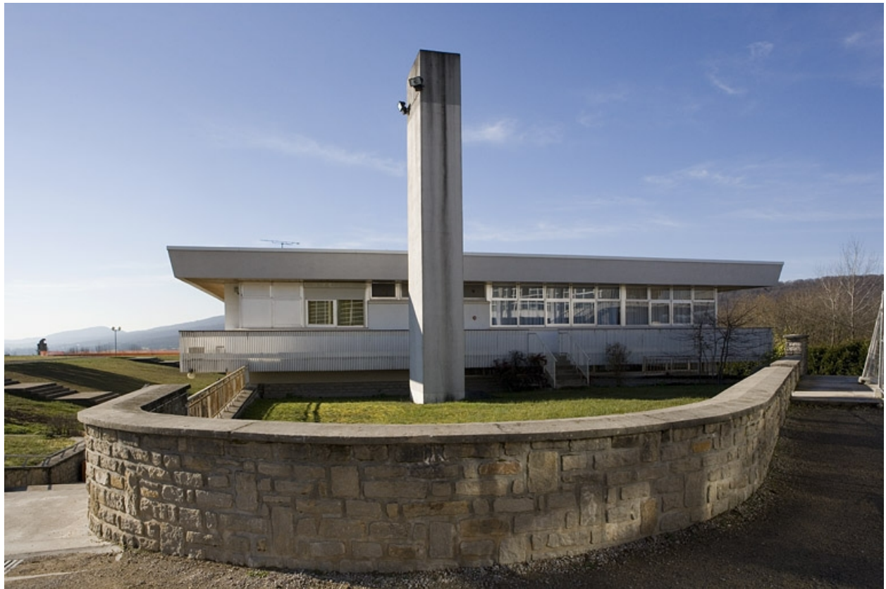
Angle du bâtiment d'internat.
