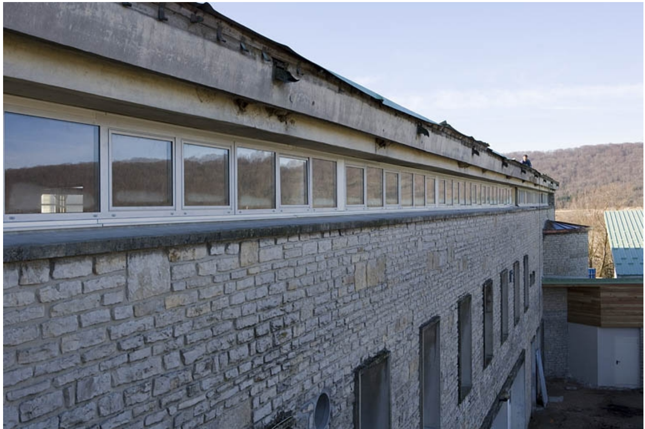
Façade : coursive intérieure, baies.
