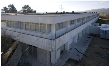
Internat : toit terrasse. Phot. Yves Sancey IVR43_20063900425NUCA
