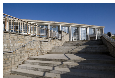
Escalier extérieur. Phot. Yves Sancey IVR43_20063900440NUCA
