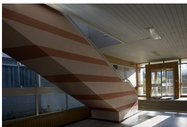
Escalier : traitement graphique du dessous d'escalier. Phot. Yves Sancey IVR43_20063900432NUCA
