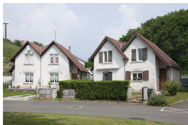
Cité du parc : ensemble de 2 maisons individuelles. Phot. Jérôme Mongreville IVR43_20122501017NUC4A
