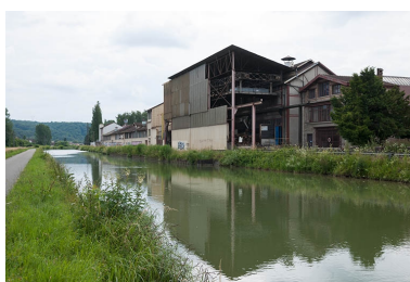
Vue d'ensemble depuis le canal. Phot. Jérôme Mongreville IVR43_20132501003NUC4A
