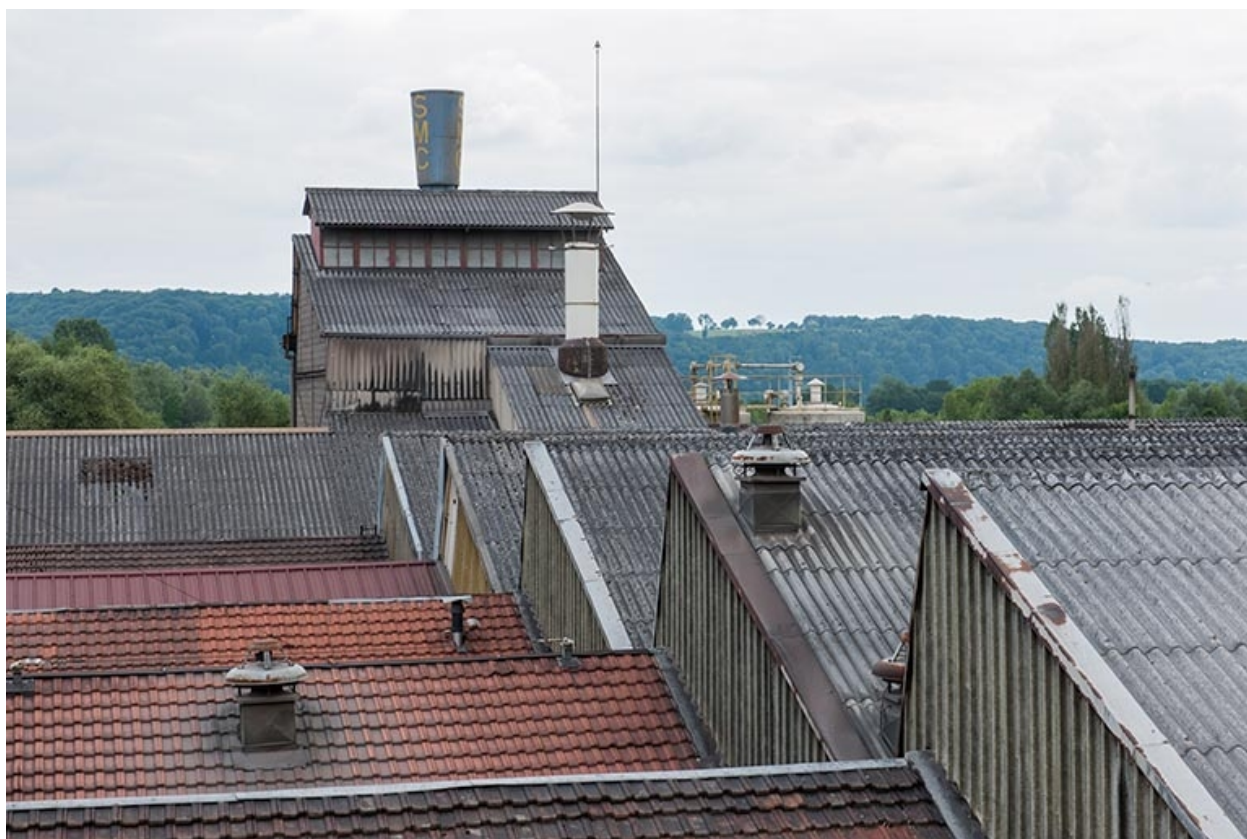
Toitures de l'usine.
