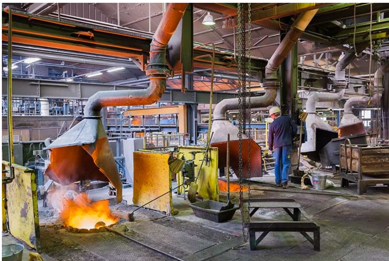
Partie supérieure des fours à induction.
