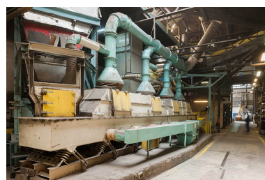
Refroidisseur à sable. Phot. Jérôme Mongreville IVR43_20132500977NUC4A
