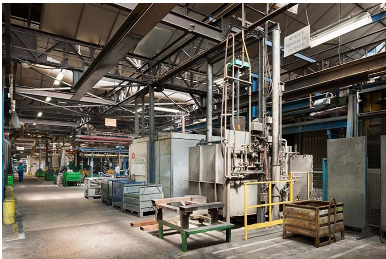
Vue d'ensemble. Four de traitement thermique.
