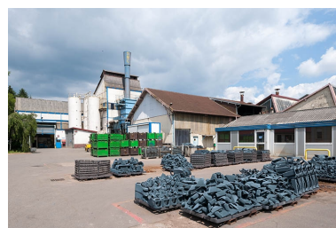
Vue de la cour depuis le sud-ouest. Phot. Jérôme Mongreville IVR43_20132500992NUC4A
