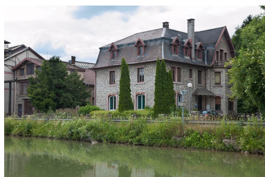
Demeure patronale (actuellement bureaux) vue depuis l'est. Phot. Jérôme Mongreville IVR43_20132501002NUC4A
