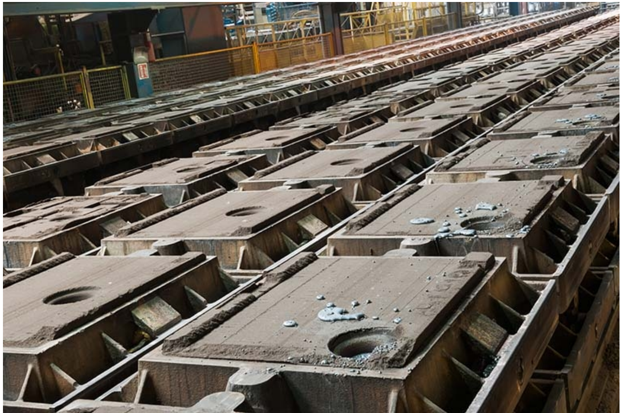
Ligne de moulage. Détail des moules (1).
