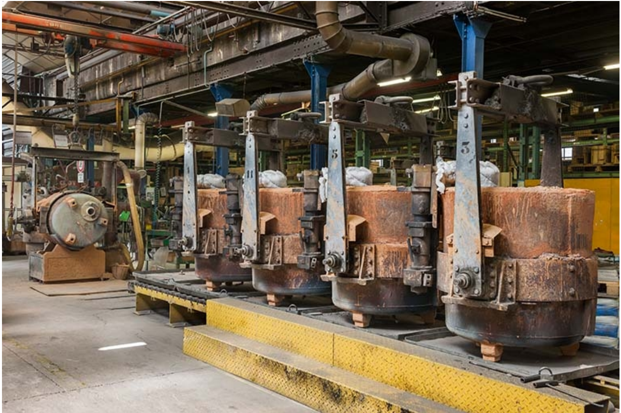
Poches de coulée avant réfection (1).
