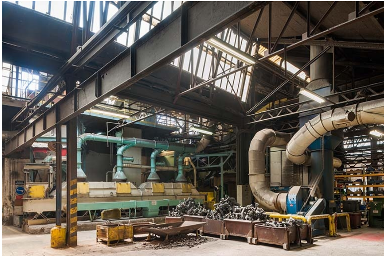
Vue d'ensemble. Ossature métallique.
