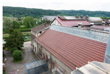
Vue plongeante sur l'ancien atelier de noyautage. Phot. Jérôme Mongreville IVR43_20132500997NUC4A
