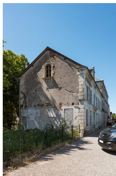
Mur pignon sud de la maison de Marien dit Georges Bigouret (emplacement du garage aujourd'hui détruit). Phot. Pierre-Marie Barbe-Richaud IVR26_20205800502NUC4A
