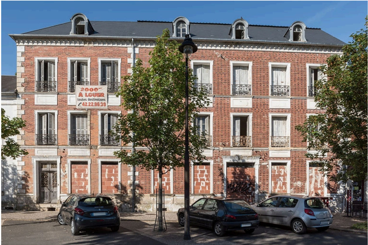
Façade de l'extension de Jules Guimard.
