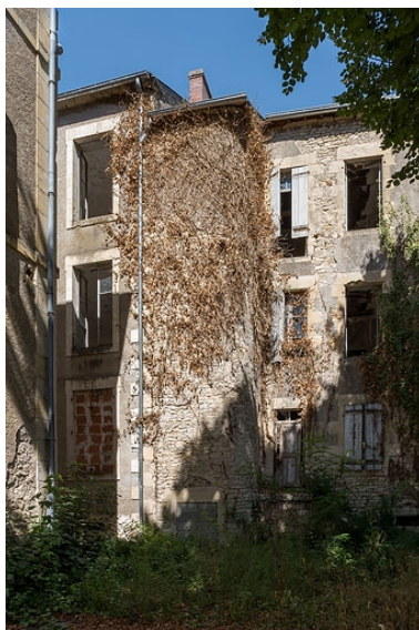
Façade sur la cour. Phot. Pierre-Marie Barbe-Richaud IVR26_20205800503NUC4A
