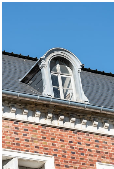
Façade de l'extension de Jules Guimard, lucarne. Phot. Pierre-Marie Barbe-Richaud IVR26_20205800500NUC4A
