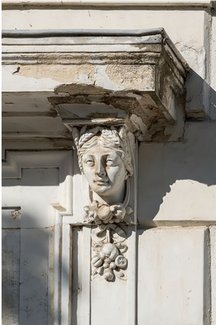
Façade de la maison de Marien dit Georges Bigouret, porte d'entrée, tête allégorique de l'été.
