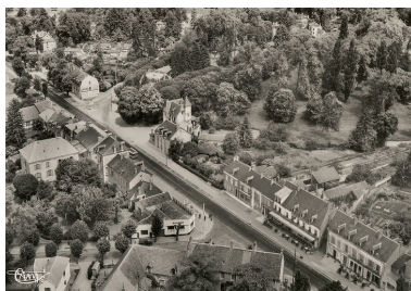
Vue aérienne (milieu du 20e siècle). Autr. auteur inconnu IVR26_20205800354NUC4A
