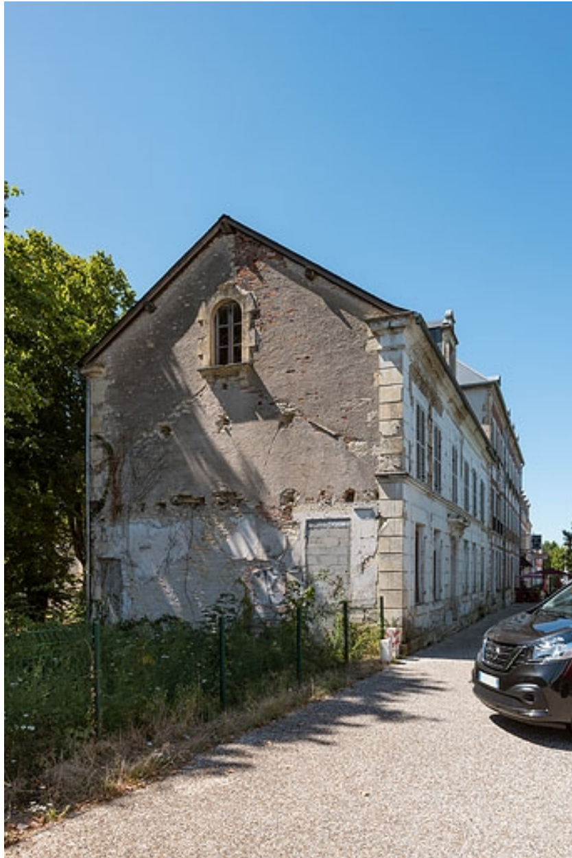
Mur pignon sud de la maison de Marien dit Georges Bigouret (emplacement du garage aujourd'hui détruit).
