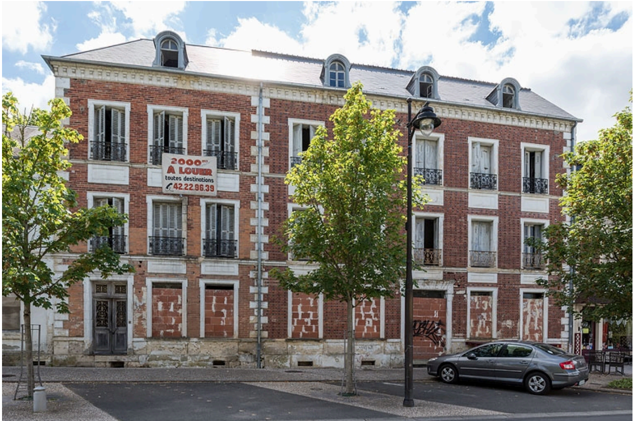
Façade de l'extension de Jules Guimard.
