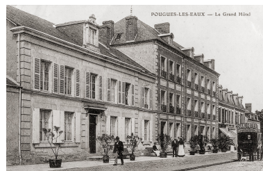
Vue ancienne d'ensemble, en direction de Paris. Phot. auteur inconnu IVR26_20195800770NUC4A
