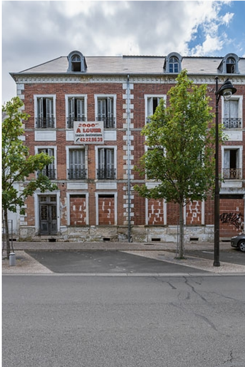
Façade de l'extension de Jules Guimard.
