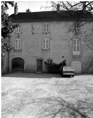
Elévation sur cour. Phot. Yves Sancey IVR43_19843900346X
