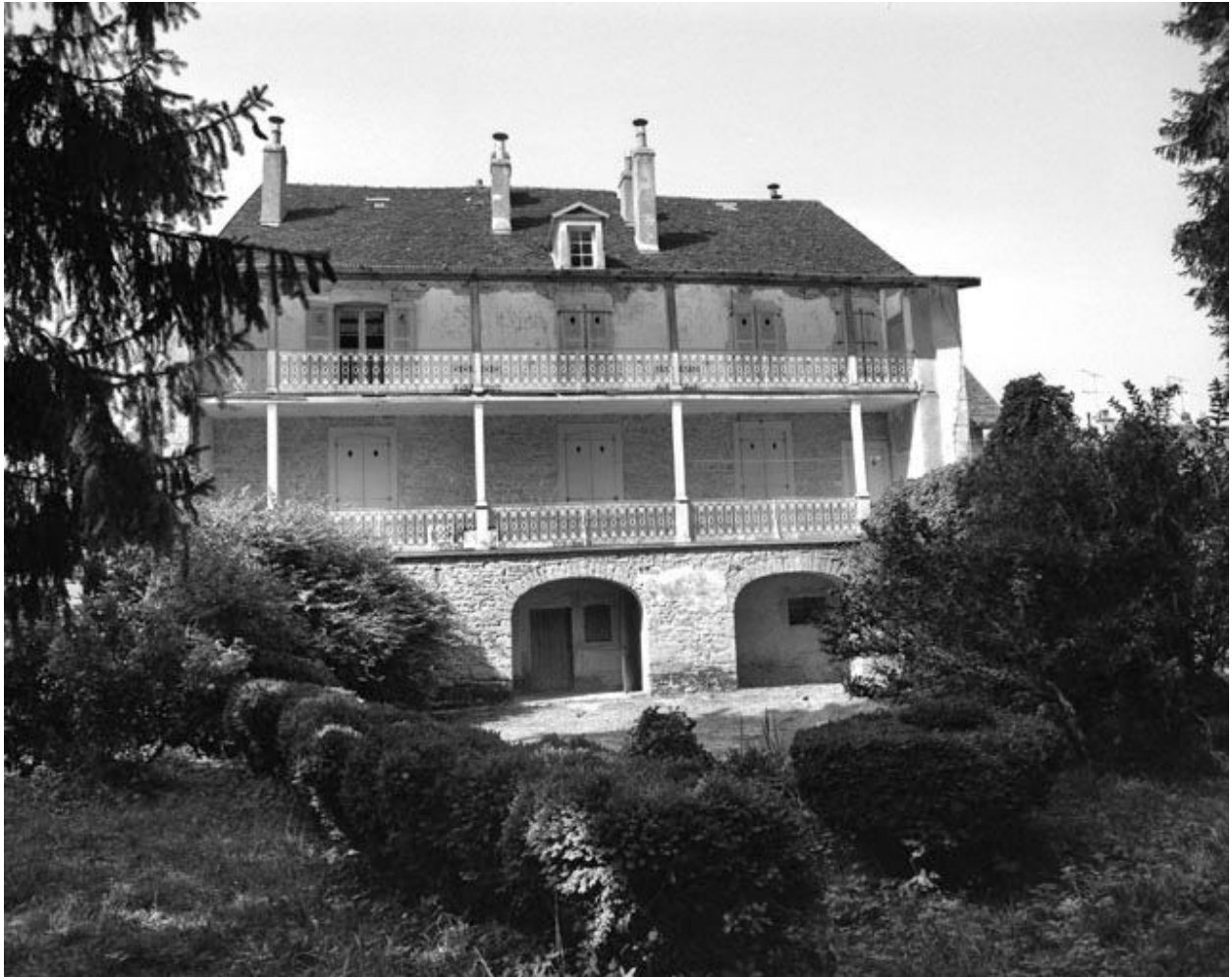
Façade postérieure vue de face.
