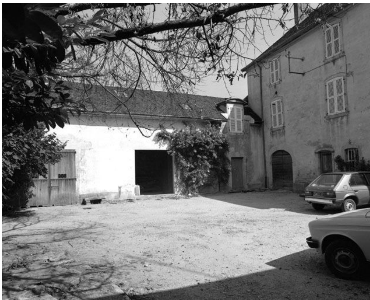
Bâtiment à gauche de la cour.
