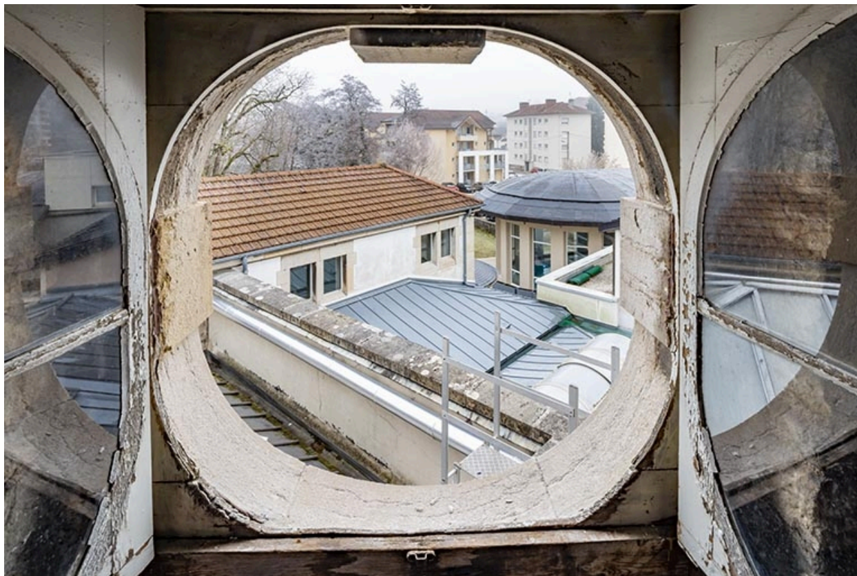
Comble au-dessus de l'ancienne salle d'attente, vue en direction de l'extension de 2007.
