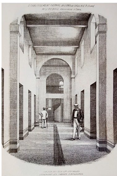
Galerie des Hommes (vers 1896). Phot. Fabien Dufoulon, Autr. auteur inconnu IVR43_20223900460NUC2A
