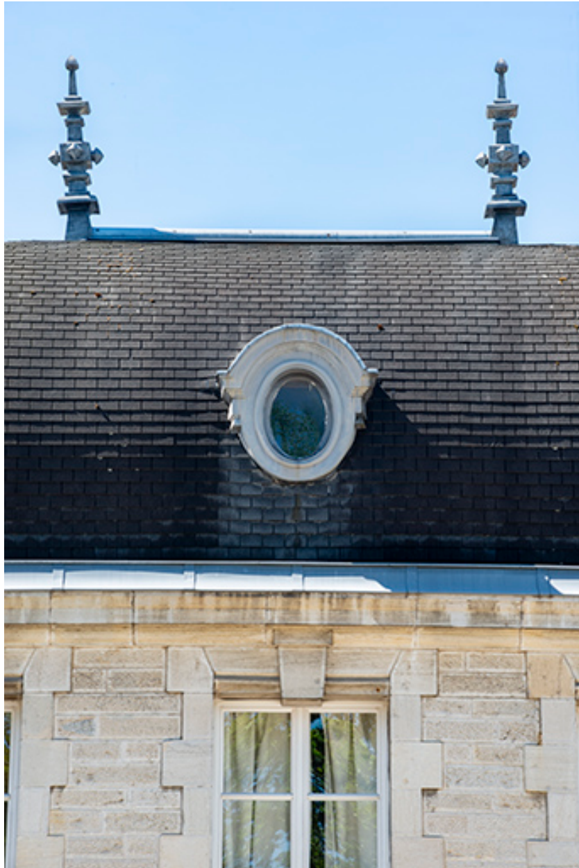
Façade principale, pavillon occidental, détail.
