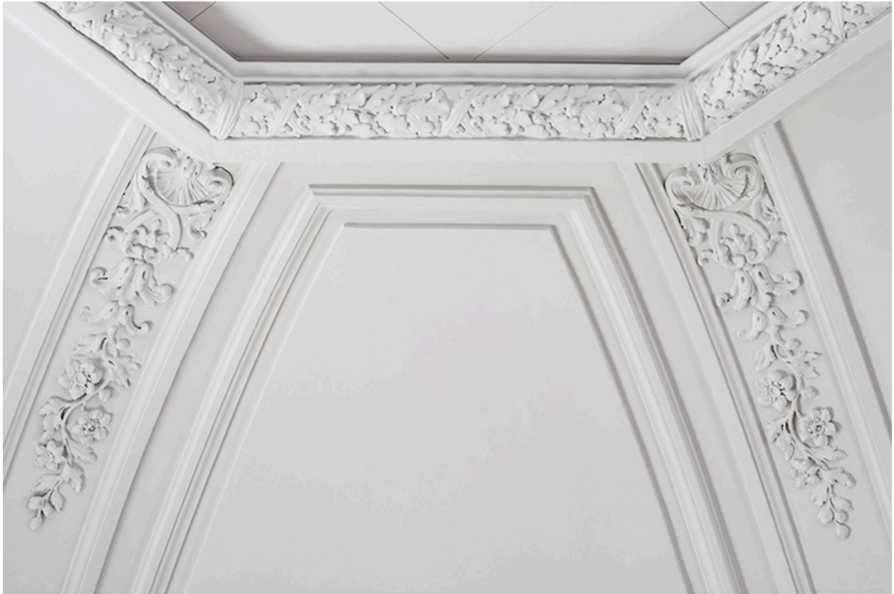
Salle de repos (ancienne salle d'attente), nervures du couvrement.
