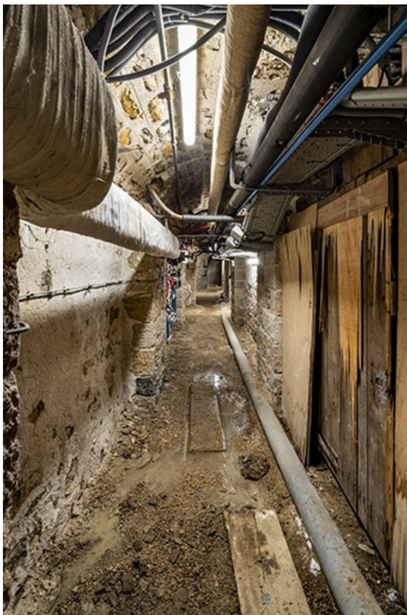
Galerie nord du sous-sol, sous le vestibule.
