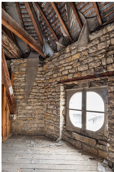
Comble au-dessus de l'ancienne salle d'attente. Phot. Jérôme Mongreville IVR43_20223900078NUC4A
