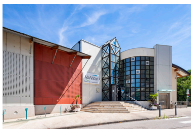
Piscine de l'extension de 1983 (à gauche). Phot. Jérôme Mongreville IVR43_202239000767NUC4A
