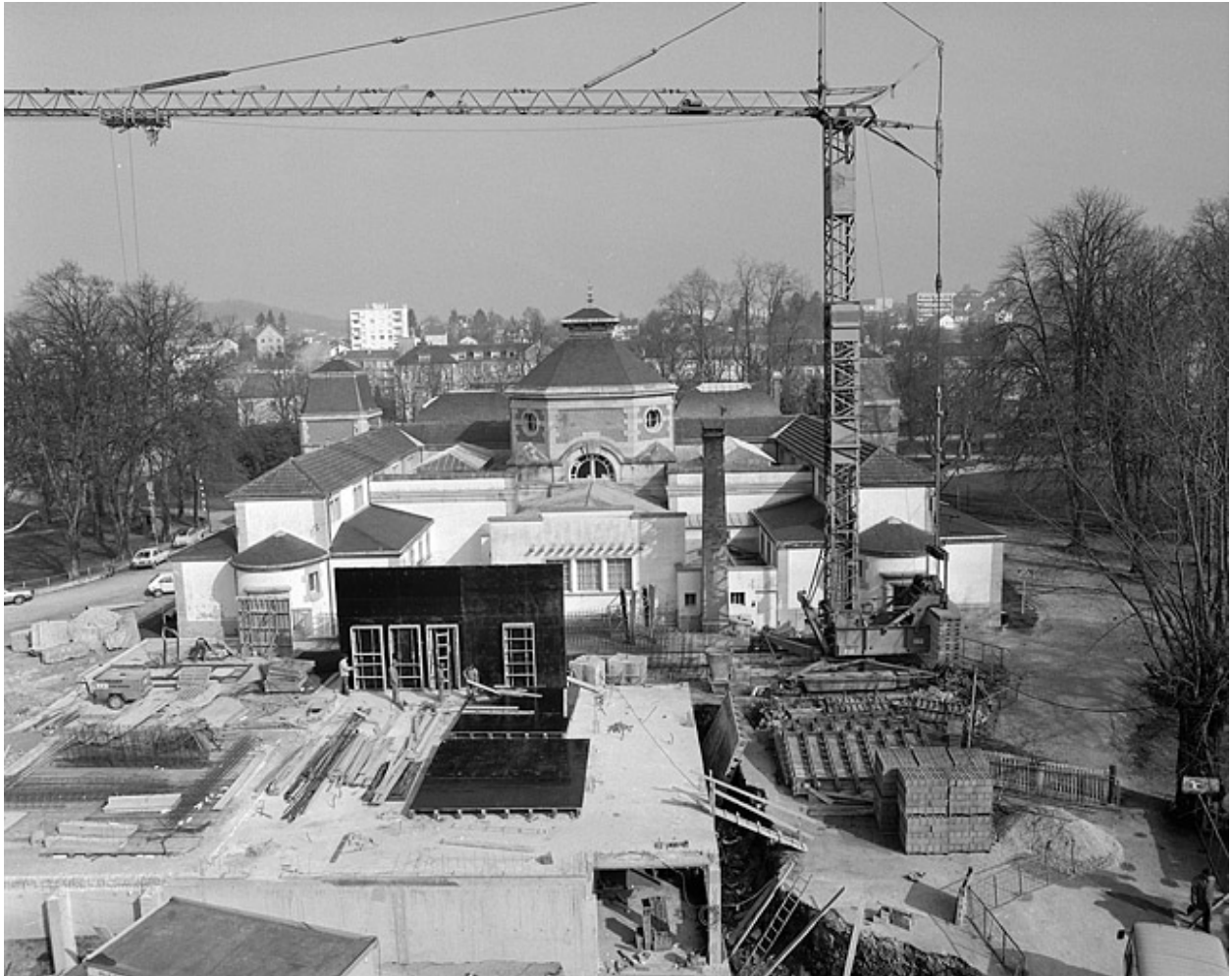
Travaux d'agrandissement, photographie prise en 1983.
