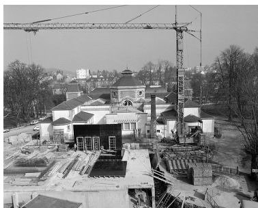
Travaux d'agrandissement, photographie prise en 1983. Phot. Yves Sancey IVR43_19833900094X
