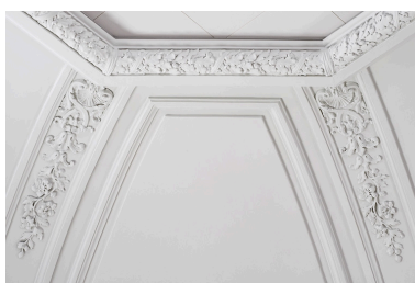
Salle de repos (ancienne salle d'attente), nervures du couvrement. Phot. Jérôme Mongreville IVR43_20223900009NUC4A
