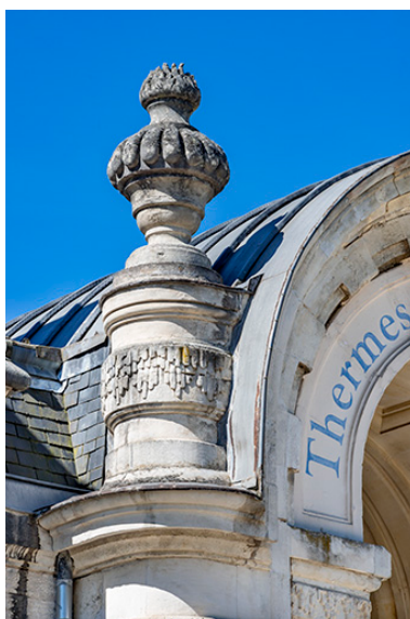
Façade principale, portail, détail. Phot. Jérôme Mongreville IVR43_20223900761NUC4A
