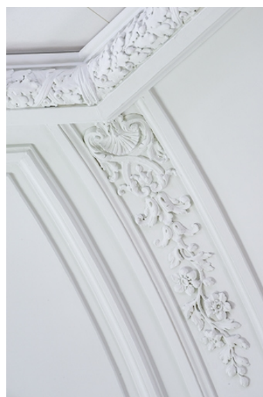
Salle de repos (ancienne salle d'attente), nervure du couvrement. Phot. Jérôme Mongreville IVR43_20223900010NUC4A
