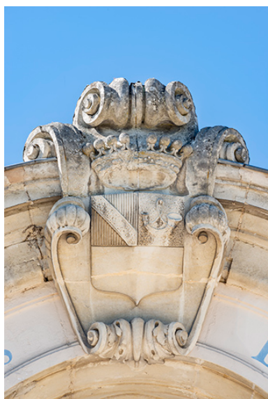
Façade principale, portail, détail. Phot. Jérôme Mongreville IVR43_20223900753NUC4A
