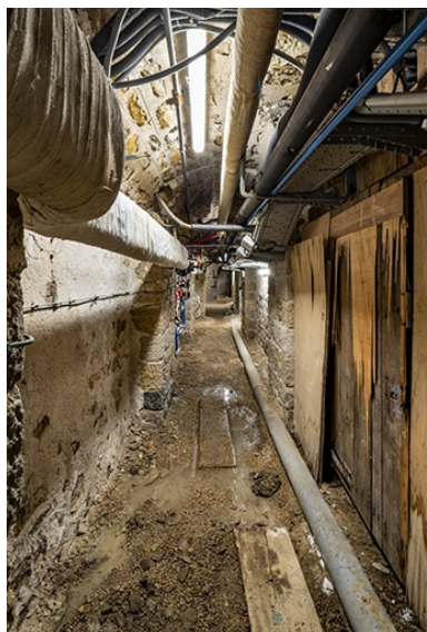
Galerie nord du sous-sol, sous le vestibule. Phot. Jérôme Mongreville IVR43_20223900034NUC4A
