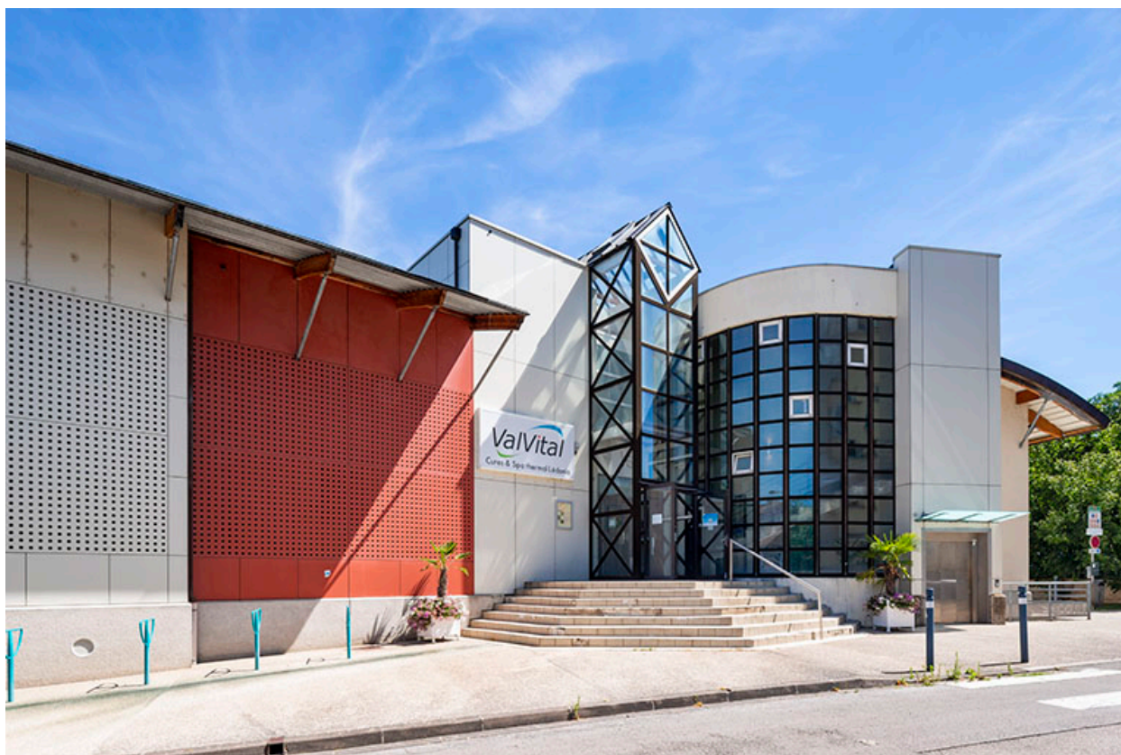
Piscine de l'extension de 1983 (à gauche).
