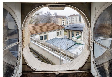
Comble au-dessus de l'ancienne salle d'attente, vue en direction de l'extension de 2007. Phot. Jérôme Mongreville IVR43_20223900076NUC4A
