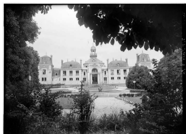
Façade principale (première moitié du 20e siècle). Phot. Jules Manias IVR43_20063900143P
