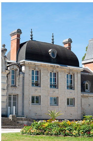
Façade principale, pavillon occidental. Phot. Jérôme Mongreville IVR43_20223900745NUC4A
