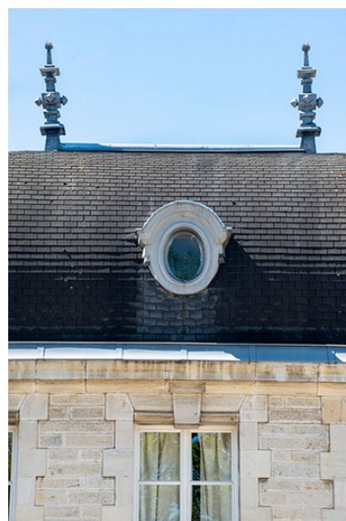
Façade principale, pavillon occidental, détail. Phot. Jérôme Mongreville IVR43_20223900757NUC4A
