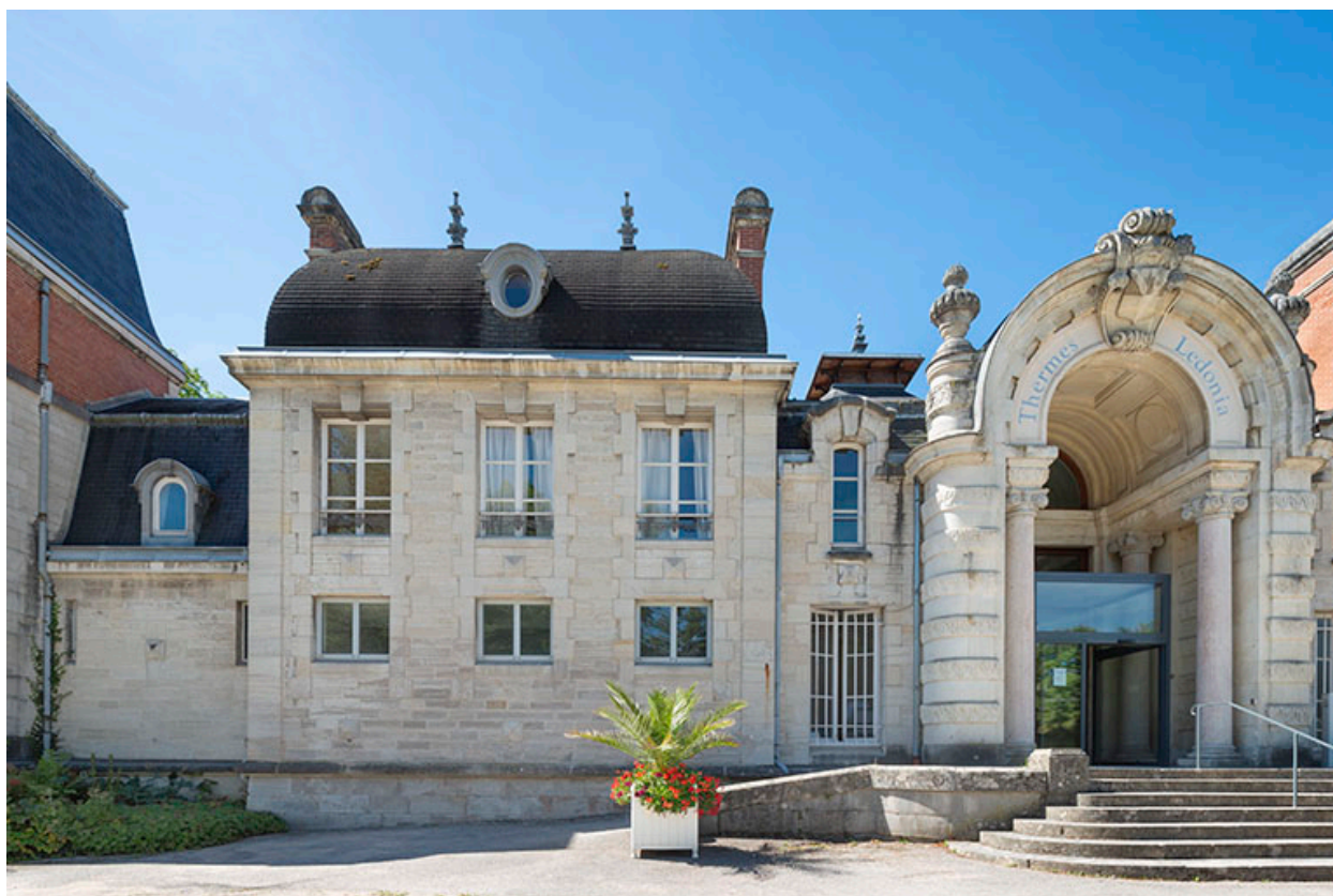
Façade principale, pavillon oriental.
