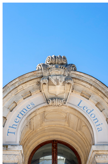
Façade principale, portail, détail. Phot. Jérôme Mongreville IVR43_20223900754NUC4A
