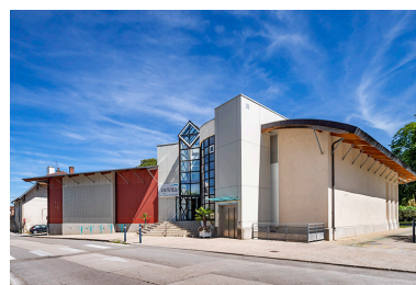
Piscine de l'extension de 2007 (à droite). Phot. Jérôme Mongreville IVR43_20223900764NUC4A
