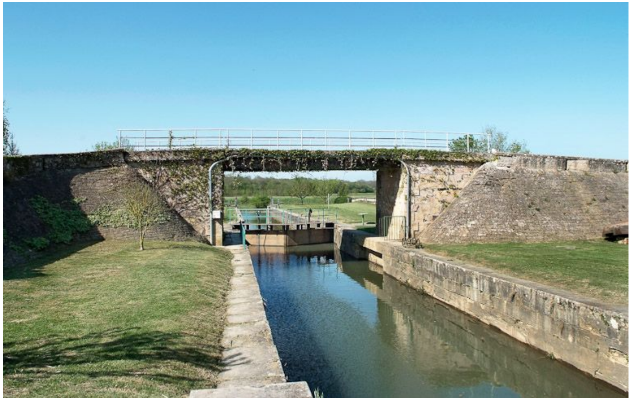
Vue d'ensemble du site d'écluse de La Truchère : pont sur écluse.
