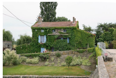
Le site d'écluse de La Truchère : le sas. A l'arrière-plan, la maison éclésièrè. Phot. Jean-Luc Duthu IVR26_20120100005NUC2A
