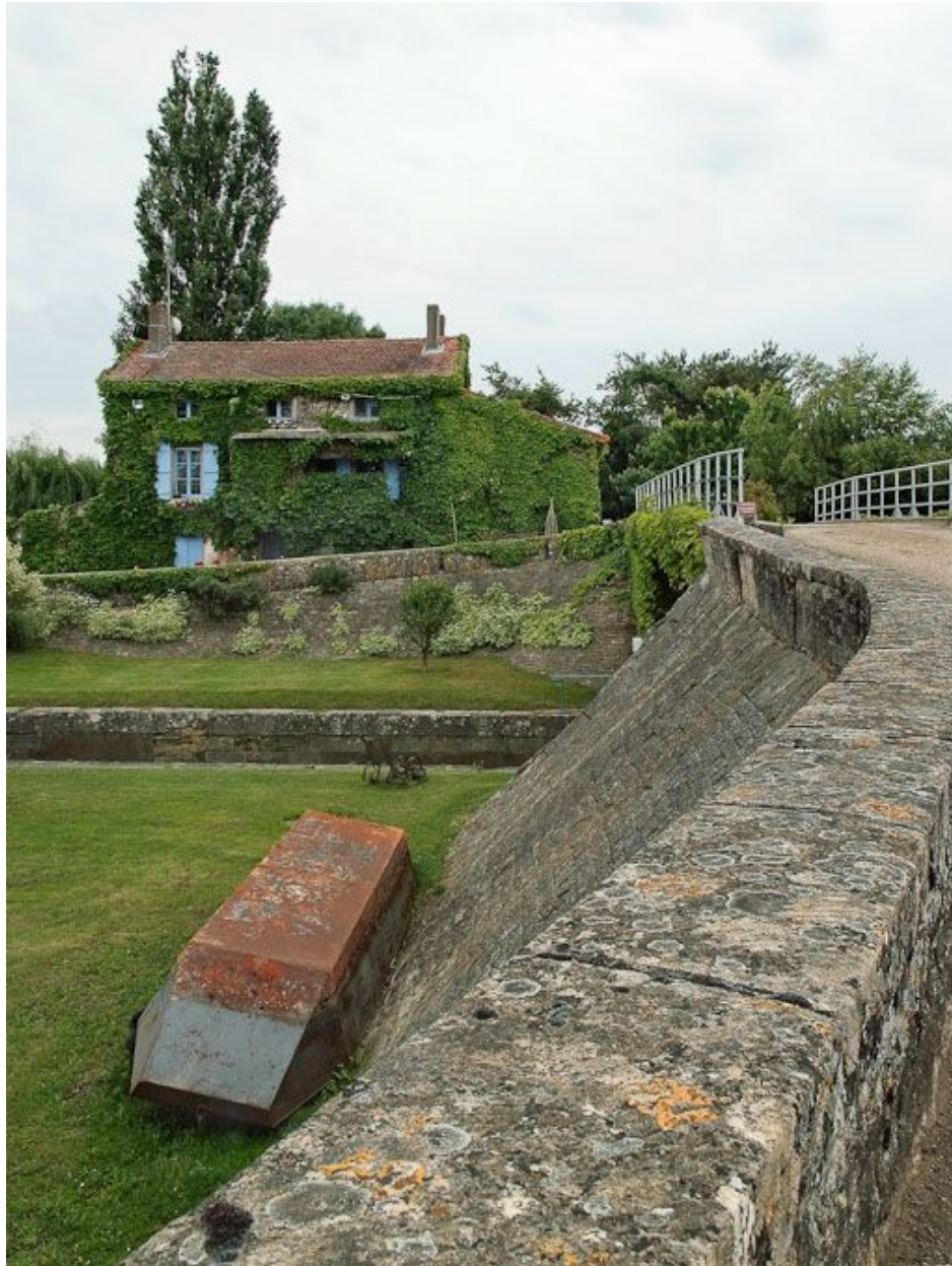
Le site d'écluse de La Truchère : digue avec allège, pont sur écluse, la maison éclusière en fond.
