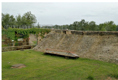
Le site d'écluse de La Truchère : digue avec allège, pont sur écluse. Phot. Jean-Luc Duthu IVR26_20120100007NUC2A
