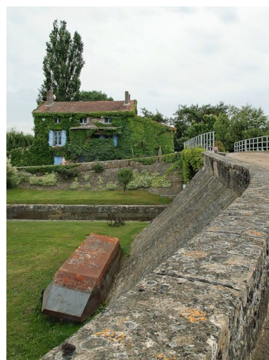
Le site d'écluse de La Truchère : digue avec allège, pont sur écluse, la maison éclésièrè en fond. Phot. Jean-Luc Duthu IVR26_20120100008NUC2A
