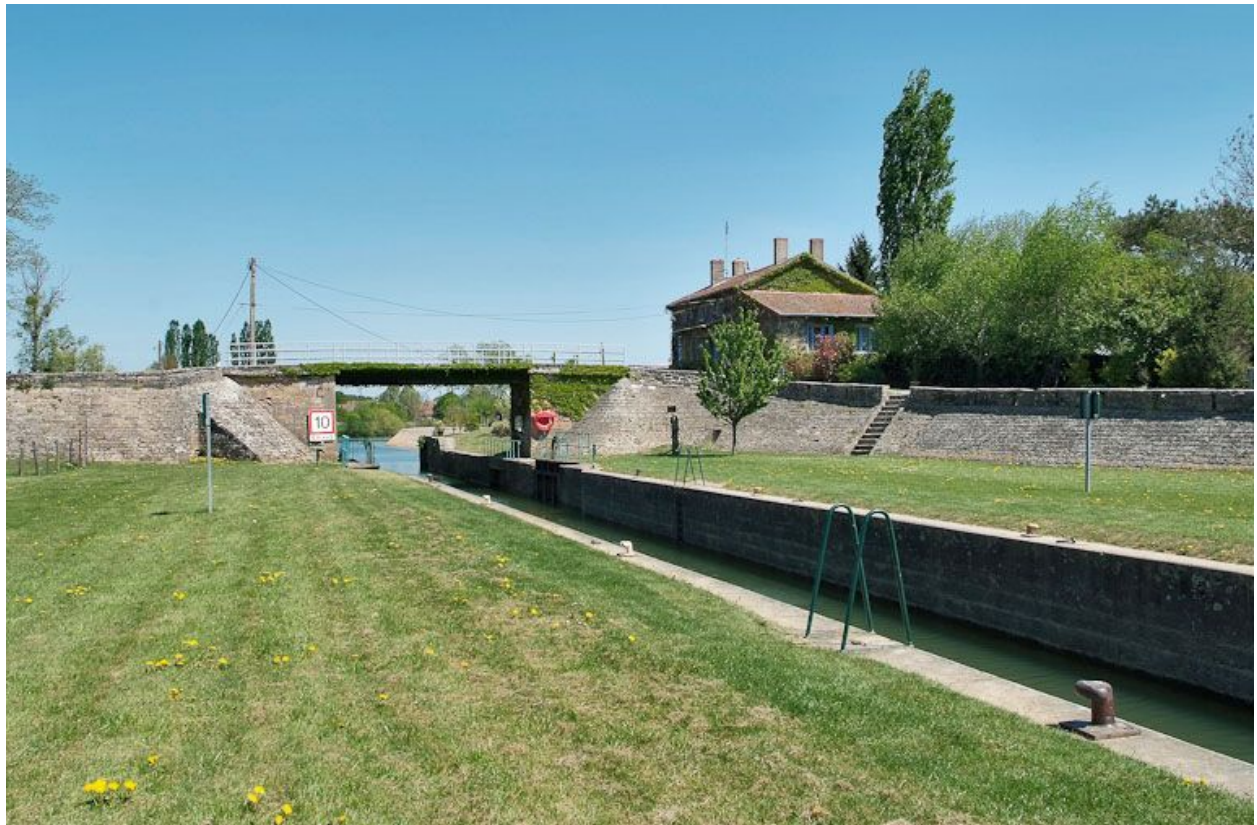
Le sas d'écluse de La Truchère.
