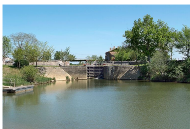
Vue d'ensemble du site d'écluse de La Truchère. Phot. Jean-Luc Duthu IVR26_20107100524NUC2A
