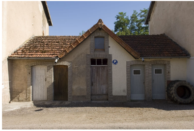
Dépendances communes aux logements ouvriers. Phot. Jérôme Mongreville IVR43_20067000583NUCA
