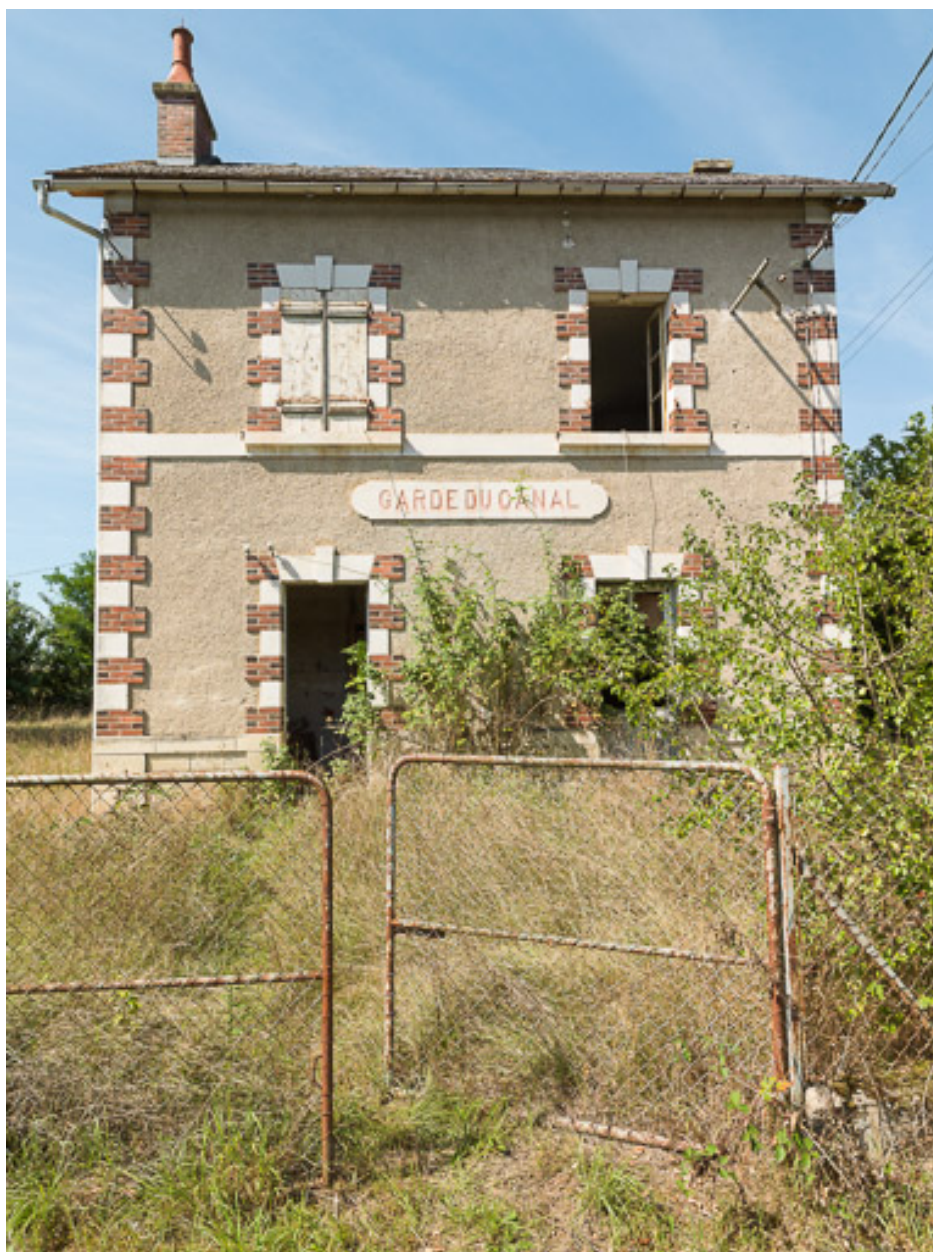
Vue d'une maison de barragiste.
