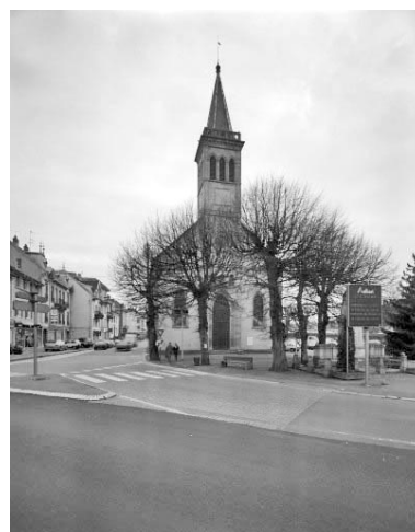
Vue d'ensemble. Phot. Jérôme Mongreville IVR43_19912500050V
