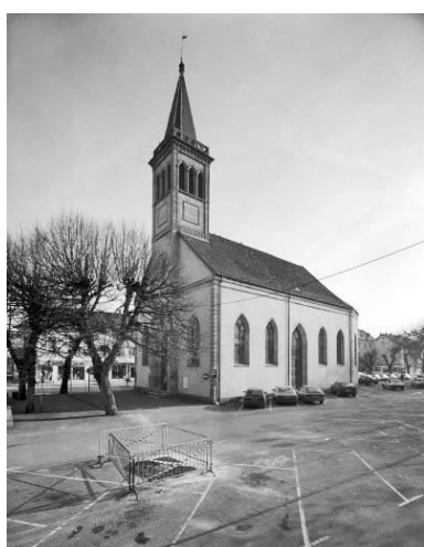
Vue d'ensemble de trois quarts droit. Phot. Jérôme Mongreville IVR43_19912500051V
