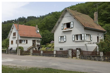
Maisons de la cité ouvrière. Phot. Jérôme Mongreville IVR43_20067000518NUCA
