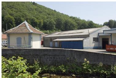
Conciergerie et magasin industriel. Phot. Jérôme Mongreville IVR43_20067000517NUCA
