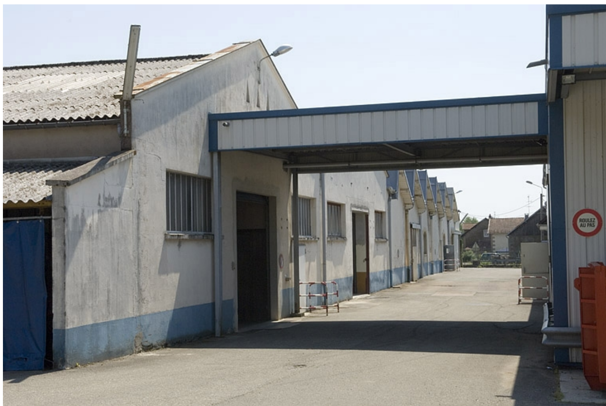
Pignons de l'atelier de fabrication.
