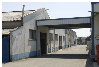
Pignons de l'atelier de fabrication.
