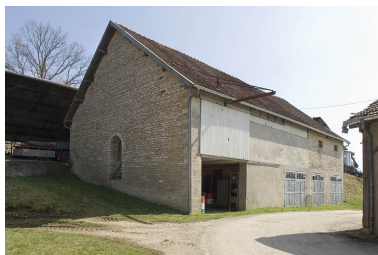
Bâtiment des écuries, granges et remises. Phot. Jérôme Mongreville IVR43_20097000585NUC2A
