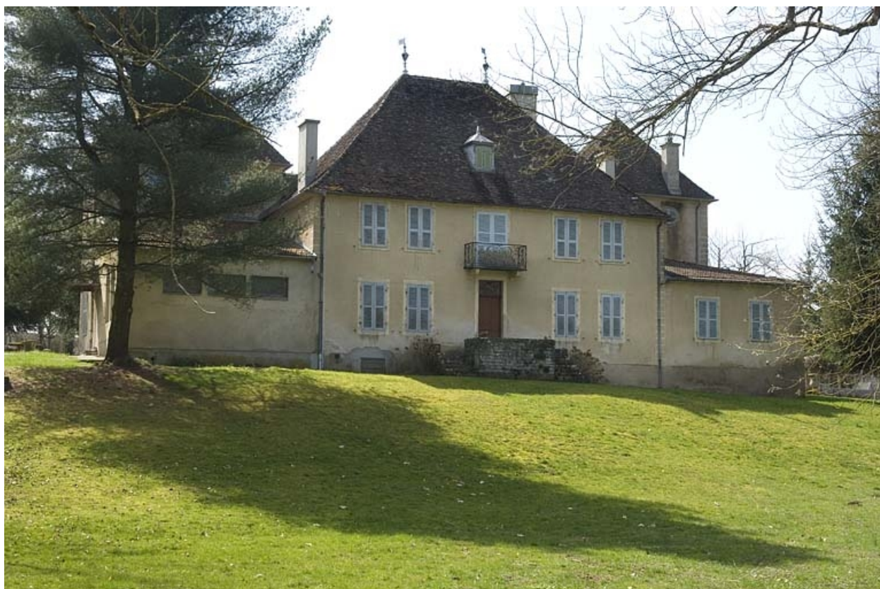
Façade postérieure du logement patronal.
