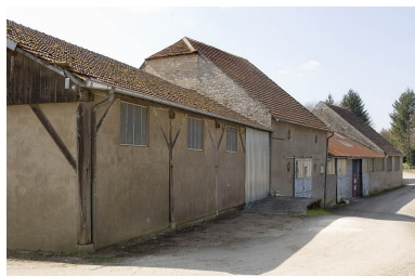
Façade nord de l'ancienne halle à charbon. Phot. Jérôme Mongreville IVR43_20097000584NUC2A
