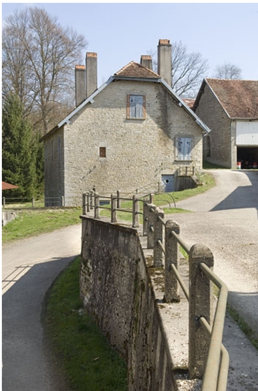
Logement ouvrier depuis la passerelle.
