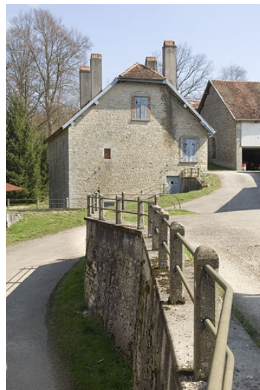
Logement ouvrier depuis la passerelle. Phot. Jérôme Mongreville IVR43_20097000582NUC2A
