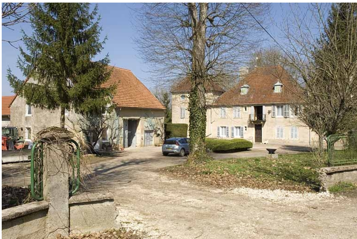
Le logement patronal et ses dépendances.
