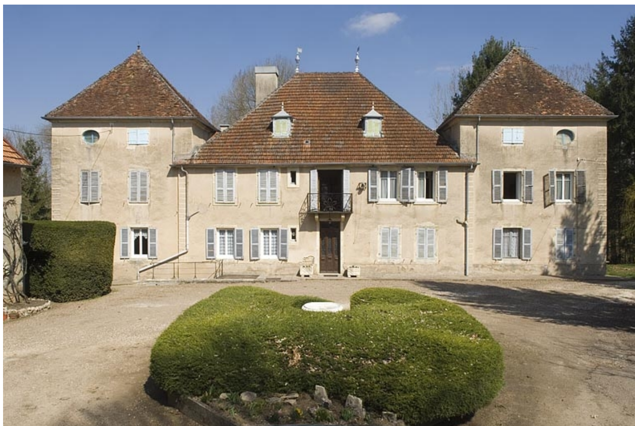
Façade antérieure du logement patronal.
