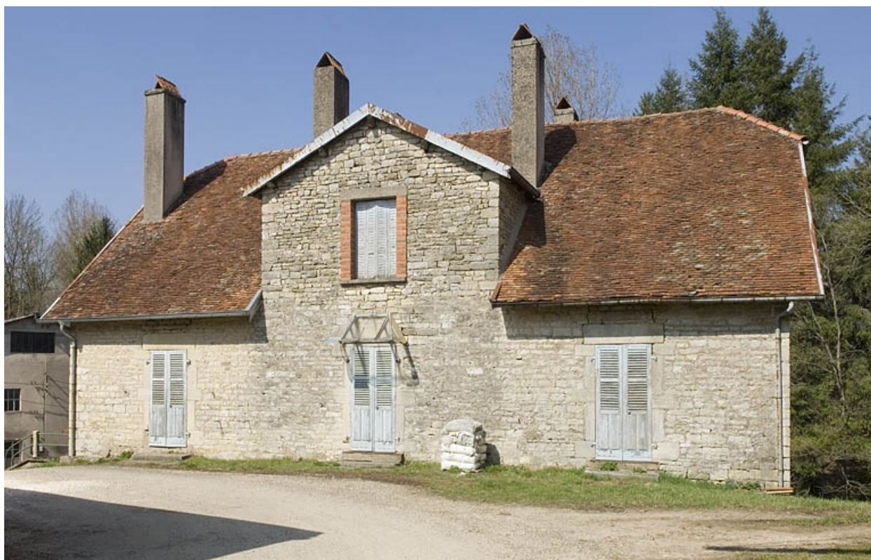
Façade sud du logement ouvrier.
