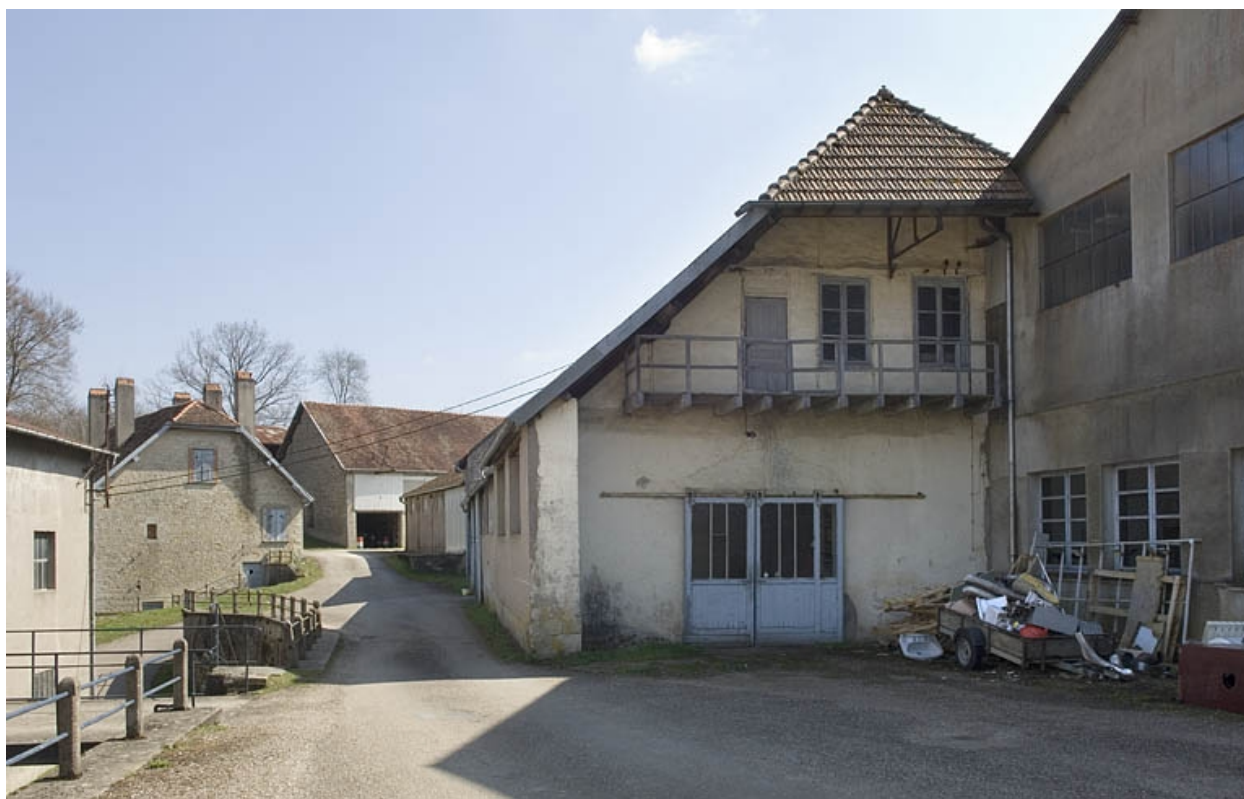
Bâtiments industriels vus depuis l'ouest.
