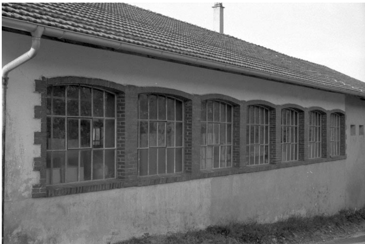
Fenêtres de la façade latérale droite.
