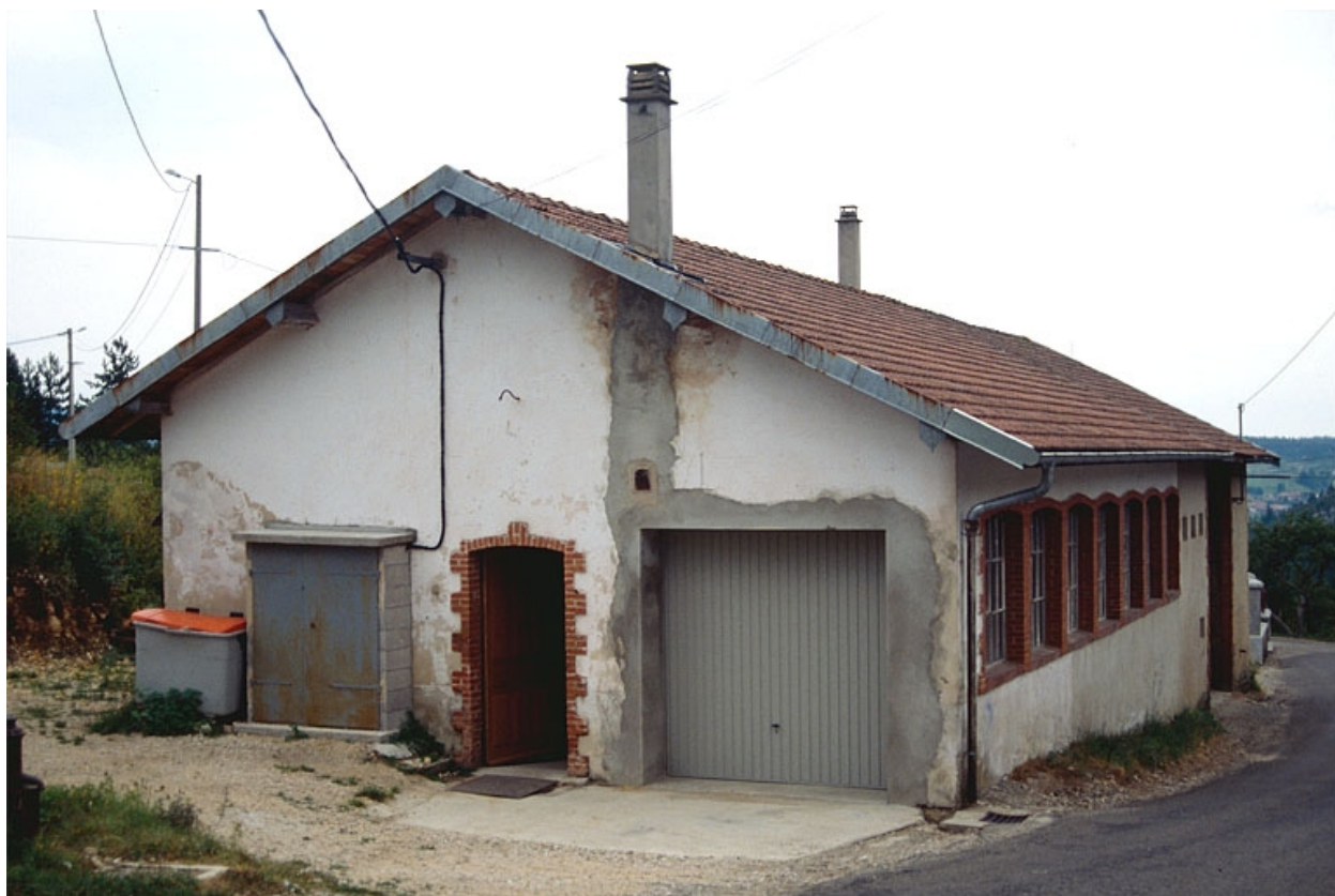
Façades antérieure et latérale droite.
