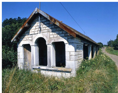
Façade latérale gauche. Phot. Yves Sancey IVR43_19857000144XA
