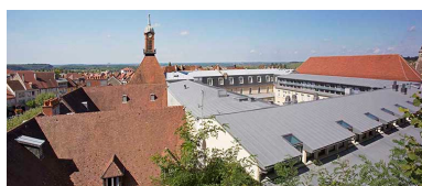
Toitures et élévations sous toitures.
