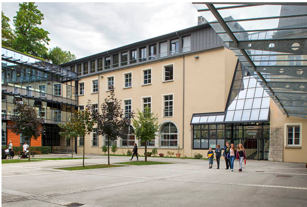
Aile Sud : détail.
