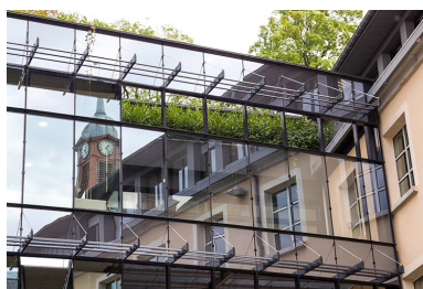
Aile Est : partie supérieure vitrée. Phot. Sonia Dourlot IVR43_20143900705NUC2A
