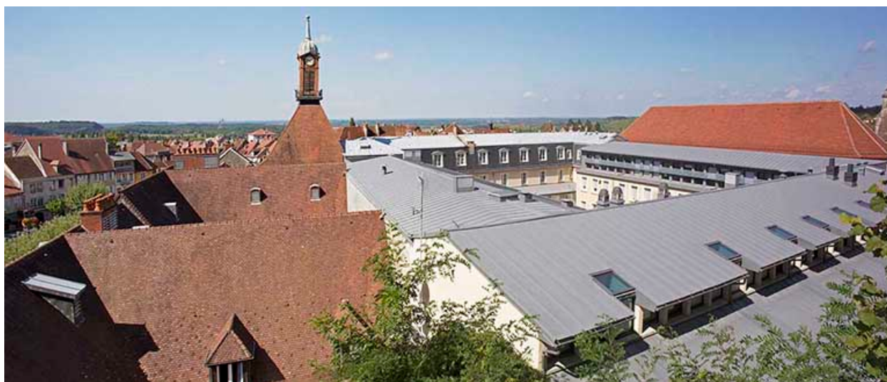
Toitures et élévations sous toitures.
