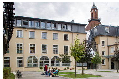
Aile Sud : façade sur cour, derrière sur la façade postérieure du hall d'entrée de la place des déportés. Phot. Sonia Dourlot IVR43_20143900709NUC2A
