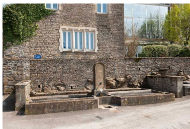
Vue générale. Phot. Jérôme Mongreville IVR43_20102500396NUC4A
