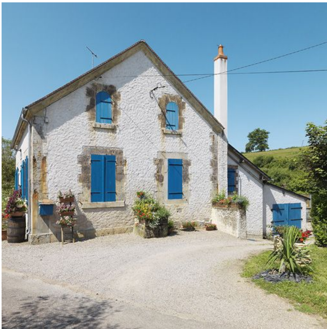
Façade latérale de la maison éclusière.
