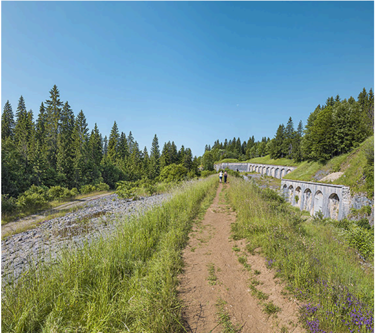
Fort des Rousses : front nord-ouest (de gauche à droite : le glacis, le fossé et le mur d'escarpe).
