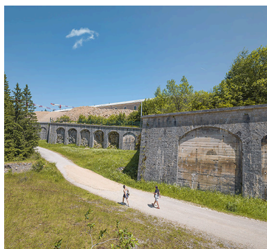
Fort des Rousses : front ouest (en contrebas de la caserne Saint-Germain). IVR43_20253900413NUC4A
