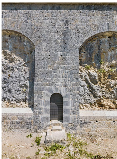
Fort des Rousses : poterne située au front sud-ouest. IVR43_20253900405NUC4A
