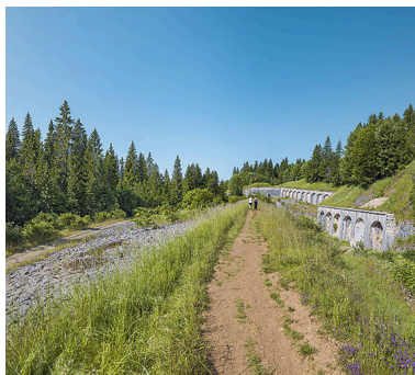
Fort des Rousses : front nord- ouest (de gauche à droite : le glacis, le fossé et le mur d'escarpe). IVR43_20253900388NUC4A
