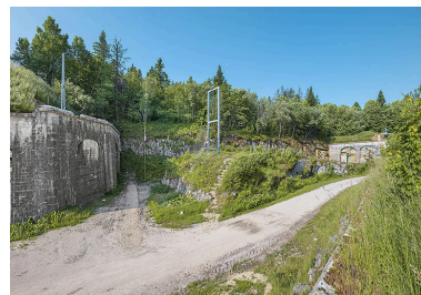
Fort des Rousses : tenaille défendant l'accès à la porte de France. IVR43_20253900398NUC4A
