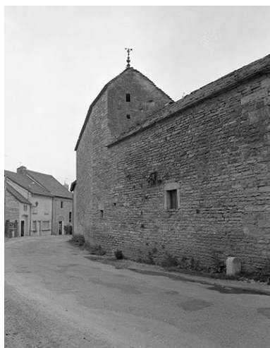
Dépendances : élévation sur rue. Phot. Yves Sancey IVR43_19813900058X
