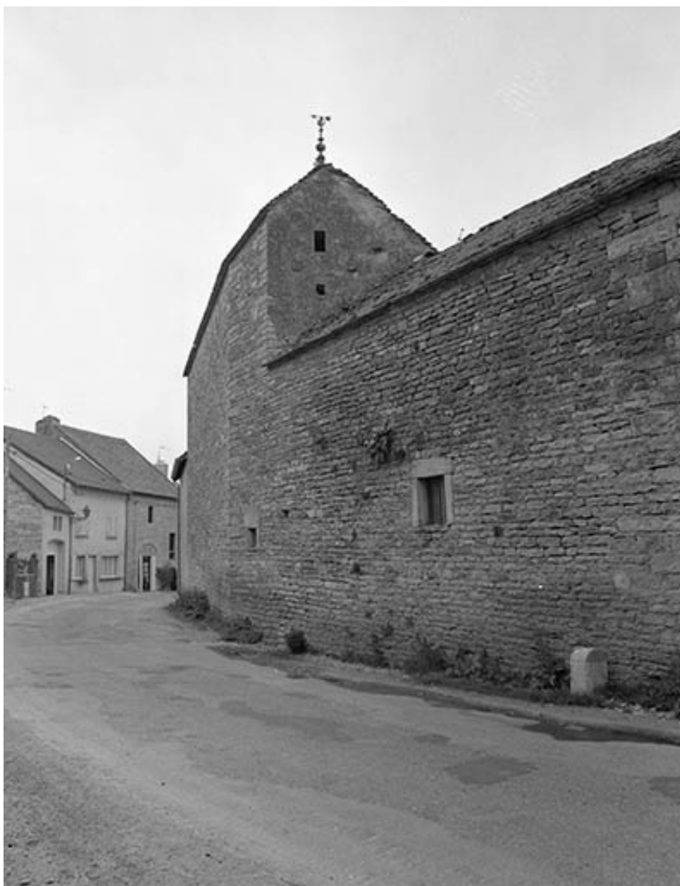
Dépendances : élévation sur rue.
