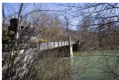
Vue en enfilade, depuis la rive gauche en amont. Phot. Yves Sancey IVR43_20073900072NUCA
