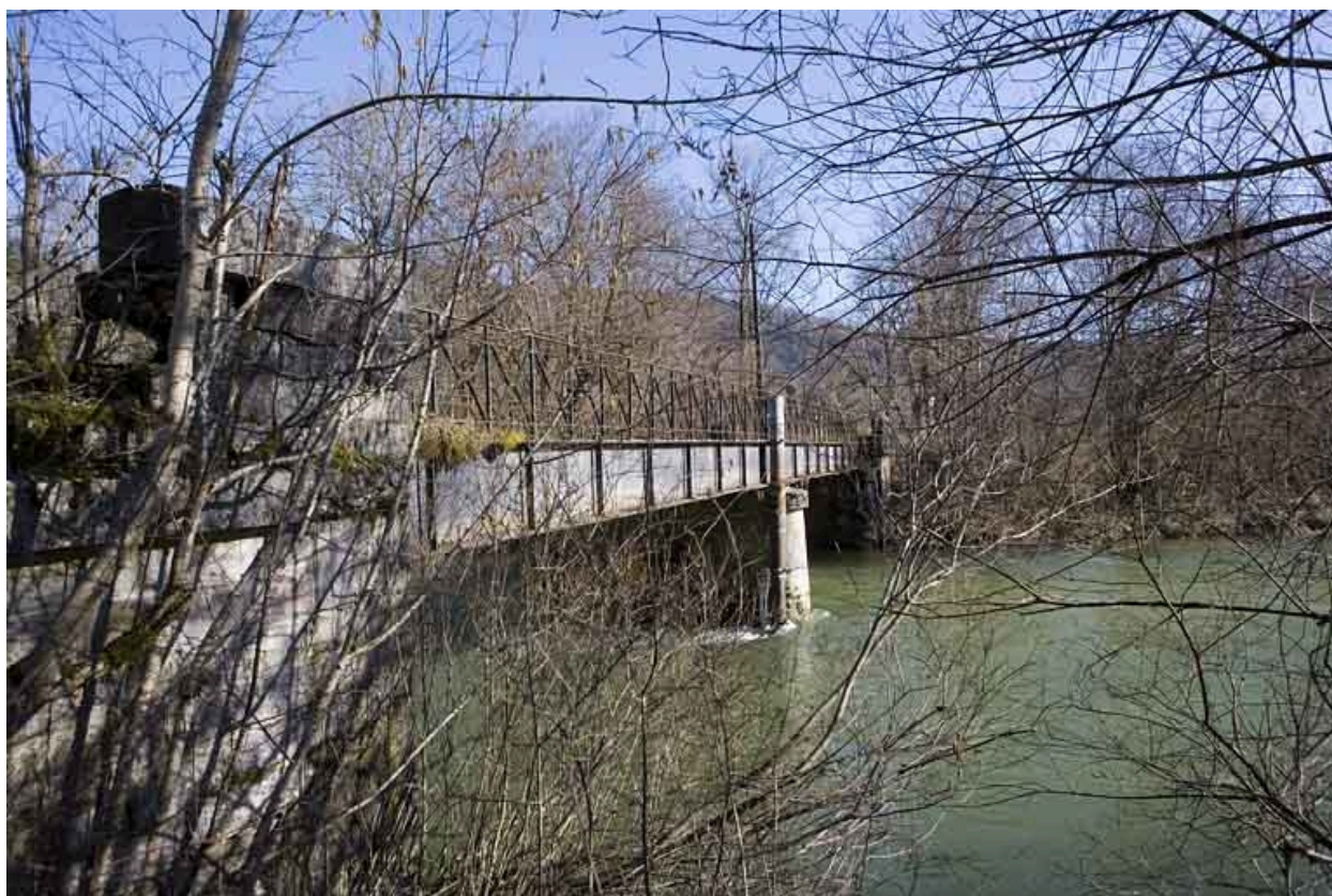
Vue en enfilade, depuis la rive gauche en amont.
