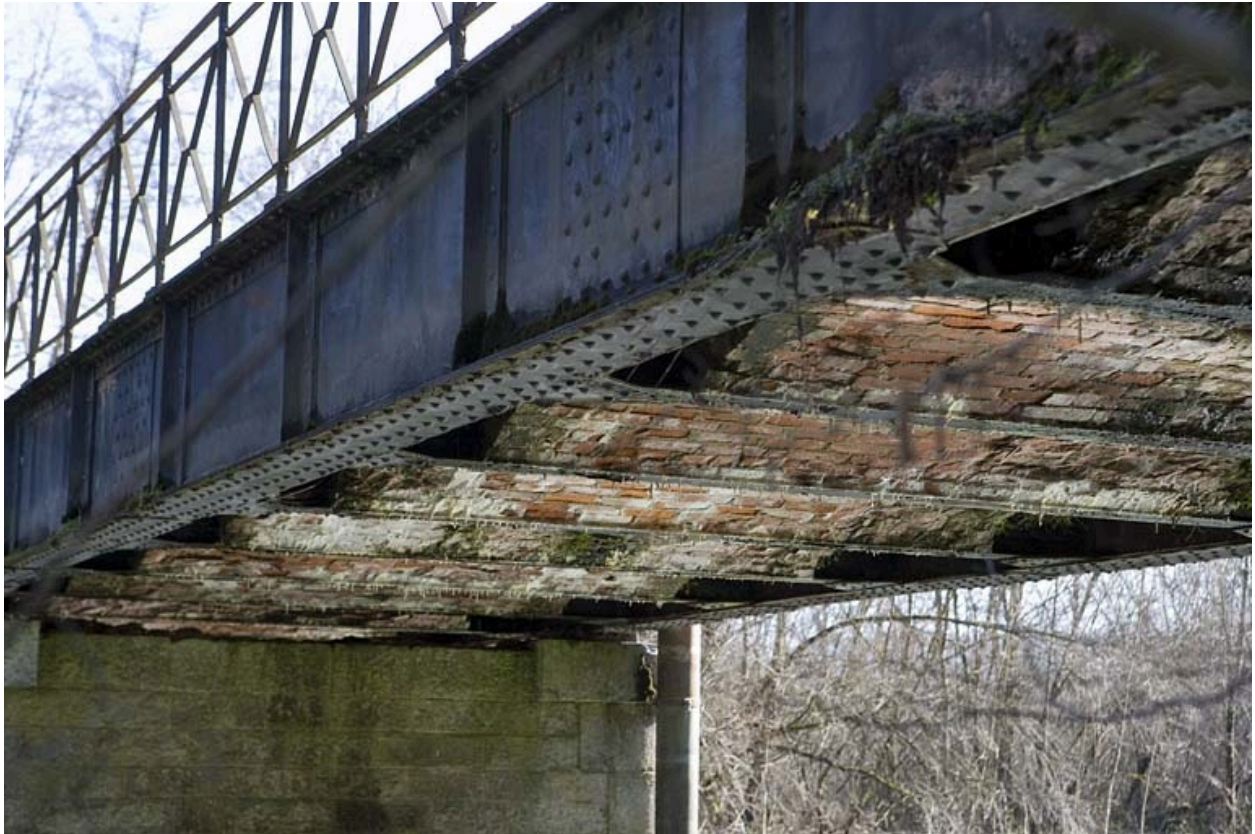
Voûtains en face inférieure du tablier.
