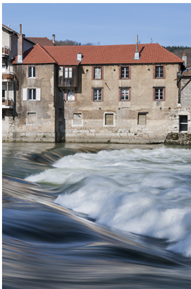
Façade est de l'atelier de menuiserie. Phot. Jérôme Mongreville IVR43_20132500144NUC4A
