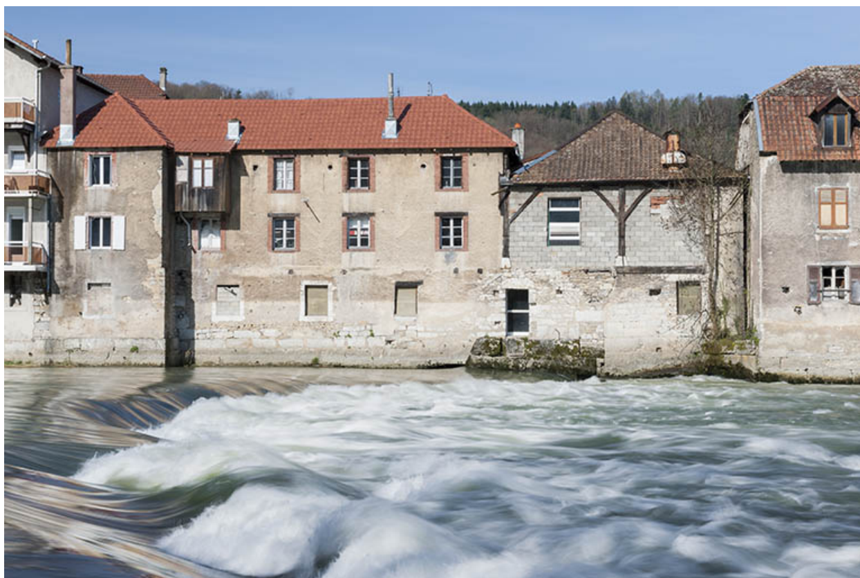
Façade sur le Doubs des ateliers.
