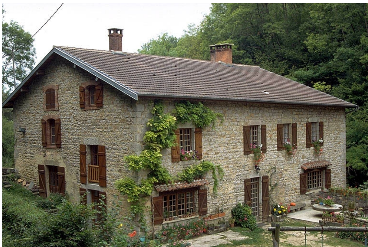
Façades antérieure et latérale gauche.
