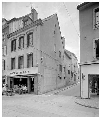
Vue d'ensemble sur l'angle des rues des Febvres et du Moulin. Phot. Jérôme Mongreville IVR43_19872501139V
