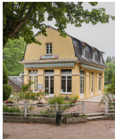
Pavillon des Fleurs après son agrandissement. Phot. Pierre-Marie Barbe-Richaud IVR26_20195800417NUC4A
