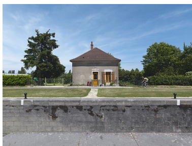
Vue de face de la maison : la façade est aujourd'hui atypique par rapport au modèle, il manque la fenêtre de gauche, sans doute bouchée. Phot. Thierry Kuntz IVR26_20112102959NUC4A
