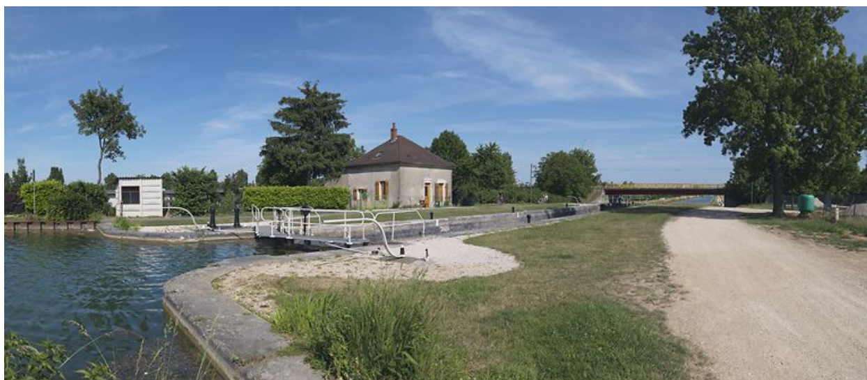
Site d'écluse de 3/4 amont. Vue large.
