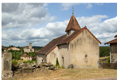
Vue depuis la rue Saint-Antoine. Phot. Sonia Dourlot IVR43_20157000535NUC2A
