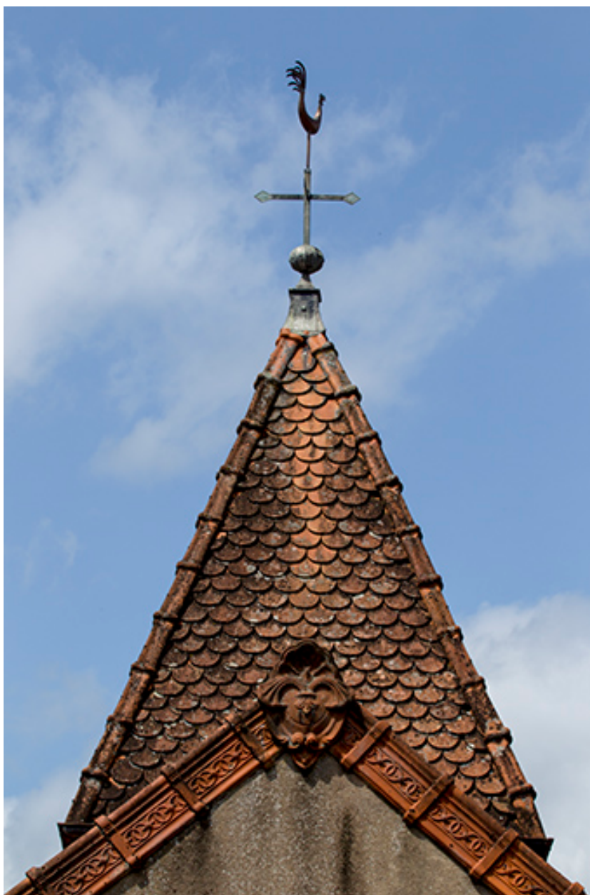
Campanile avec son toit en pavillon.
