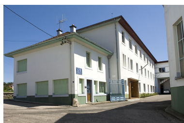
Conciergerie et bureaux. Phot. Jérôme Mongreville IVR43_20077000391NUCA
