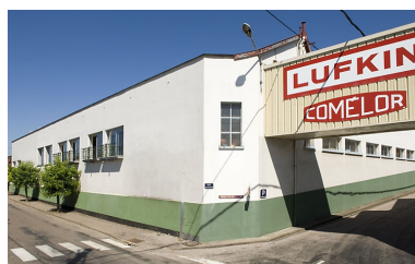
Façades des ateliers ouest. Phot. Jérôme Mongreville IVR43_20077000382NUCA
