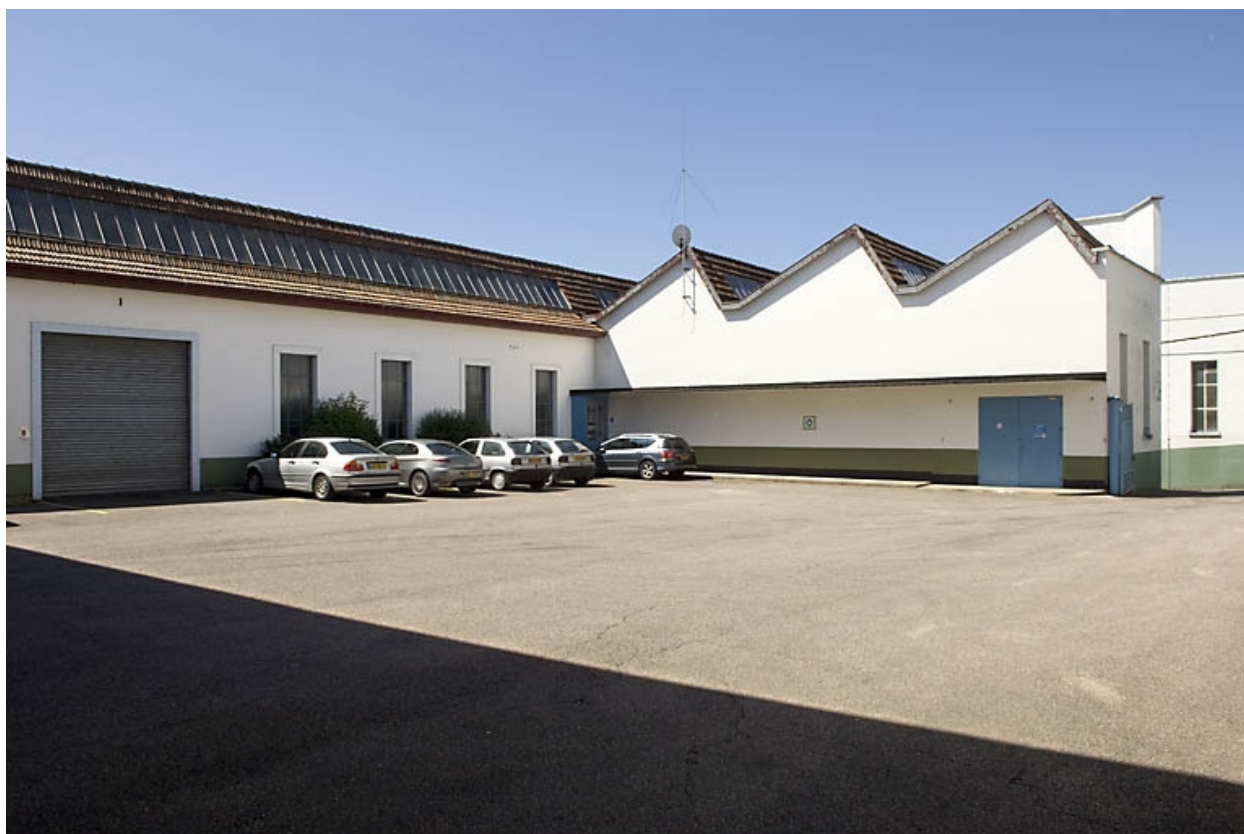
Cour de l'usine. Vue depuis le nord-est.
