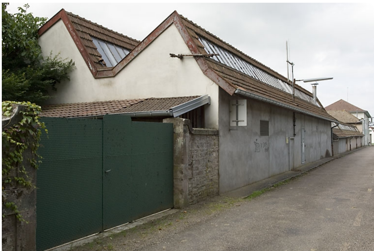
Façade nord de l'atelier de fabrication.
