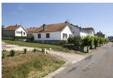
Logements. Vue d'ensemble depuis l'ouest. Phot. Jérôme Mongreville IVR43_20077000384NUCA
