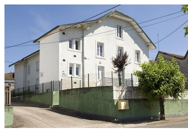
Logement ouvrier collectif. Phot. Jérôme Mongreville IVR43_20077000385NUCA
