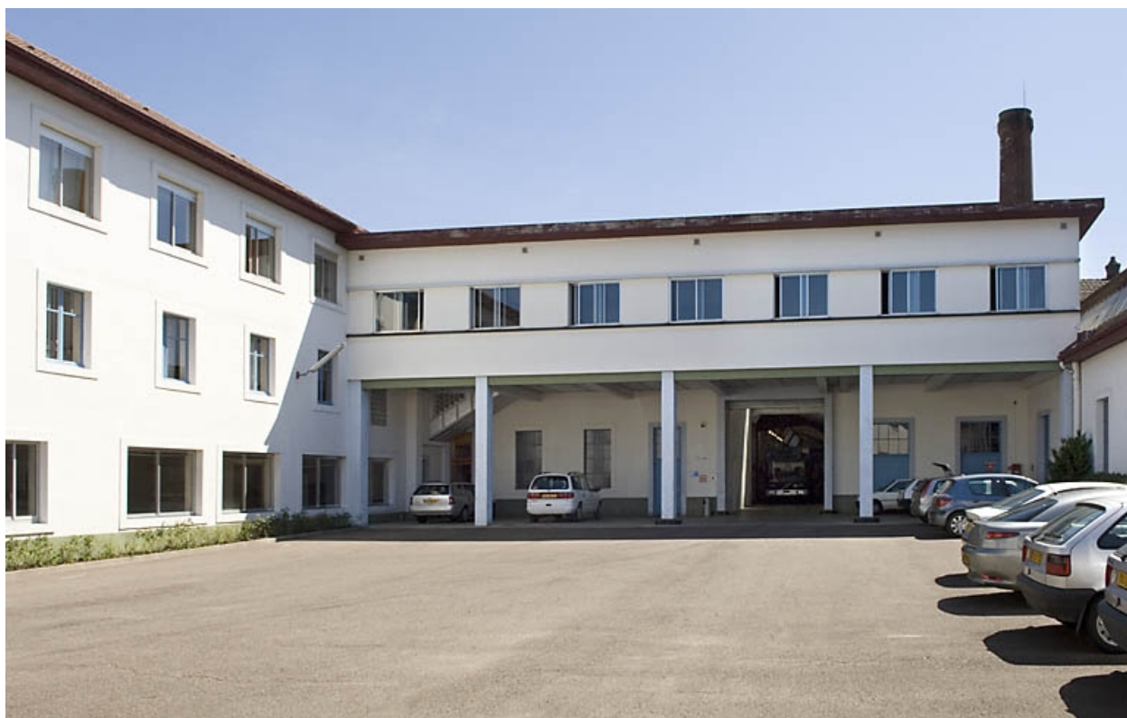
Cour de l'usine. Vue depuis l'ouest.
