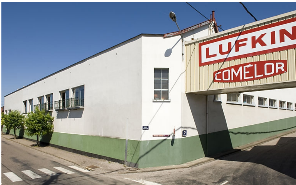
Façades des ateliers ouest.
