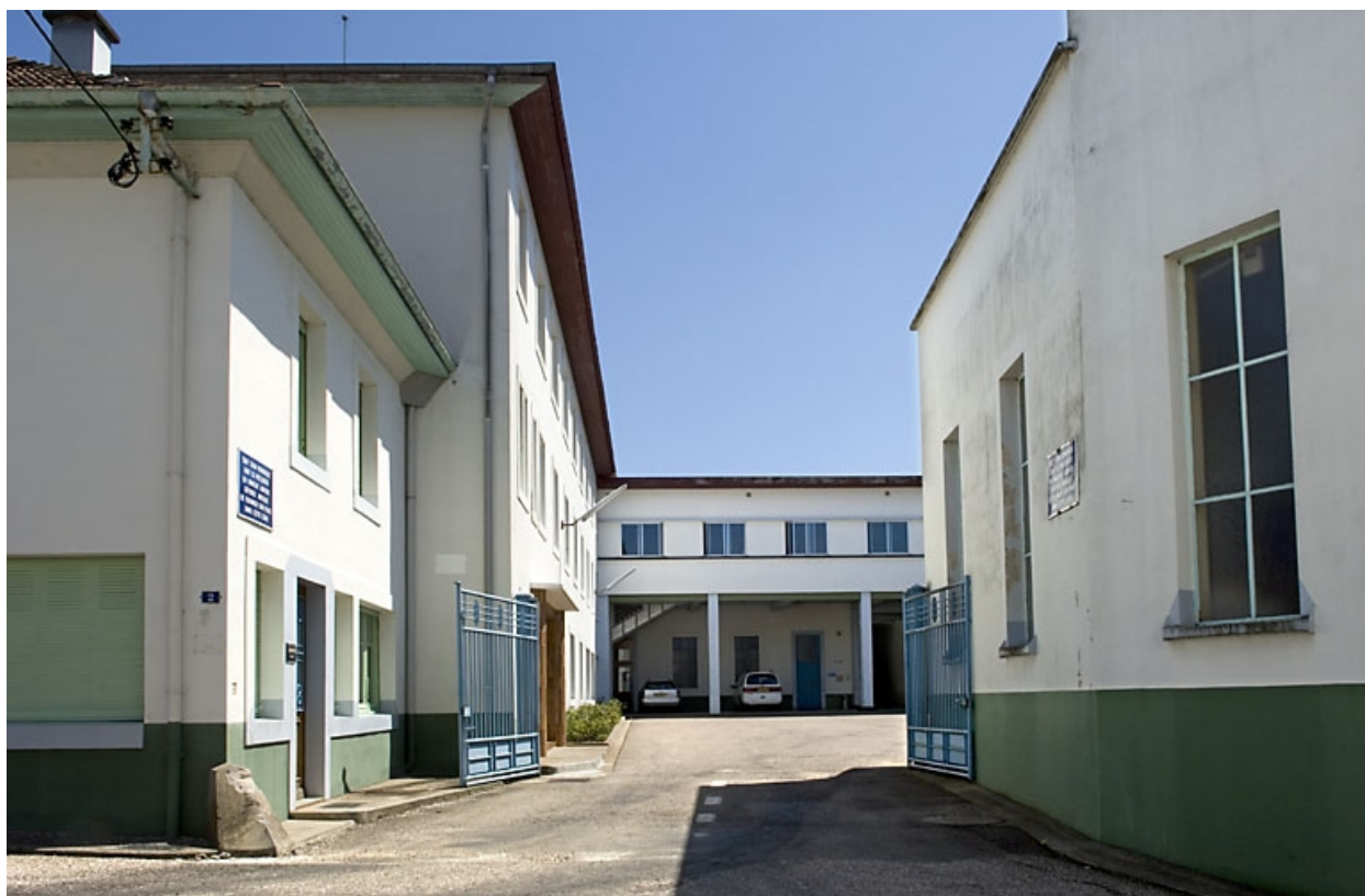
Entrée de l'usine.
