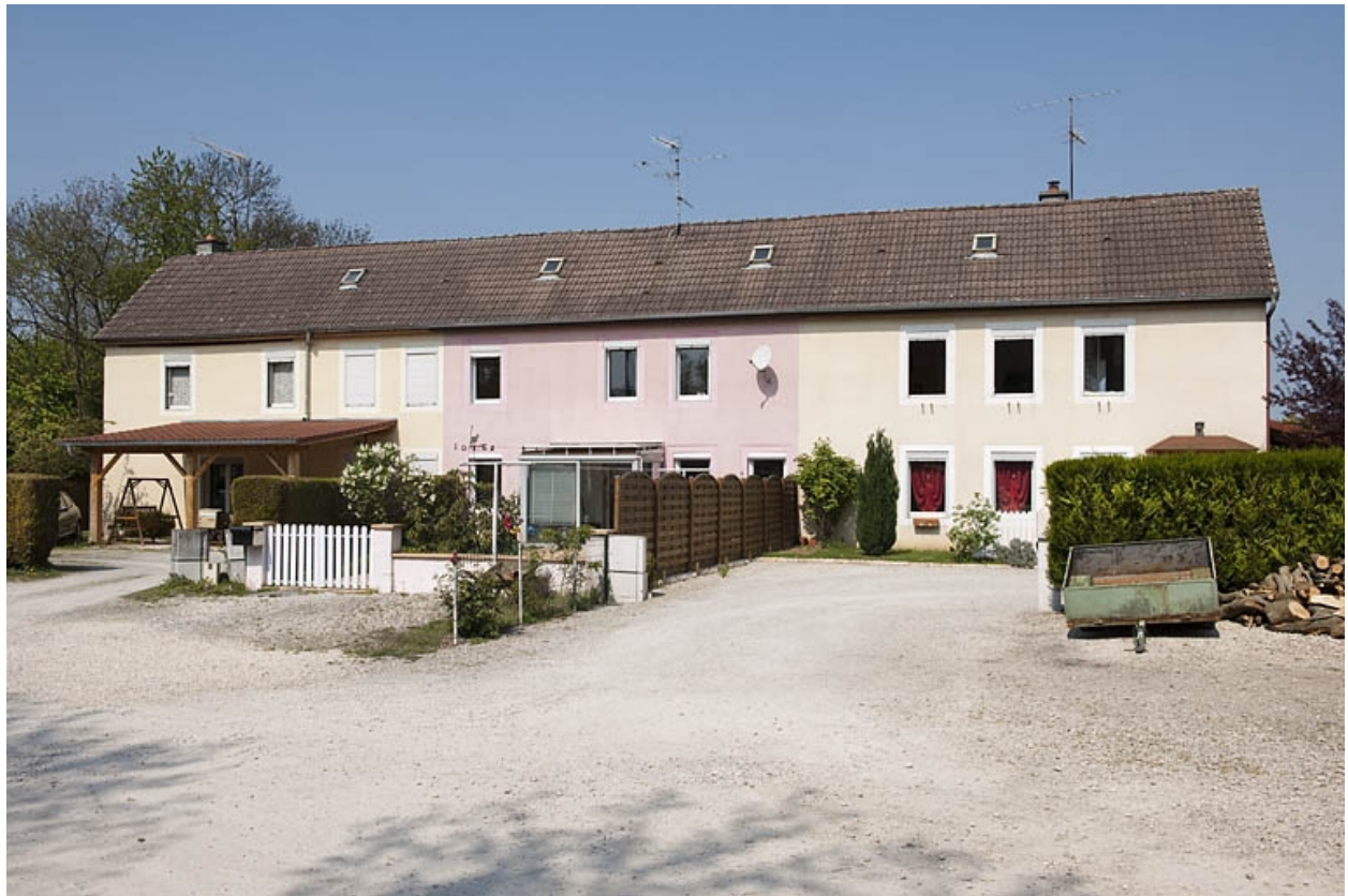
Bâtiment des magasins, remises et logements.
