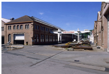
Rue 3 : atelier Traction, pont roulant et dépôt de pièces. Phot. Jérôme Mongreville IVR43_20029000102ZA
