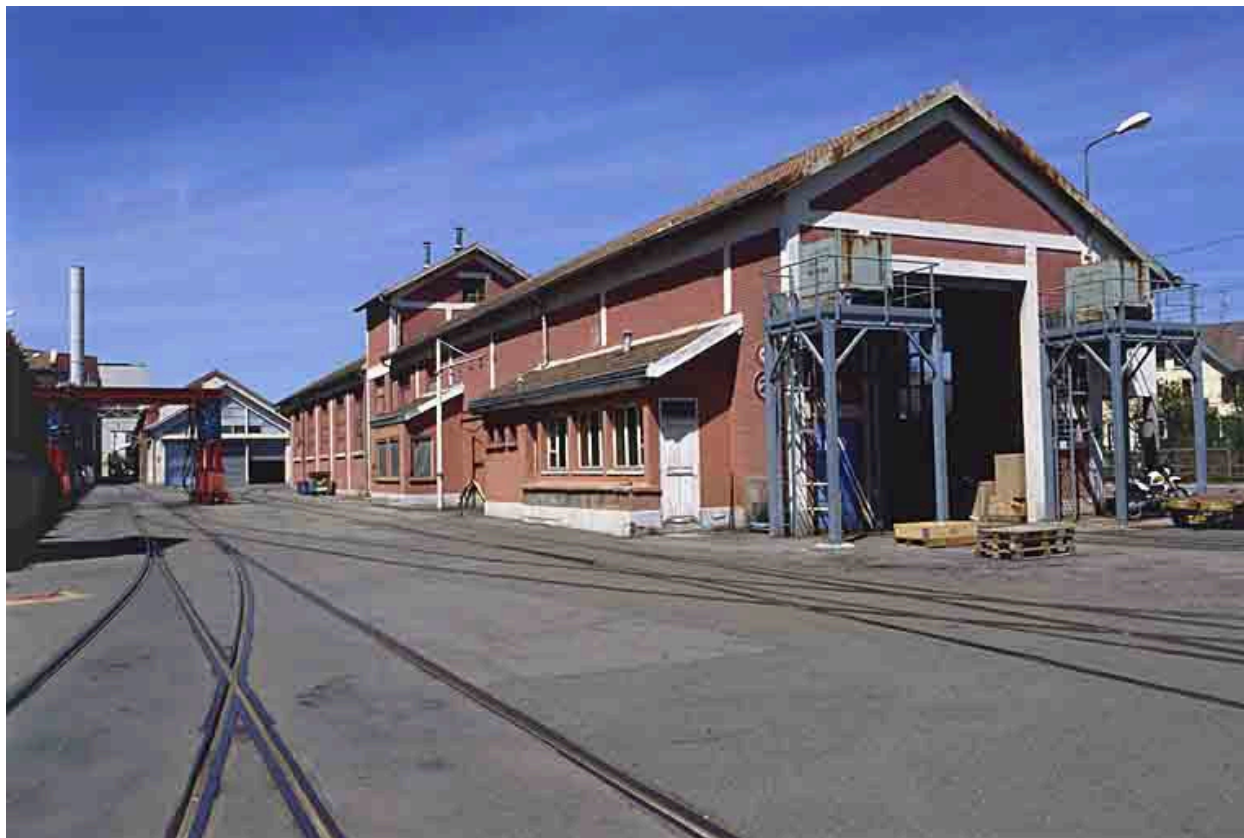
Ancien atelier de peinture des locomotives.
