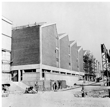
Construction de l'atelier d'usage Traction. Phot. IVR43_20029000208X
