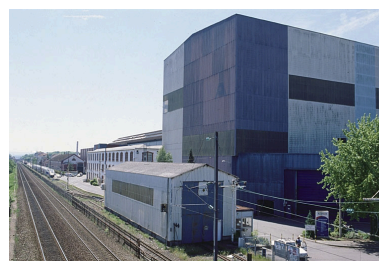
Voie ferrée, voies d'essais de l'usine Alstom. Phot. Jérôme Mongreville IVR43_20029000117ZA
