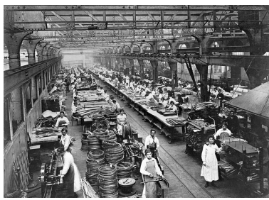
Bobinage dans l'atelier des grandes dynamos.
