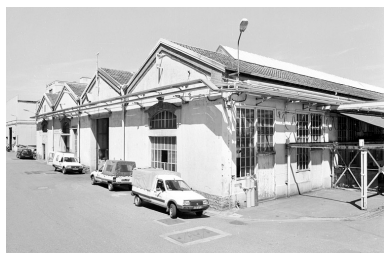
Ancien atelier de réparation (outillage central puis entretien mécanique). Phot. Jérôme Mongreville IVR43_20029000127X
