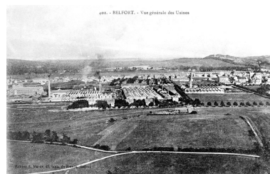
Belfort. Vue générale des Usines. Phot. IVR43_20019000180X
