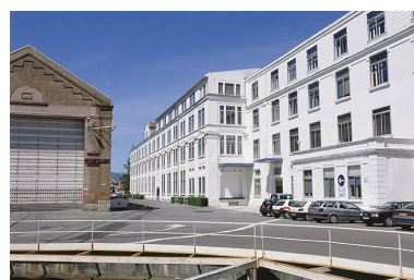
Prolongement nord de l'avenue 2. Phot. Jérôme Mongreville IVR43_20029000108ZA
