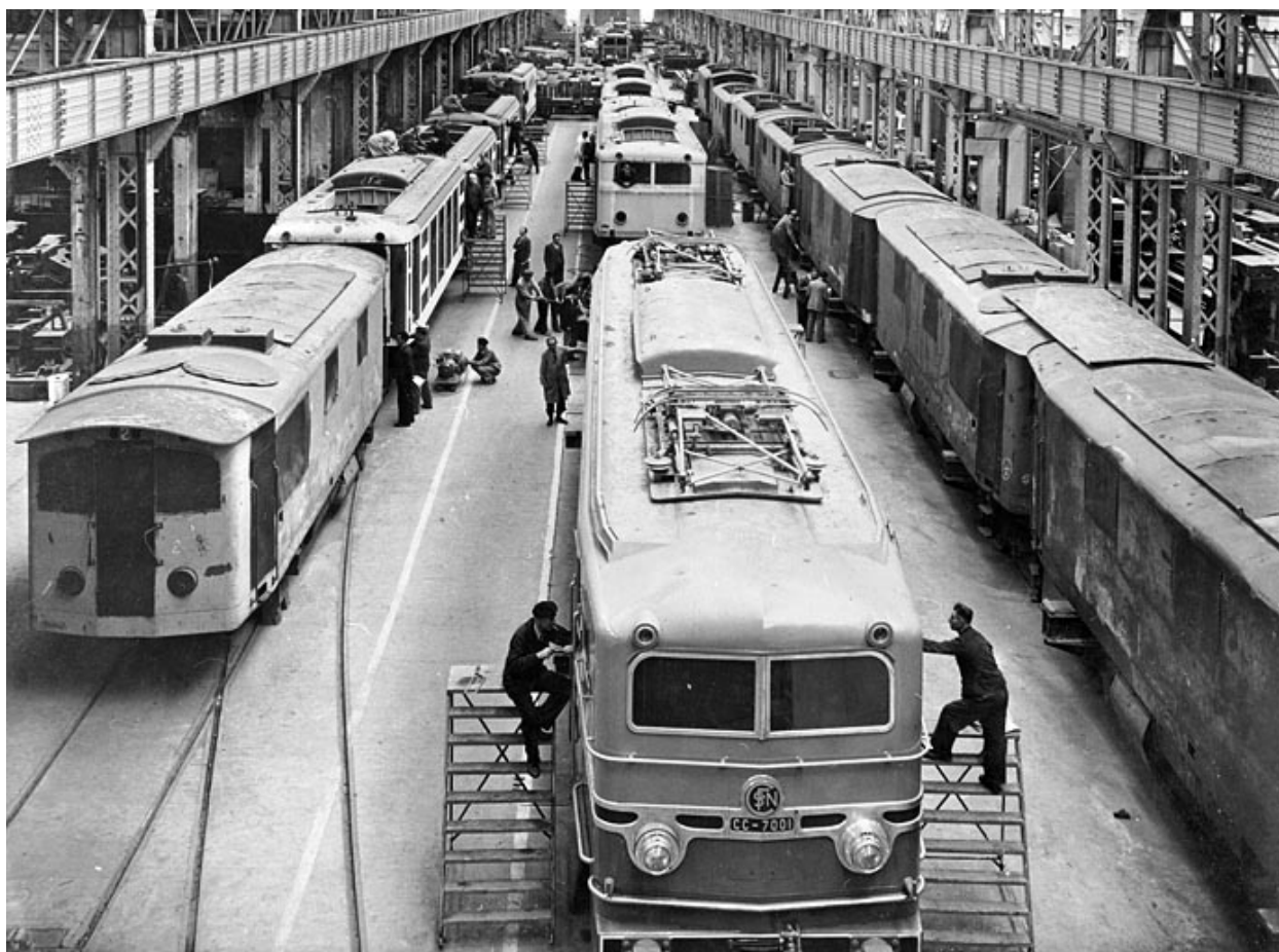
Hall de montage des locomotives électriques.
