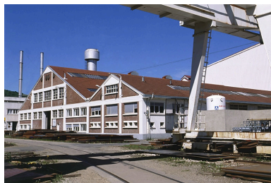
Atelier sur la rue 3 (ancienne forge). Phot. Jérôme Mongreville IVR43_20029000100ZA
