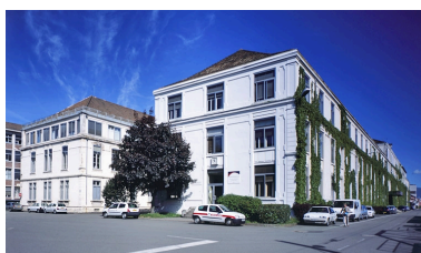
Bâtiments de bureaux depuis la porte des 3 Chênes. Phot. Jérôme Mongreville IVR43_20029000146VA
