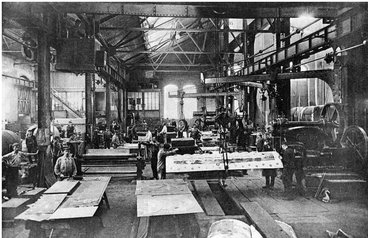
Chaudronnerie - Cintrage des tôles.
