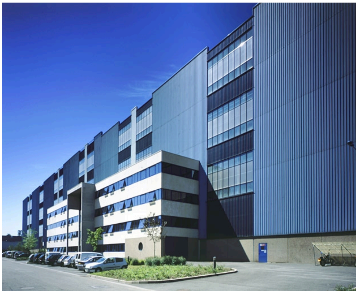
Halle 330 (bureaux et ateliers de montage).
