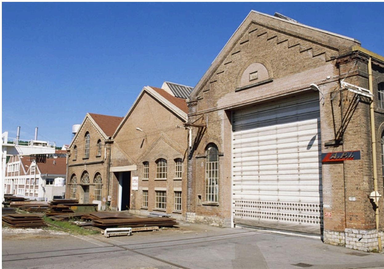
Vue de trois quarts des pignons des ateliers de métallurgie.
