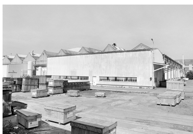
Aire de stockage et pignons de l'ancien atelier d'usinage des moyens moteurs. Phot. Jérôme Mongreville IVR43_20029000091X
