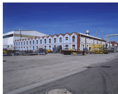
Vue de trois quarts de l'atelier de grosse construction. Phot. Jérôme Mongreville IVR43_20029000114XA
