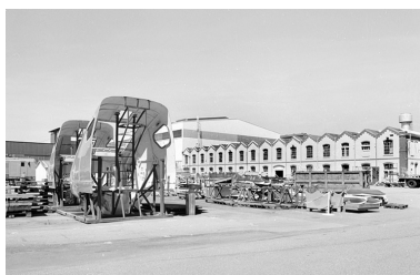
Vue d'ensemble de l'atelier de grosse construction. Phot. Jérôme Mongreville IVR43_20029000115X
