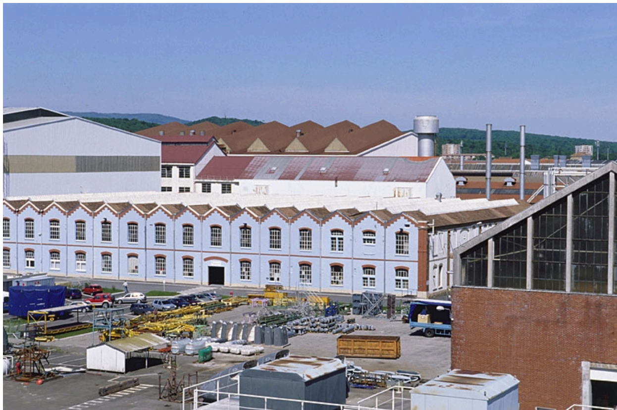
Vue plongeante depuis le sud-ouest.
