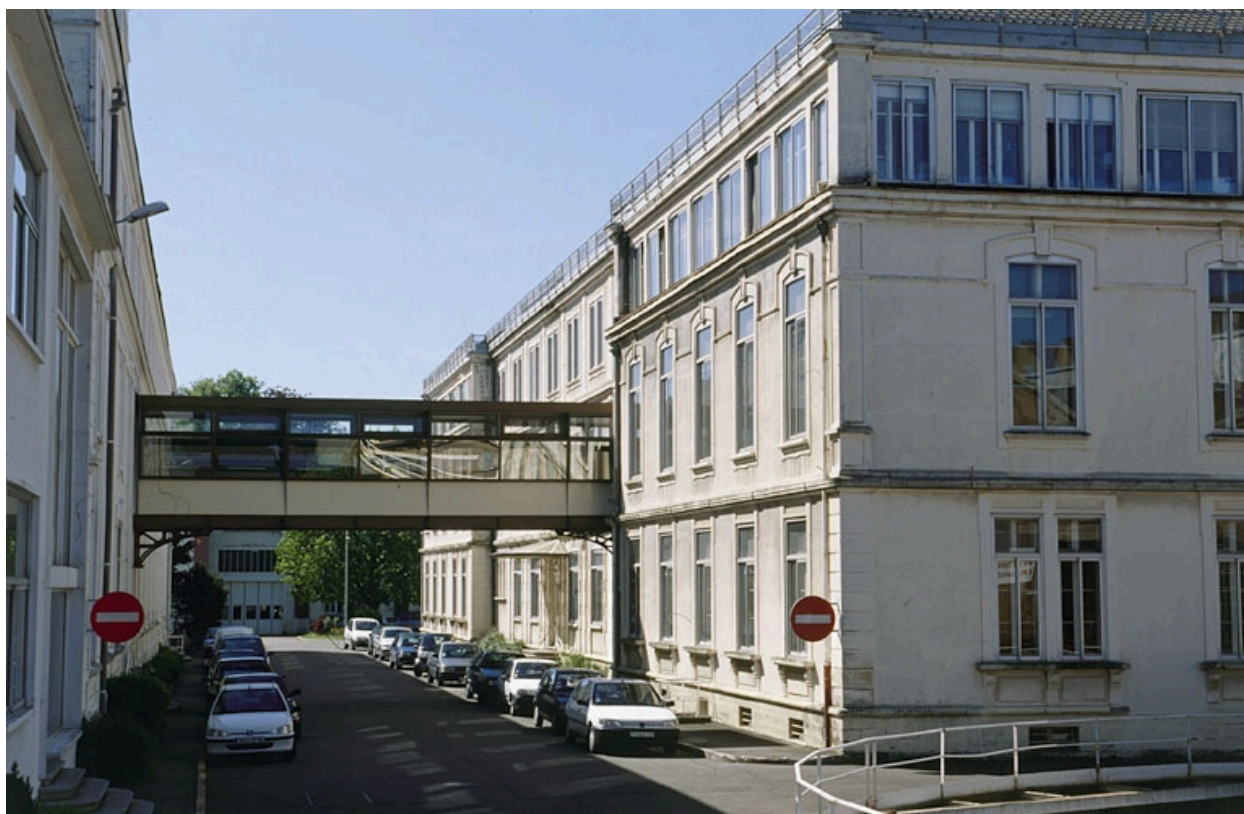
Façade des bureaux sur l'avenue 2.
