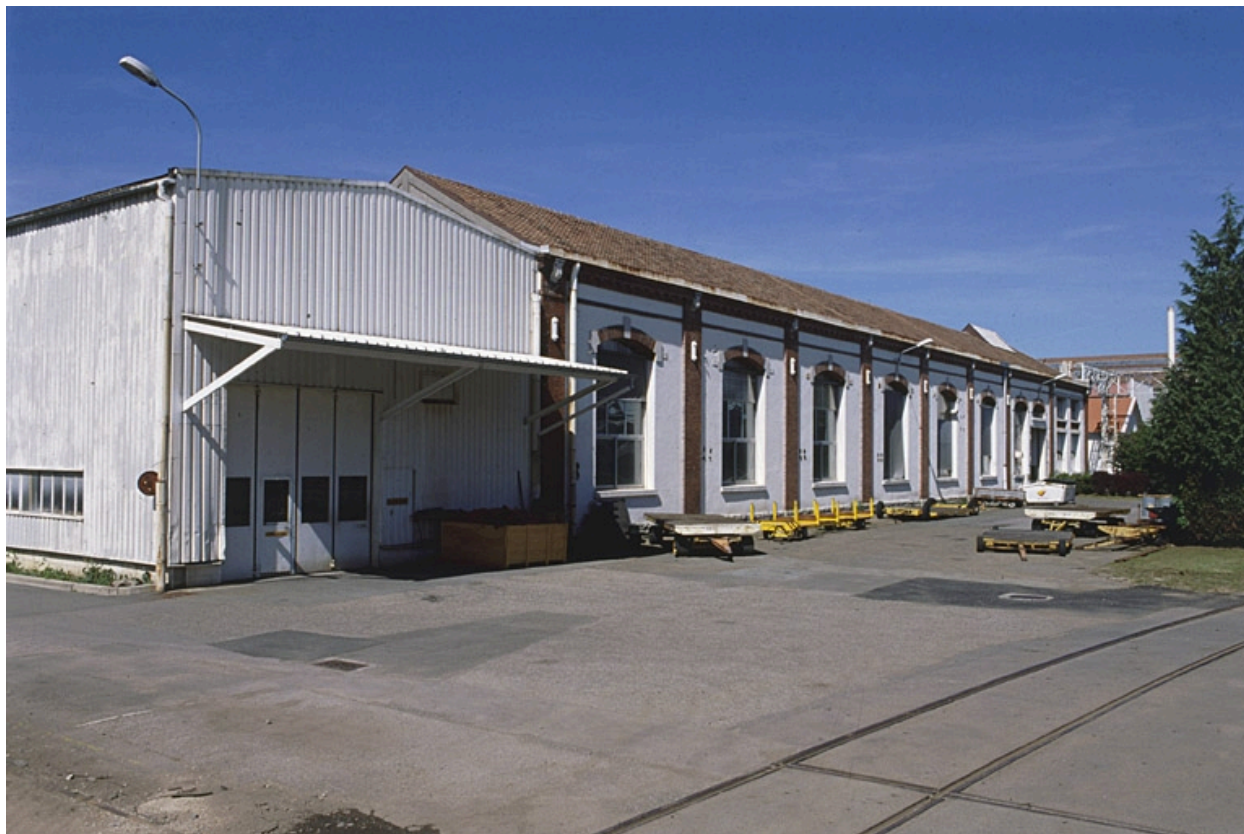
Façade sud de l'ancien atelier d'usinage des moyens moteurs.
