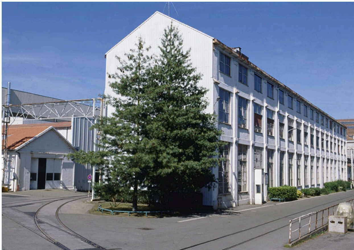
Anciens bureaux des contrôleurs.
