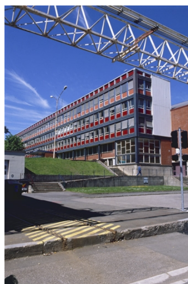
Vue de trois quarts des bureaux. Phot. Jérôme Mongreville IVR43_20029000077ZA
