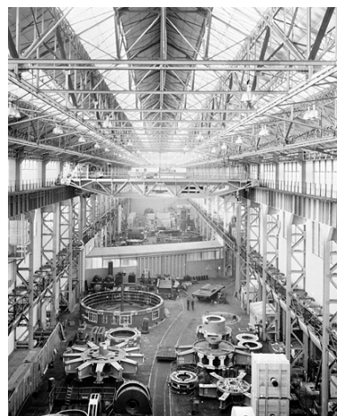
Hall de montage du gros matériel électrique tournant. Phot. IVR43_20029000218X
