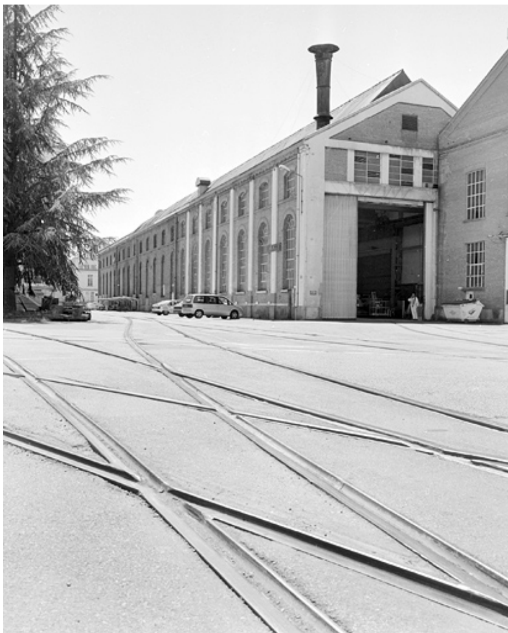
Rails de circulation des locomotives et façade est de l'ancienne fonderie de fonte.
