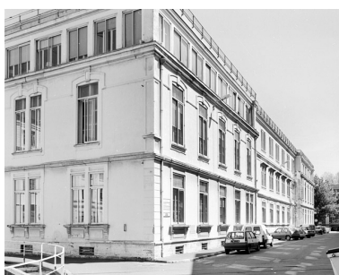
Vue de trois quarts des bureaux.
