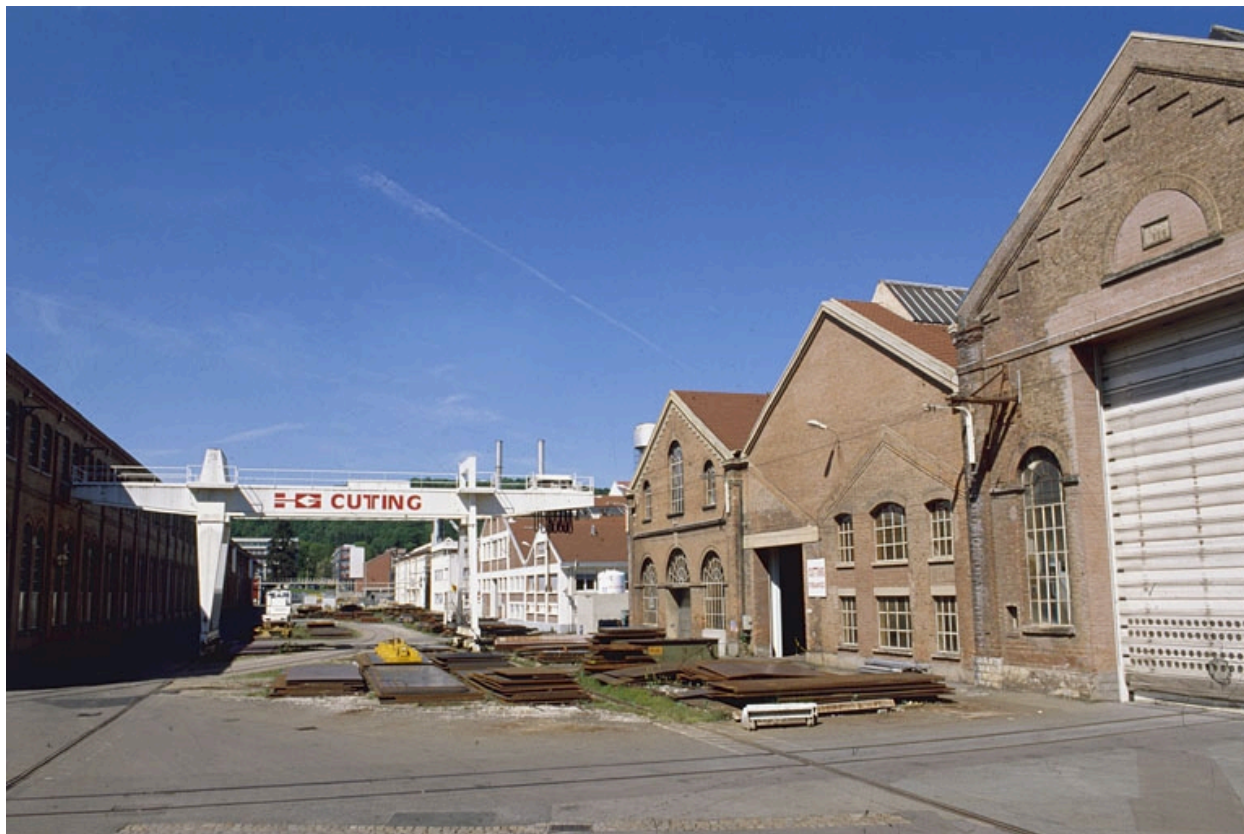
Pont roulant et ateliers de métallurgie sur la rue 3.
