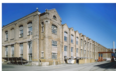
Vue de trois quarts de l'ancien atelier des grandes dynamos. Phot. Jérôme Mongreville IVR43_20029000154VA
