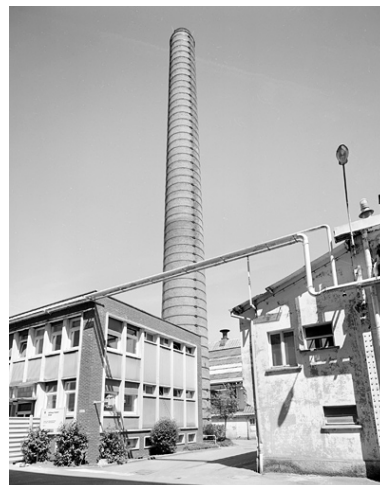
Cheminée. Phot. Jérôme Mongreville IVR43_20029000161V
