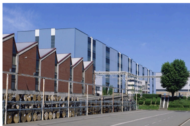
Vue d'ensemble d'un atelier Traction et de la halle 330. Phot. Jérôme Mongreville IVR43_20029000073ZA
