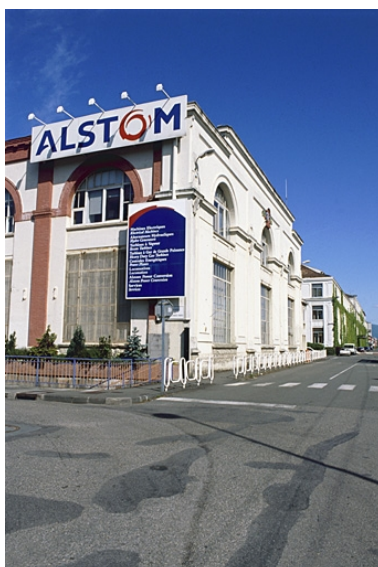
Alignement de façades depuis la porte des 3 Chênes. Phot. Jérôme Mongreville IVR43_20029000160ZA
