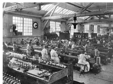
Atelier d'appareillage - Monteurs du petit appareillage et champ d'essai.
