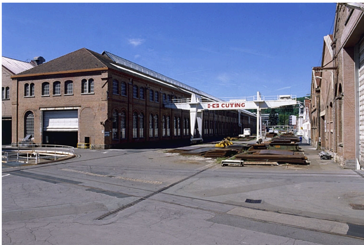
Rue 3 : atelier Traction, pont roulant et dépôt de pièces.
