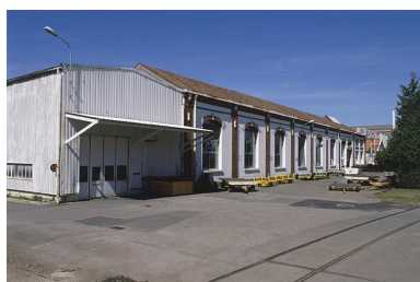
Façade sud de l'ancien atelier d'usinage des moyens moteurs. Phot. Jérôme Mongreville IVR43_20029000088ZA
