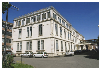
Bureaux depuis l'est. Phot. Jérôme Mongreville IVR43_20029000144ZA
