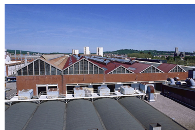
Les ateliers Traction depuis l'ouest. Phot. Jérôme Mongreville IVR43_20029000110ZA
