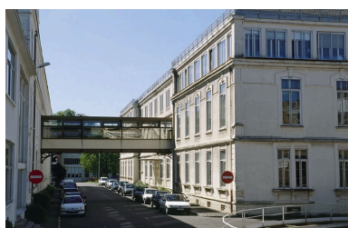
Façade des bureaux sur l'avenue 2. Phot. Jérôme Mongreville IVR43_20029000067ZA
