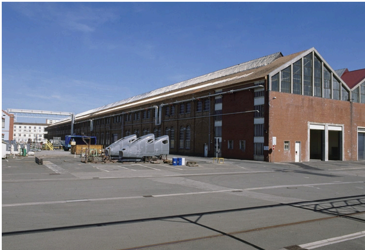
Façade nord de l'atelier Traction.
