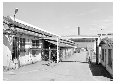
Vue vers l'est depuis l'avenue 8. Phot. Jérôme Mongreville IVR43_20029000126X
