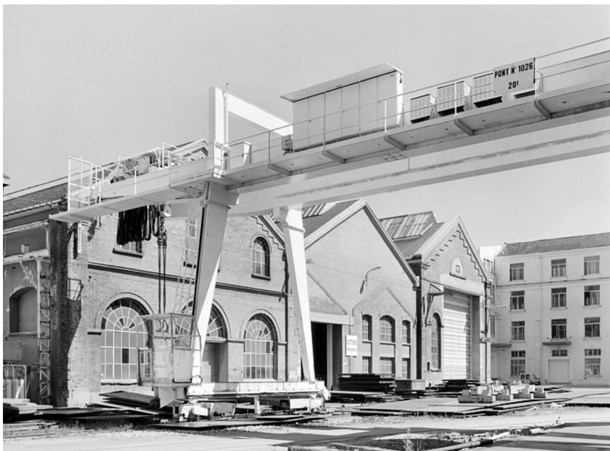
Rue 3 : pont roulant et ateliers de métallurgie.
