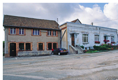
Pignons est de l'ancien atelier d'usinage des moyens moteurs. Phot. Jérôme Mongreville IVR43_20029000053ZA
