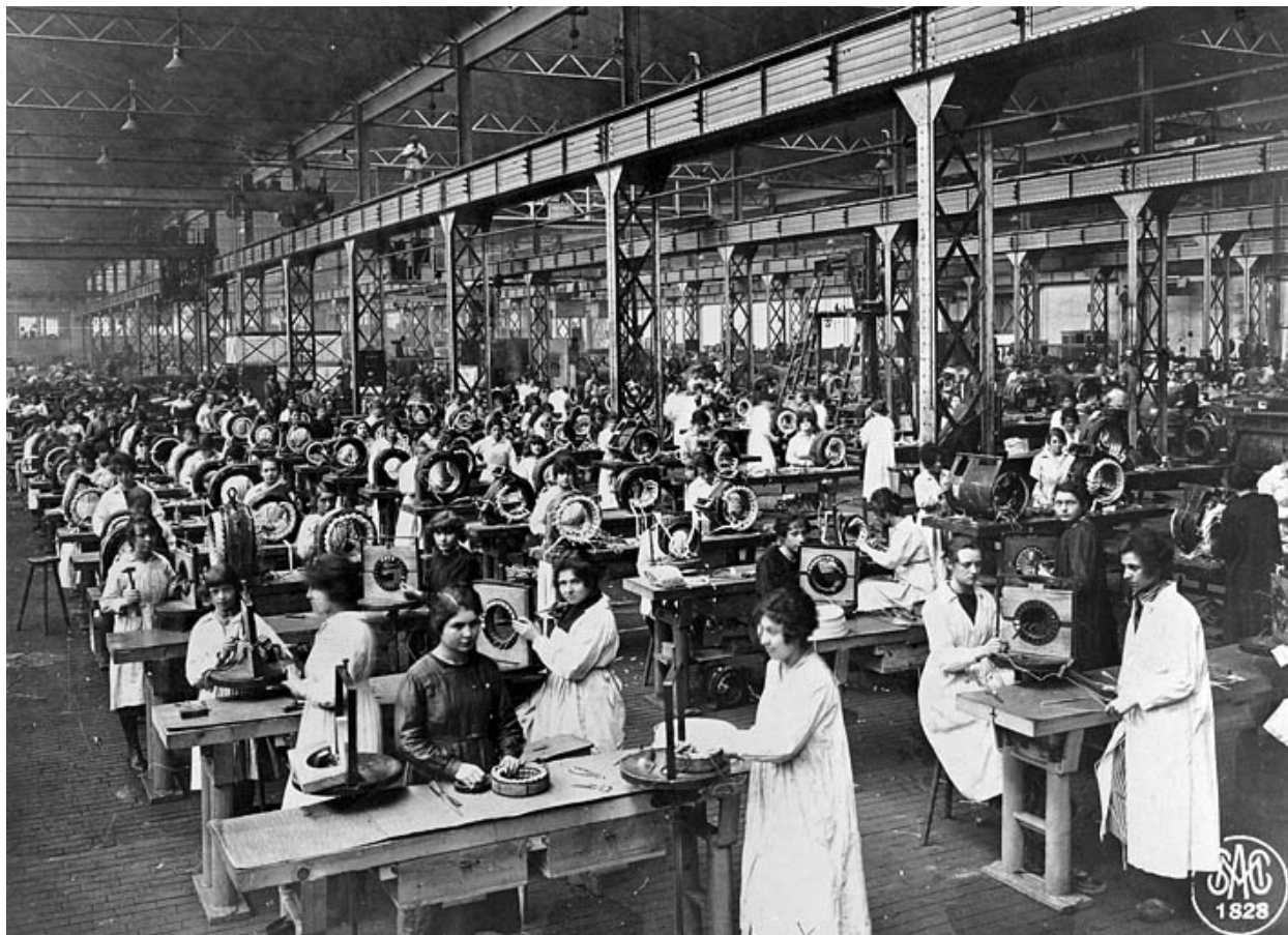
Atelier des petites dynamos normales (chantier de bobinage).
