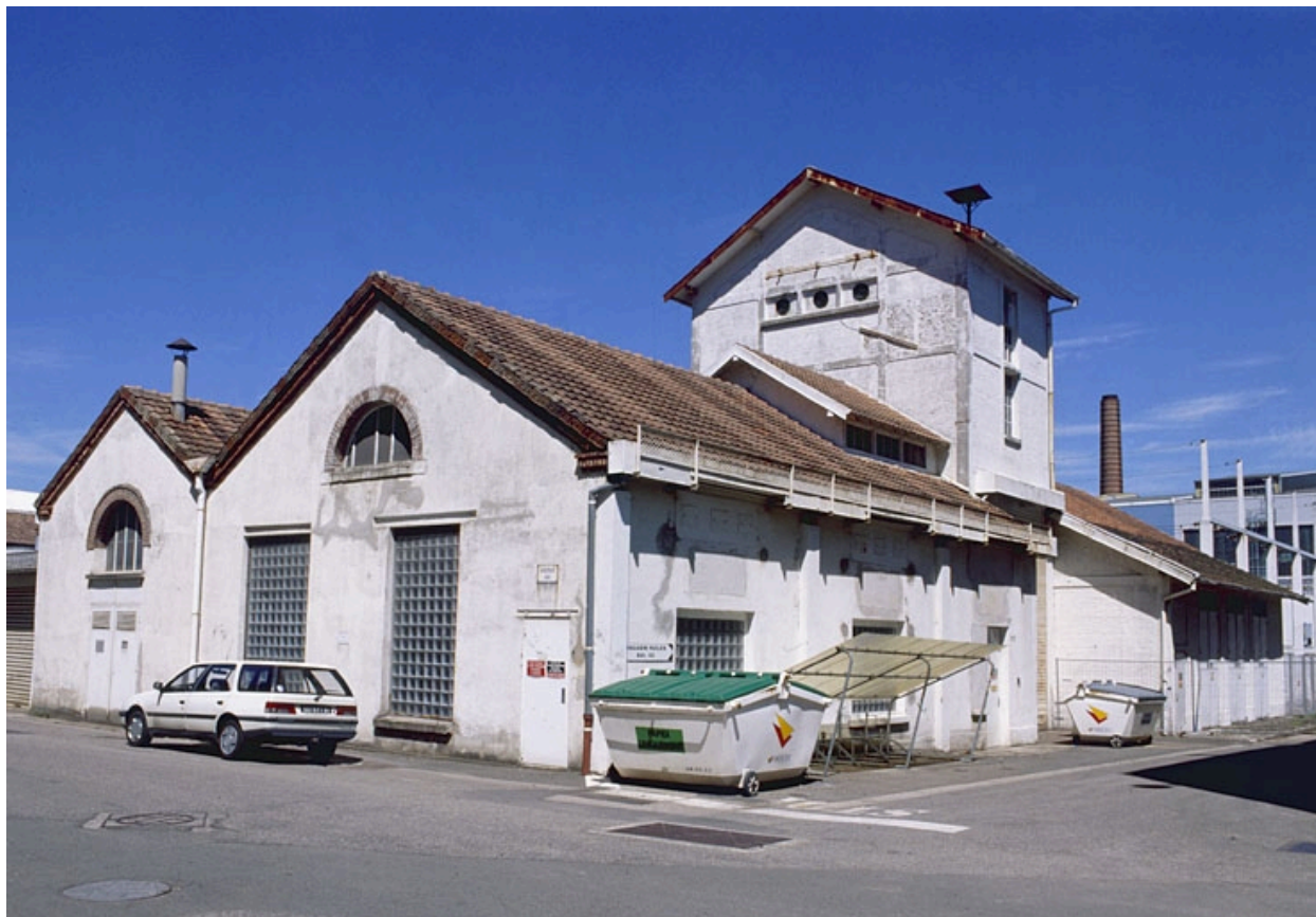
Station électrique et transformateur.
