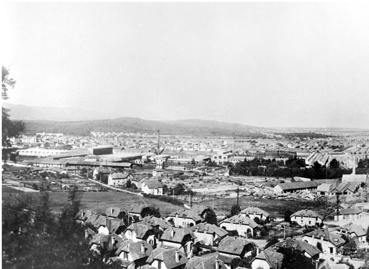
Vue générale des usines de Belfort.
