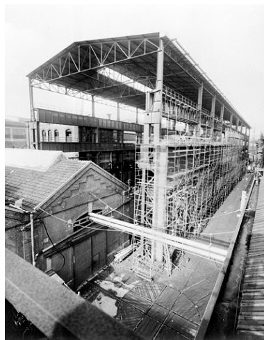
Construction d'une halle de montage (?). Phot. IVR43_20029000219X
