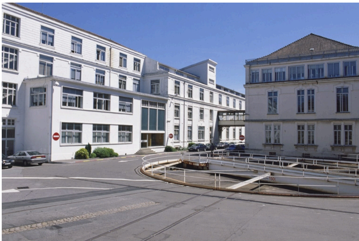
Vue d'ensemble des bureaux depuis le nord.
