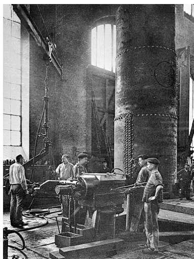
Chaudronnerie - Riveuse hydraulique.
