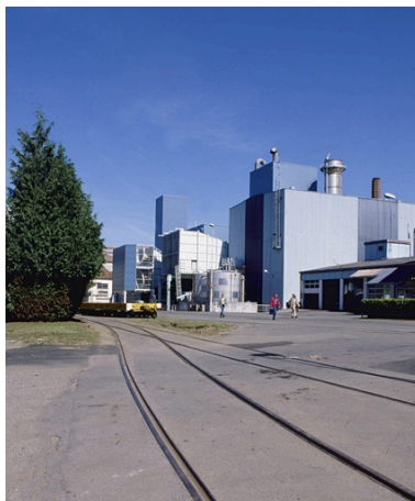
Ateliers de fabrication 53A et 57. Phot. Jérôme Mongreville IVR43_20029000061ZA
