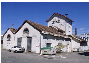
Station électrique et transformateur. Phot. Jérôme Mongreville IVR43_20029000063ZA
