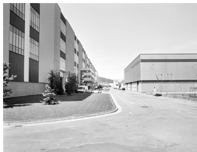
Façade est de la halle 330 (bureaux et ateliers de montage). Phot. Jérôme Mongreville IVR43_20029000132X
