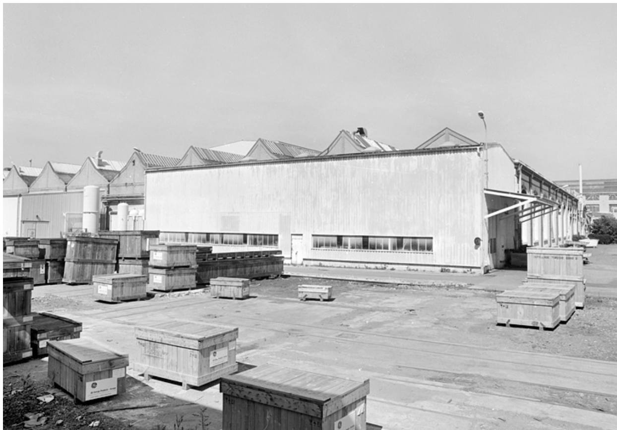
Aire de stockage et pignons de l'ancien atelier d'usinage des moyens moteurs.
