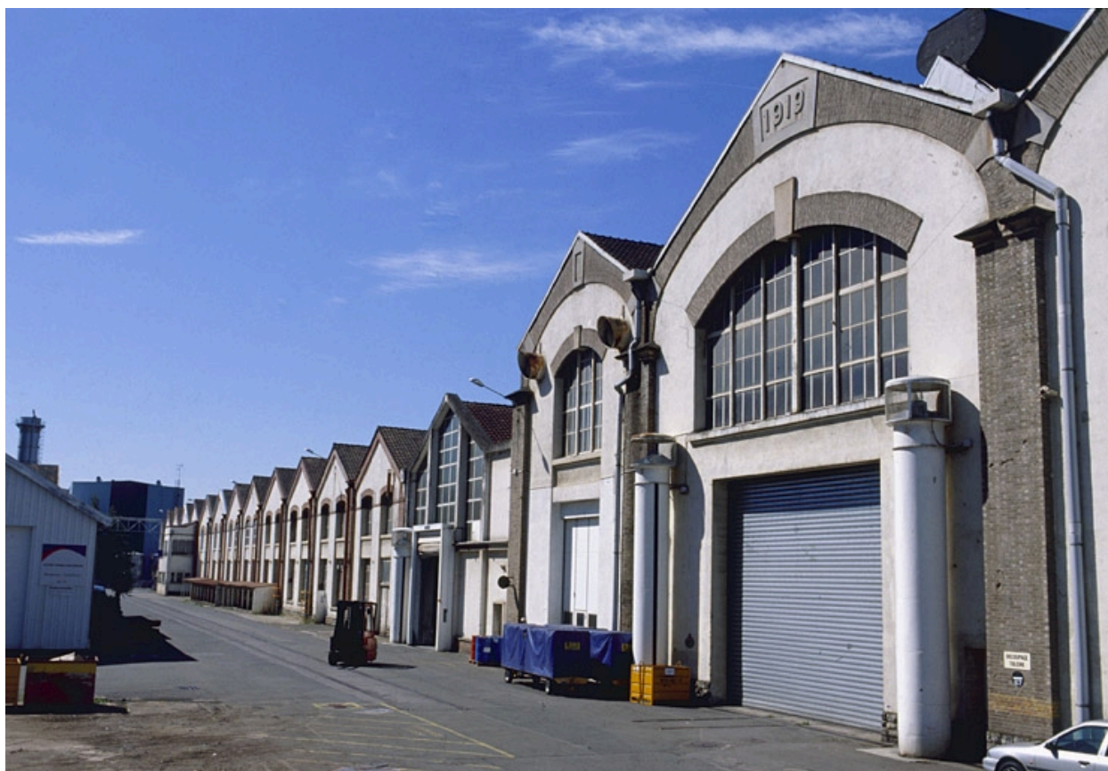
Vue de trois quarts des pignons de l'ancien atelier d'usinage, de soudure et d'assemblage (moyens moteurs).
