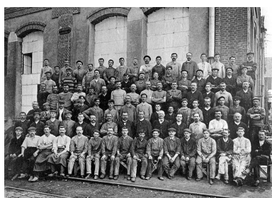
Atelier des grandes dynamos - Personnel d'outilleurs, forgerons, peintres, menuisiers et manoeuvres.
