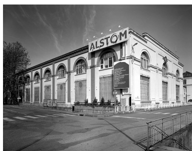
Bâtiment d'entrée à la porte des 3 Chênes. Phot. Jérôme Mongreville IVR43_20029000157V
