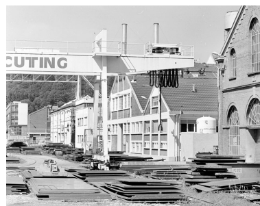
Alignement des pignons d'ateliers sur la rue 3. Phot. Jérôme Mongreville IVR43_20029000123X
