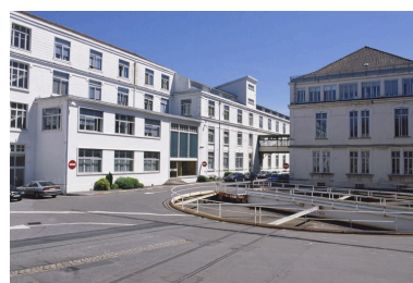
Vue d'ensemble des bureaux depuis le nord. Phot. Jérôme Mongreville IVR43_20029000079ZA
