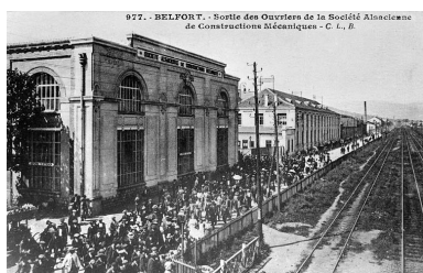
Sortie des ouvriers de la Société Alsacienne de Constructions Mécaniques. Phot. IVR43_20019000136X
