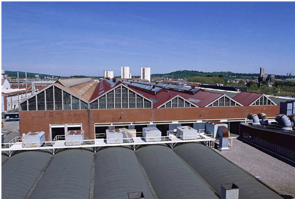
Les ateliers Traction depuis l'ouest.
