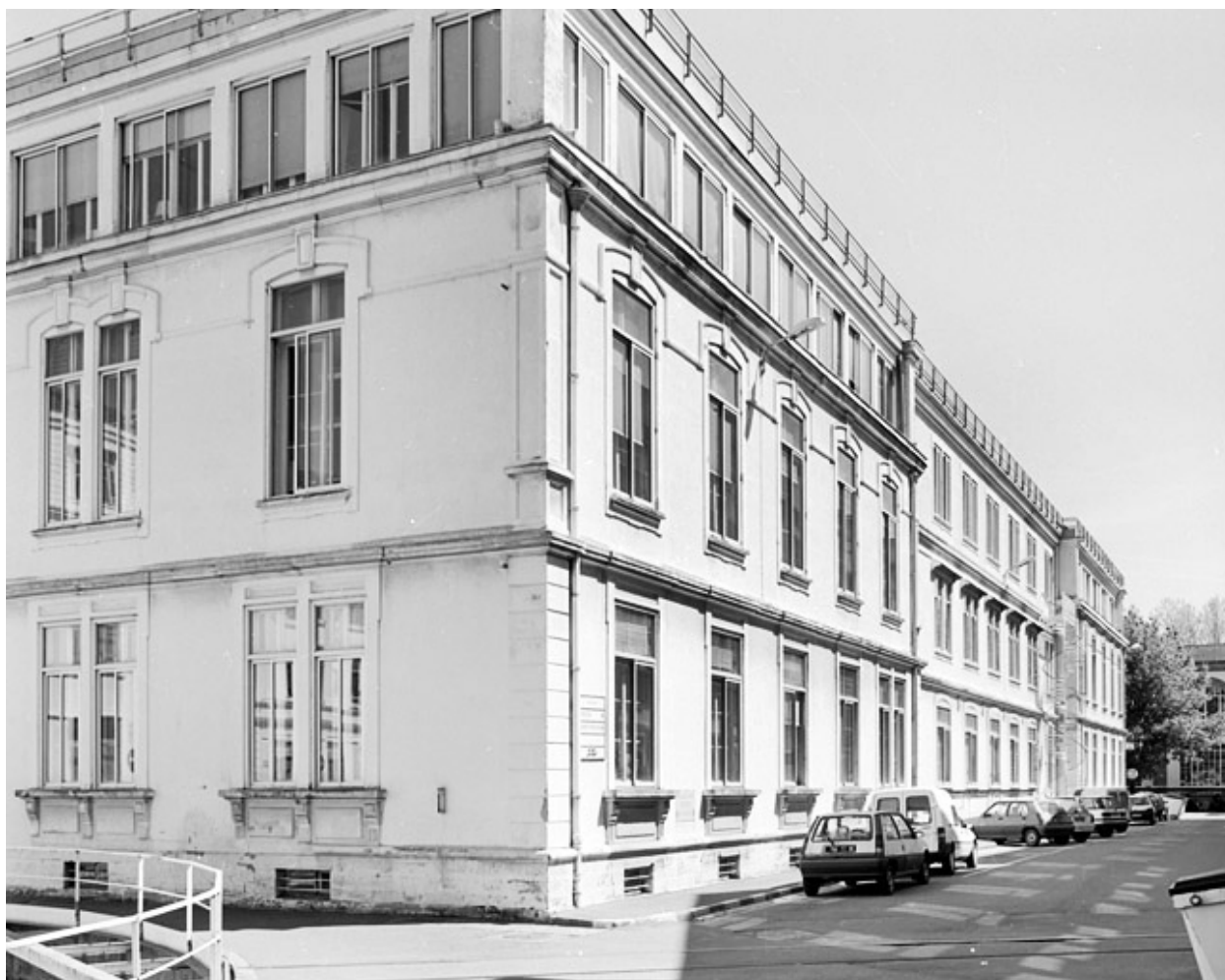
Vue de trois quarts des bureaux.
