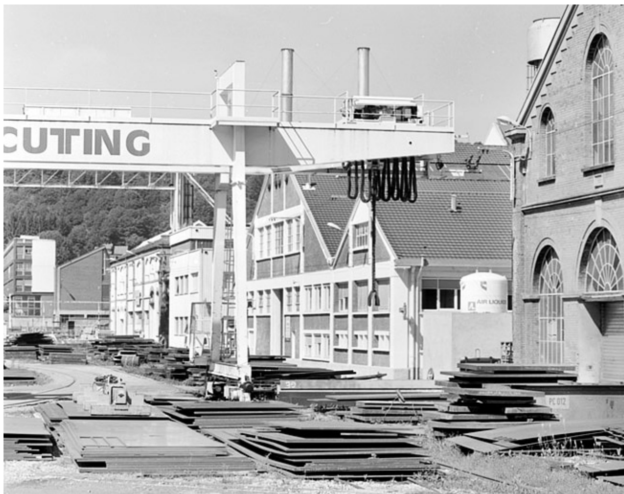
Alignement des pignons d'ateliers sur la rue 3.
