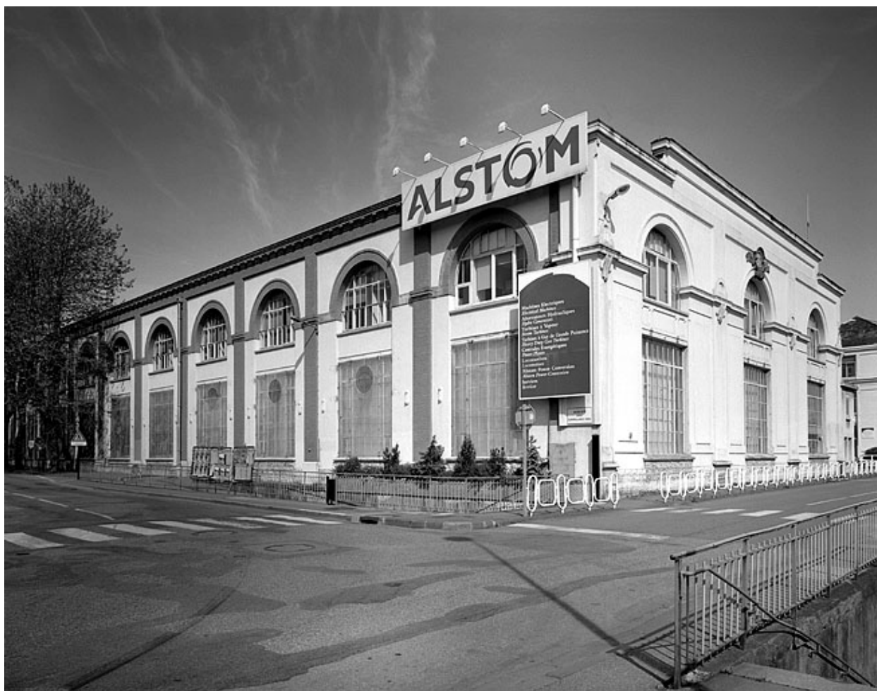
Bâtiment d'entrée à la porte des 3 Chênes.
