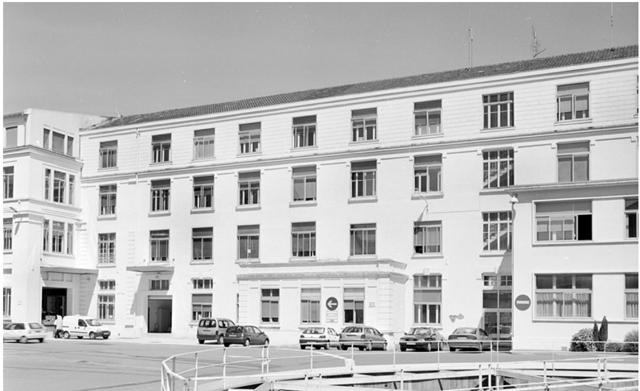
Bureaux et ancienne infirmerie.
