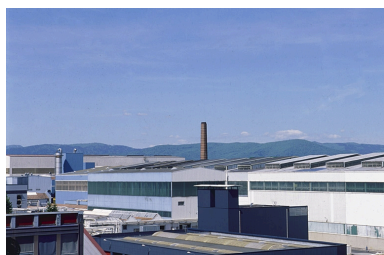
Vue des toitures depuis le sud. Phot. Jérôme Mongreville IVR43_20029000094ZA
