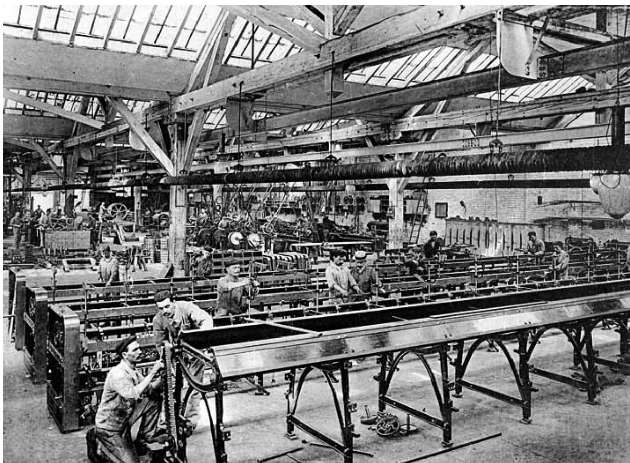
Atelier de machines de filature - Montage des continus à filer.
