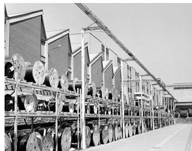
Bobines de câbles déposées devant l'atelier Traction. Phot. Jérôme Mongreville IVR43_20029000074X
