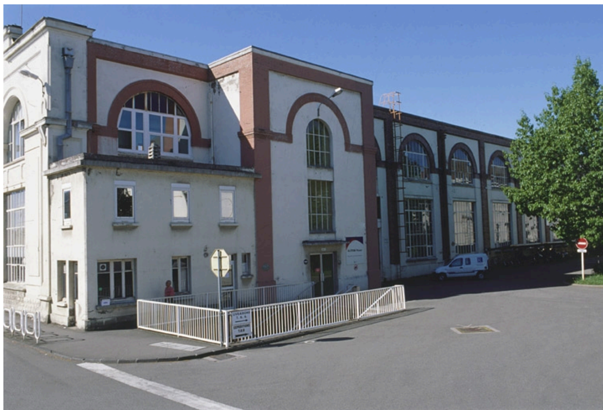
Façade nord du bâtiment de la porte des 3 Chênes.
