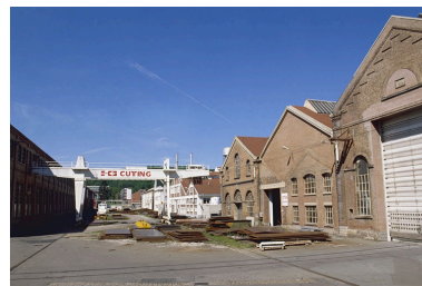
Pont roulant et ateliers de métallurgie sur la rue 3. Phot. Jérôme Mongreville IVR43_20029000069ZA
