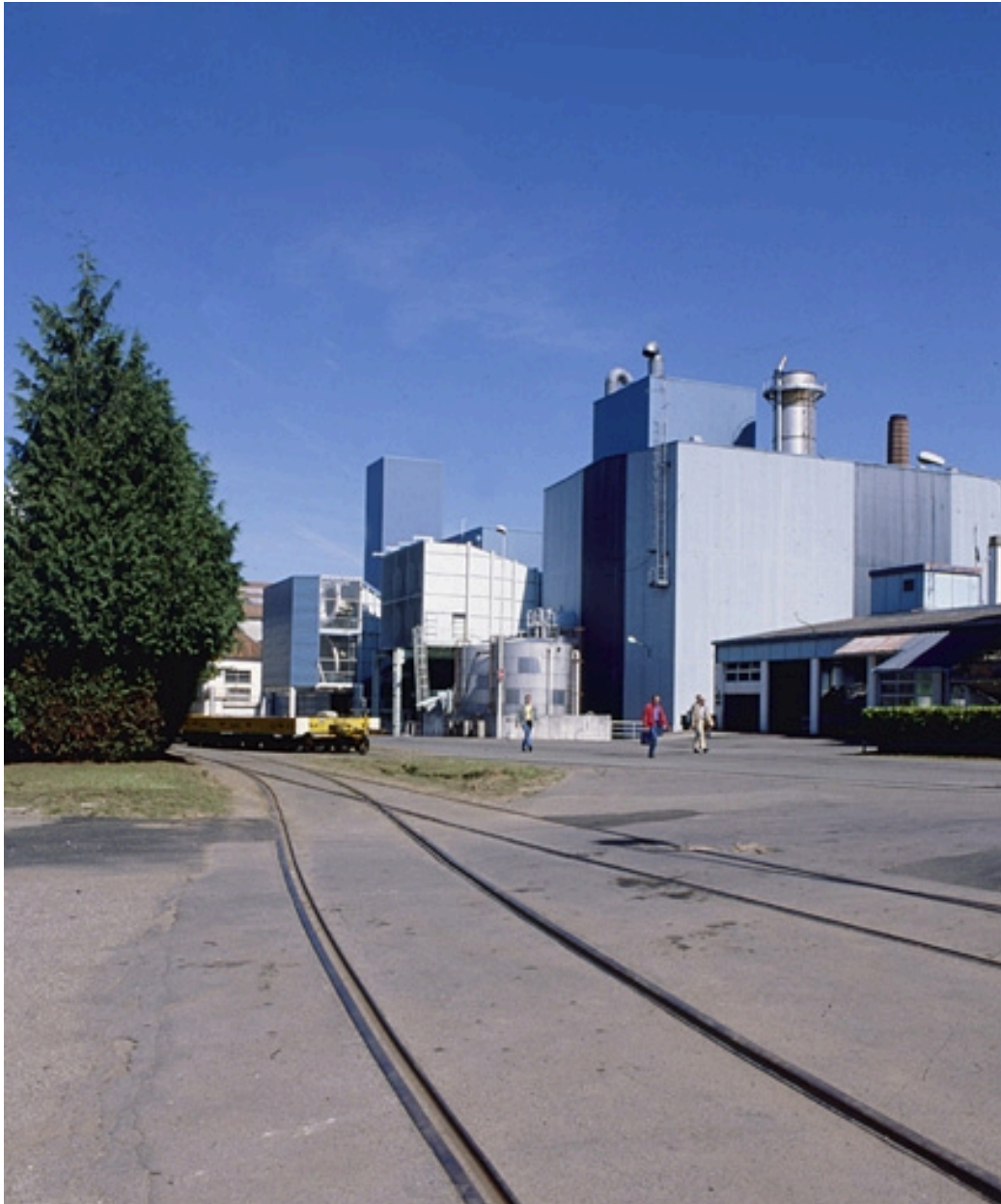
Ateliers de fabrication 53A et 57.
