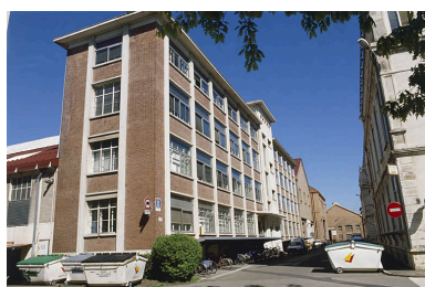
Bureaux situés à l'extrémité de l'atelier Traction. Phot. Jérôme Mongreville IVR43_20029000142ZA
