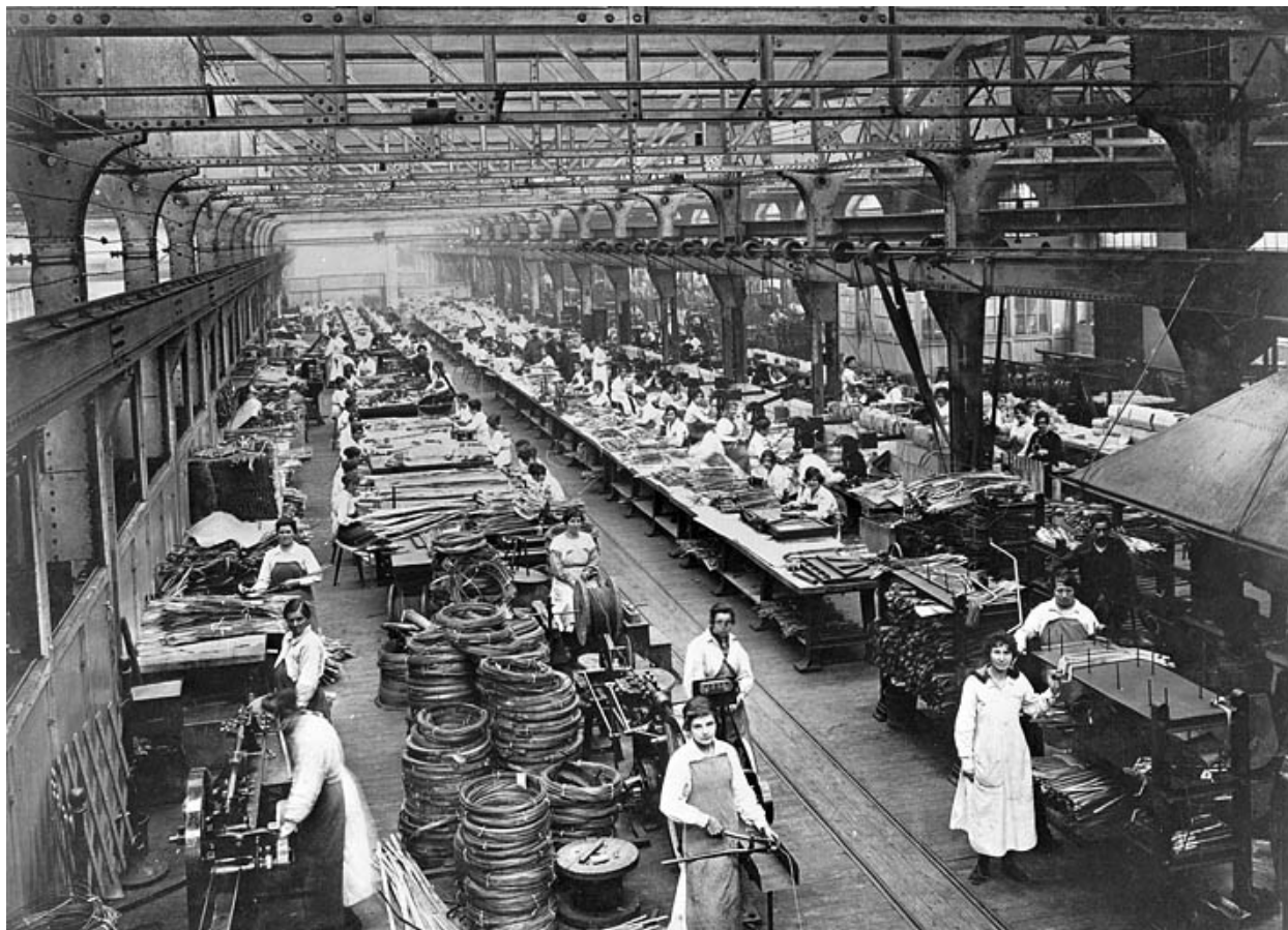
Bobinage dans l'atelier des grandes dynamos.
