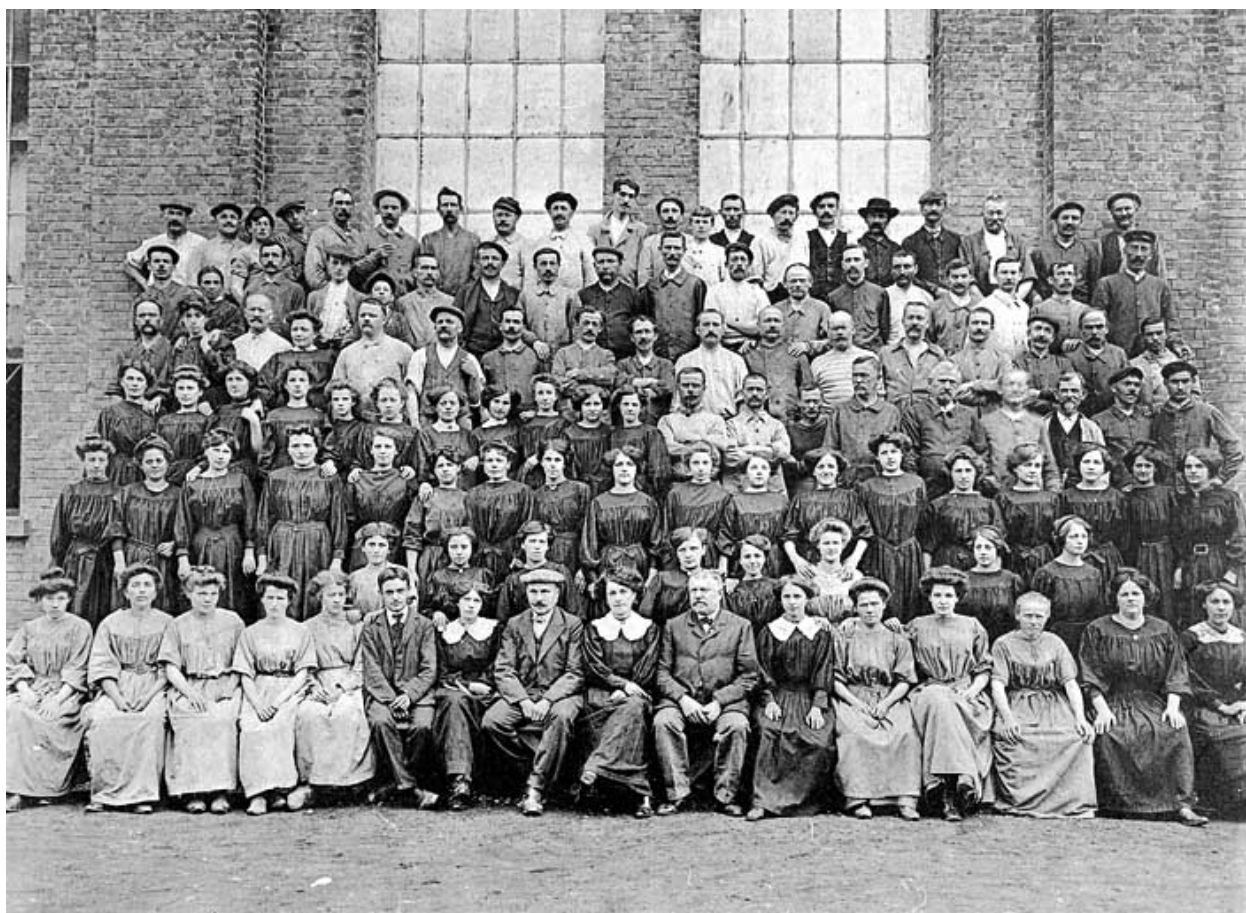
Câblerie - Groupe de personnel.
