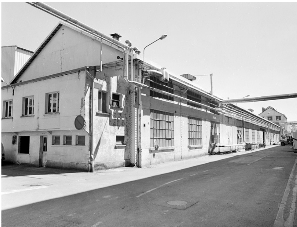
Ancien atelier de petite chaudronnerie.
