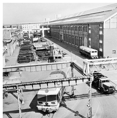
Atelier de montage des tractions depuis le nord-ouest. Phot. IVR43_20029000195X
