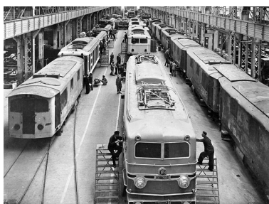
Hall de montage des locomotives électriques. Phot. IVR43_20029000205X
