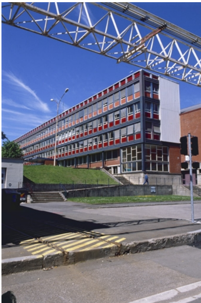
Vue de trois quarts des bureaux.
