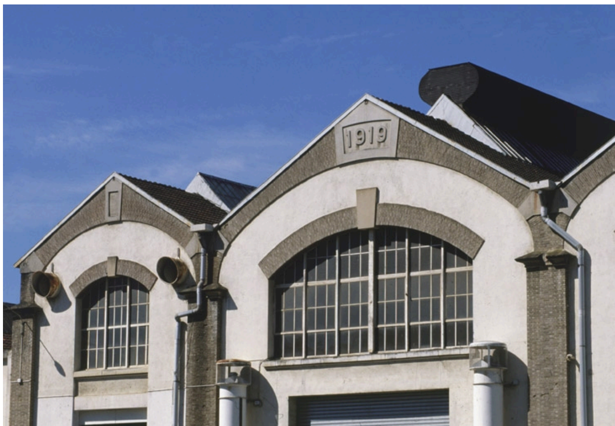
Détail des pignons de l'ancien atelier de soudure et d'assemblage.
