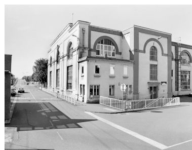
Bâtiment d'entrée à la porte des 3 Chênes, depuis le nord. Phot. Jérôme Mongreville IVR43_20029000086X
