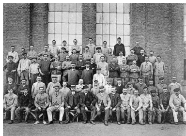
Groupe de personnel de l'atelier de grosse construction. Phot. , Autr. Ernest (photographe) Mézière IVR43_20019000145X
