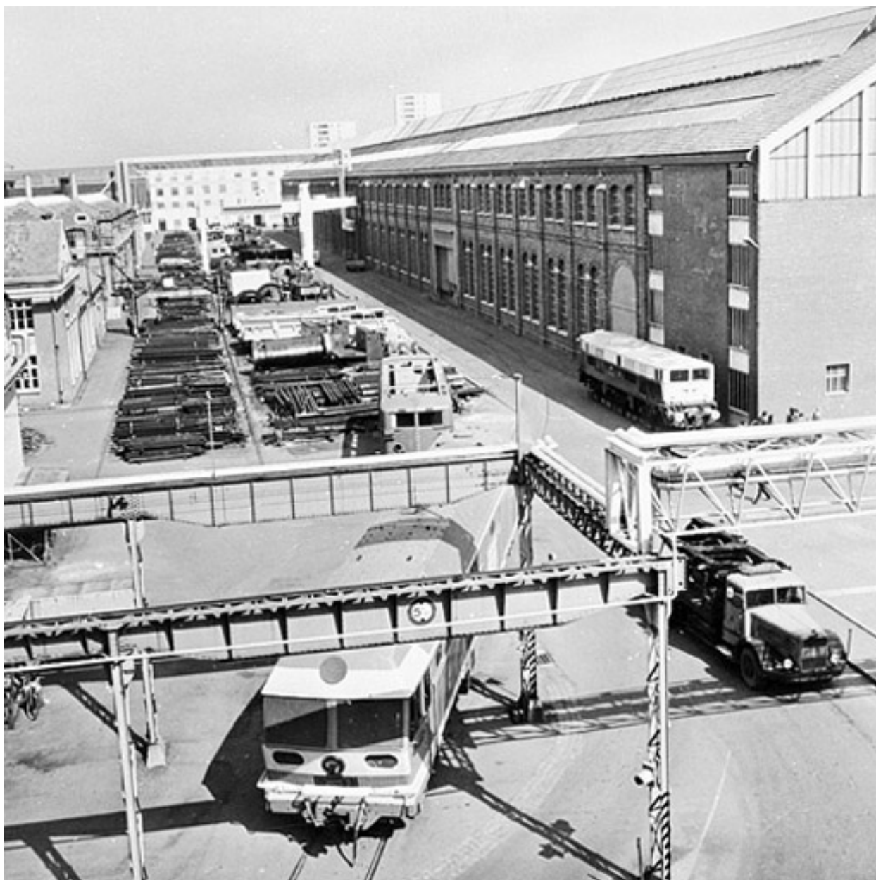
Atelier de montage des tractions depuis le nord-ouest.
