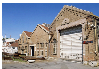
Vue de trois quarts des pignons des ateliers de métallurgie. Phot. Jérôme Mongreville IVR43_20029000071ZA
