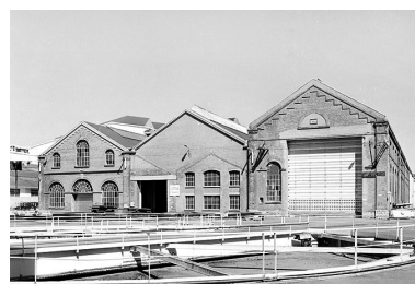
Vue de face des pignons des ateliers de métallurgie. Phot. Jérôme Mongreville IVR43_20029000105X
