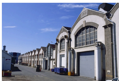
Vue de trois quarts des pignons de l'ancien atelier d'usinage, de soudure et d'assemblage (moyens moteurs). Phot. Jérôme Mongreville IVR43_20029000051ZA
