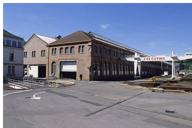
Vue de trois quarts de l'atelier Traction. Phot. Jérôme Mongreville IVR43_20029000104ZA
