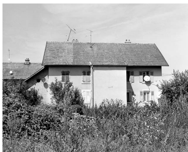
Façade postérieure d'un logement ouvrier collectif.
