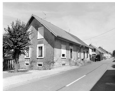
Maisons à double logement. Phot. Yves Sancey IVR43_20019000484X
