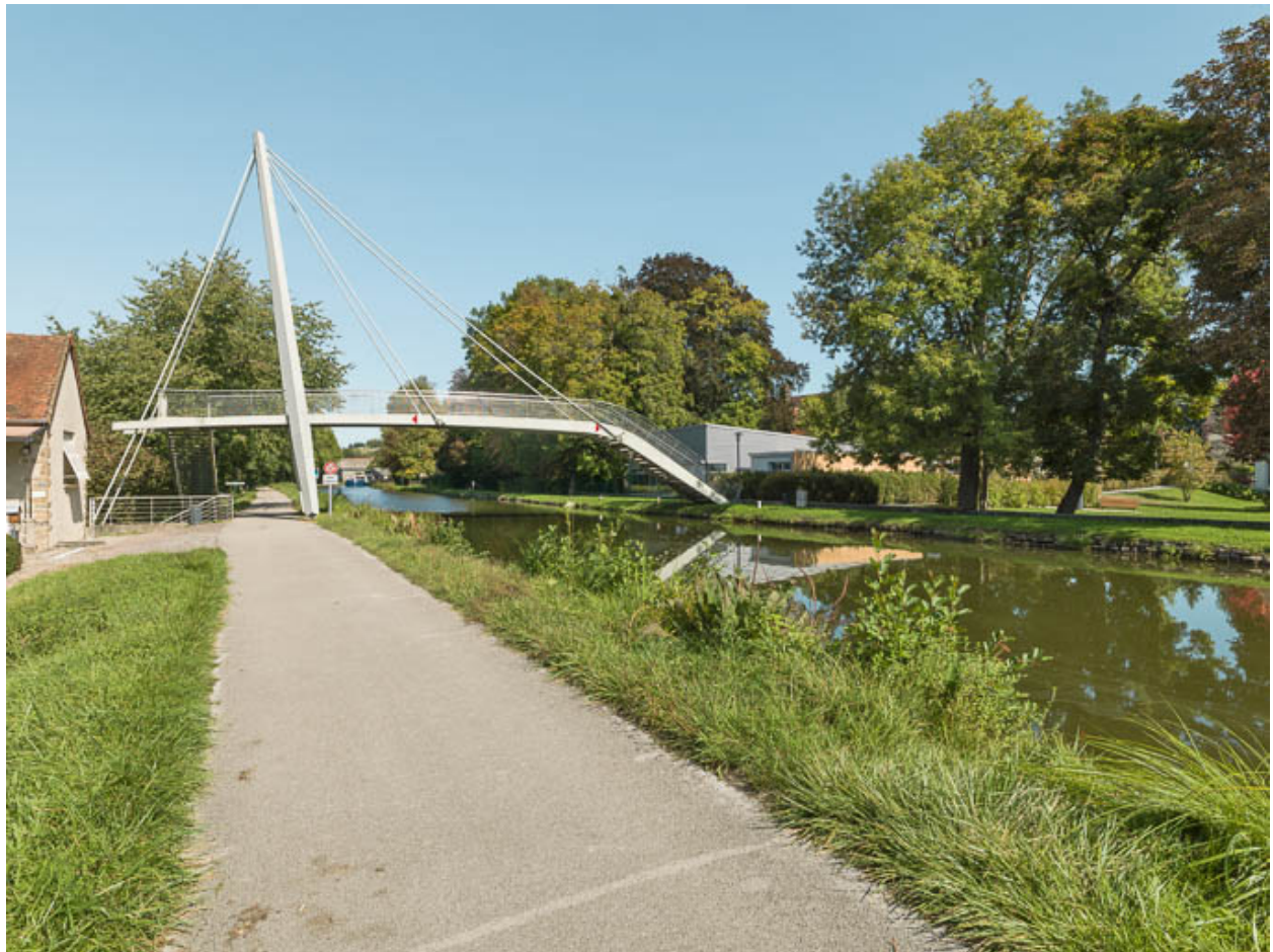
Vue d'ensemble de la passerelle.
