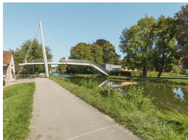
Vue d'ensemble de la passerelle. Phot. Pierre-Marie Barbe-Richaud IVR26_20177100388NUC2A
