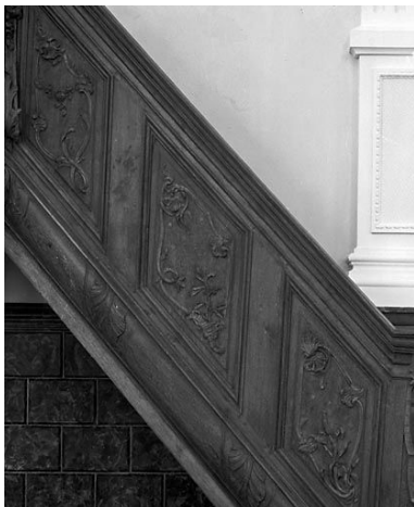
Détail de la rampe. Phot. Yves Sancey
