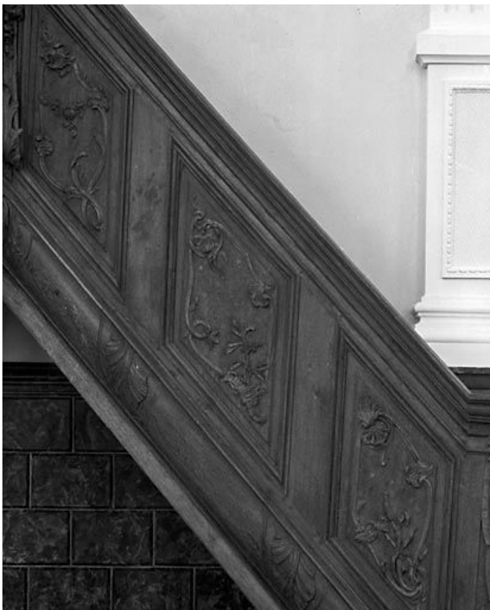
Détail de la rampe.
