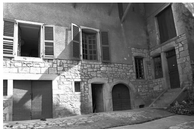
Elévation côté cour. Phot. Yves Sancey IVR43_19802500982X
