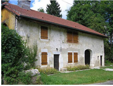
Vue de la façade antérieure. Phot. Marie-Pierre Reynet IVR43_20083900074NUC1A
