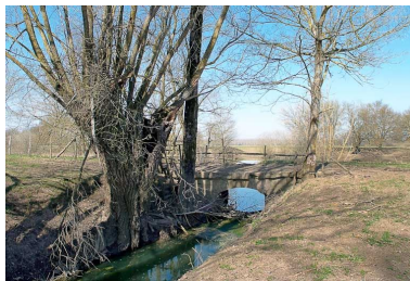
Ponceau : vue d'ensemble. Phot. Jean-Luc Duthu IVR26_20107100463NUC2A
