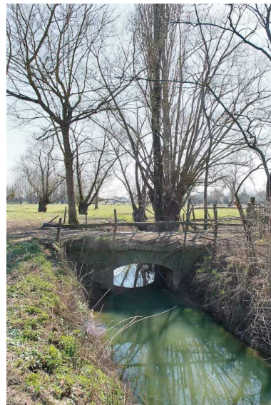
Ponceau : vue rapprochée. Phot. Jean-Luc Duthu IVR26_20107100465NUC2A
