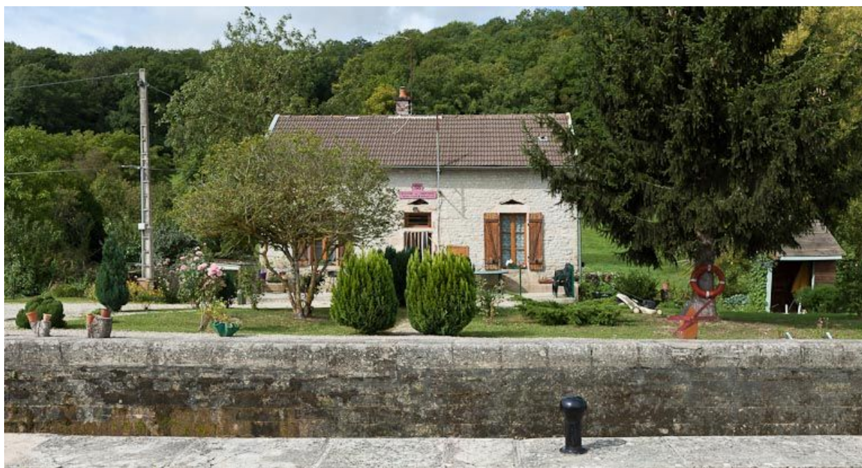
Vue de face de la maison éclusière.
