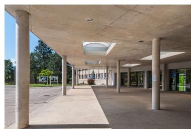
Liaison couverte entre bâtiments et préau. Phot. Jérôme Mongreville IVR43_20143900575NUC4A
