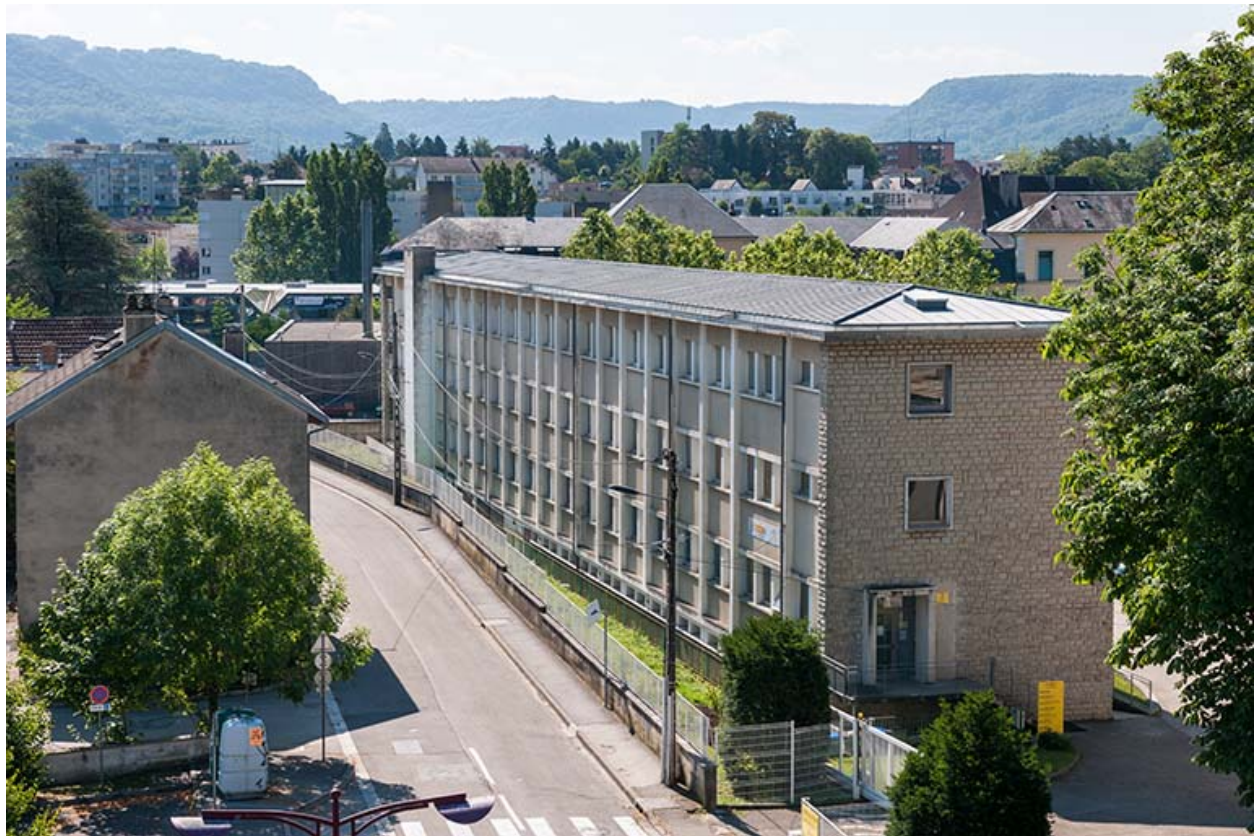
Vue trois quart de l'externat, ancien GRETA.
