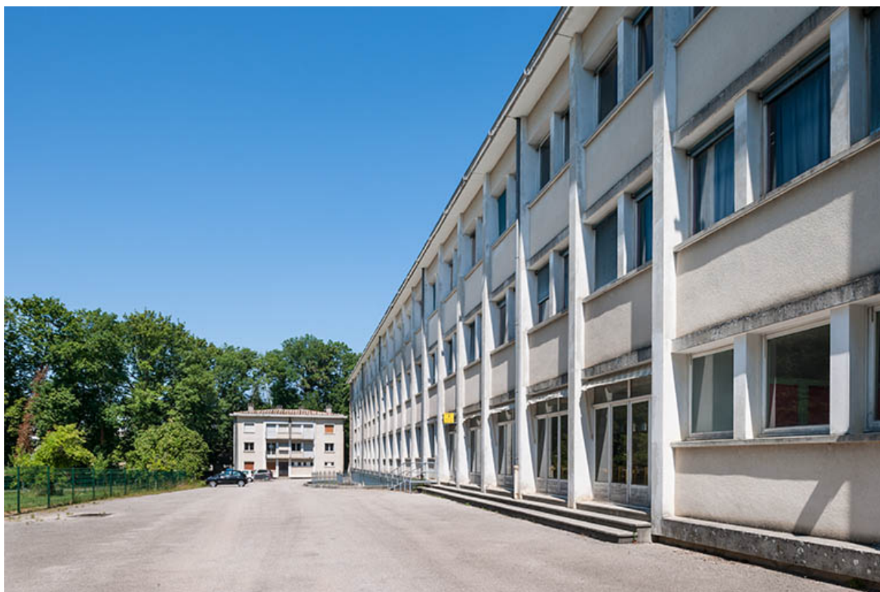
Façade de l'externat, en arrière-plan logements.
