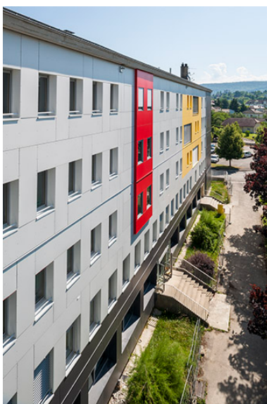
Façade antérieure de l'internat rénovée avec parement isolant. Phot. Jérôme Mongreville IVR43_20143900574NUC4A
