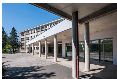
Liaison entre bâtiments : détail. Phot. Jérôme Mongreville IVR43_20143900576NUC4A
