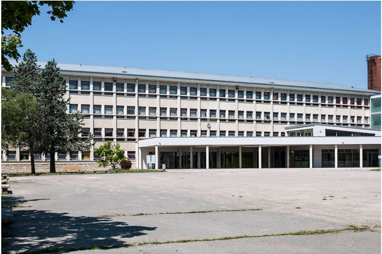
Vue de la façade postérieure de l'internat.
