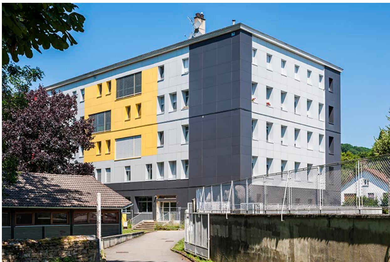
Façade latérale de l'internat après rénovation.
