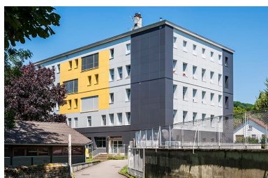
Façade latérale de l'internat après rénovation. Phot. Jérôme Mongreville IVR43_20143900569NUC4A
