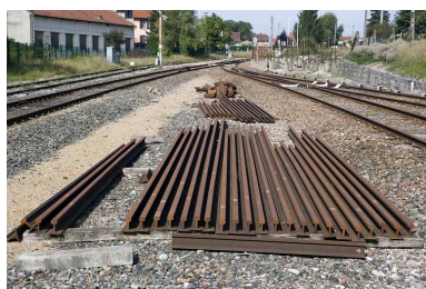
Stock de rails en gare de Champagnole. Phot. Yves Sancey IVR43_20083900881NUC2A
