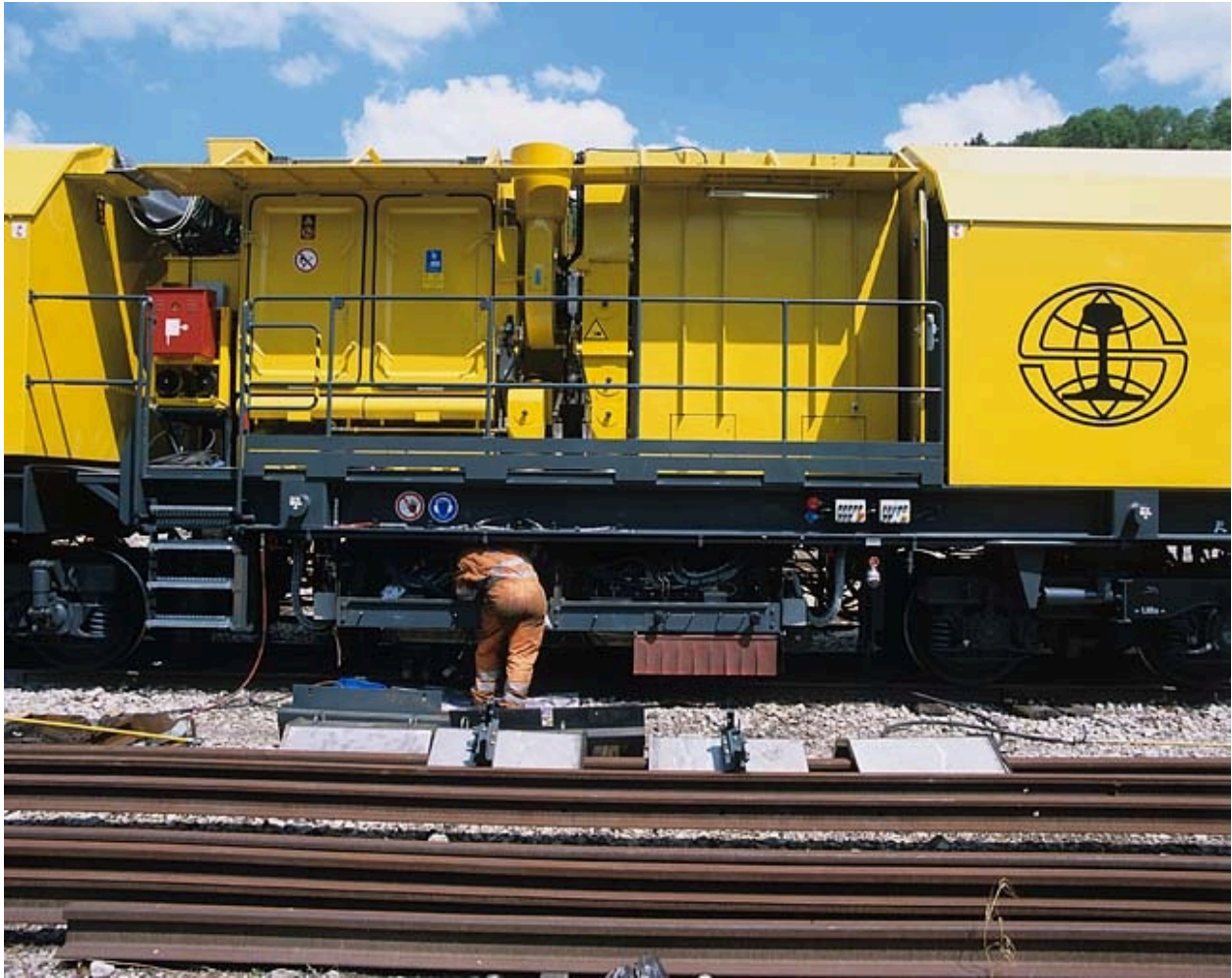
Train de meulage : maintenance et réglages sur l'un des wagons.
