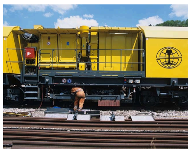
Train de meulage : maintenance et réglages sur l'un des wagons. Phot. Yves Sancey IVR43_20053900924XA
