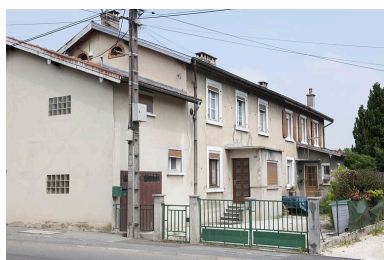
Cité ouvrière. Façade est d'une habitation. Phot. Jérôme Mongreville IVR43_20122500970NUC4A
