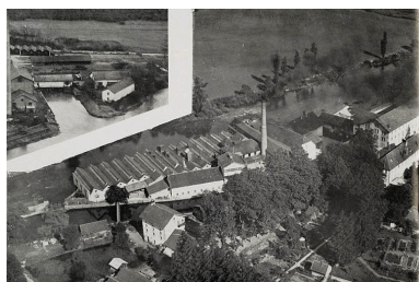
Les papeteries de Mandeure (Doubs). Photogr., s.n., s.d. [vers 1960] Phot. Marc Loukachine, Autr. More L. (photographe) IVR43_20122500905NUC4A
