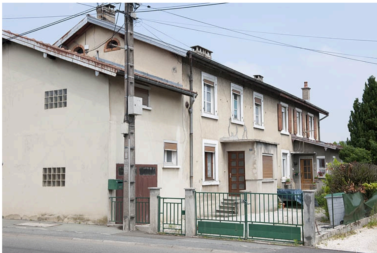
Cité ouvrière. Façade est d'une habitation.
