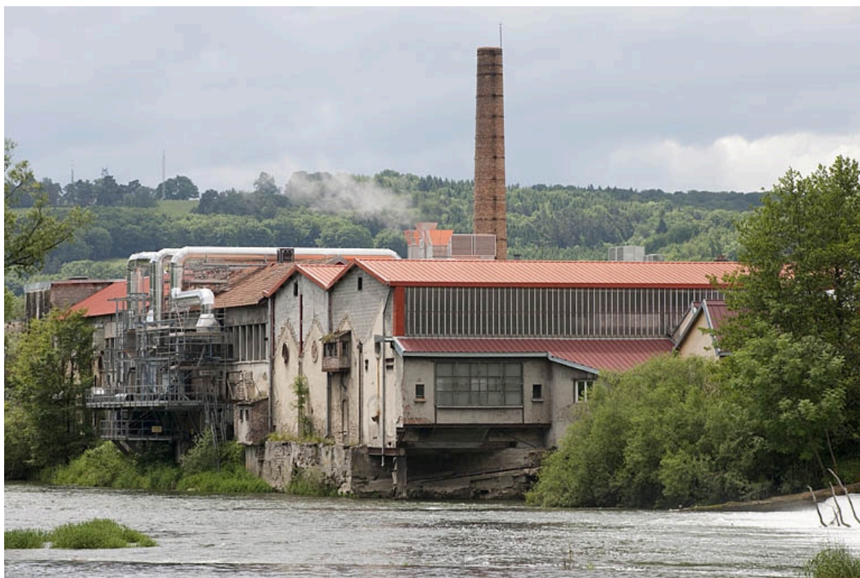
Bâtiments industriels depuis le nord.
