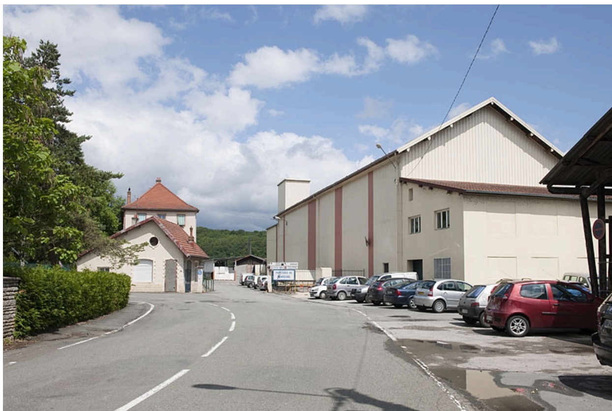
Vue d'ensemble de l'entrée de la papeterie.
