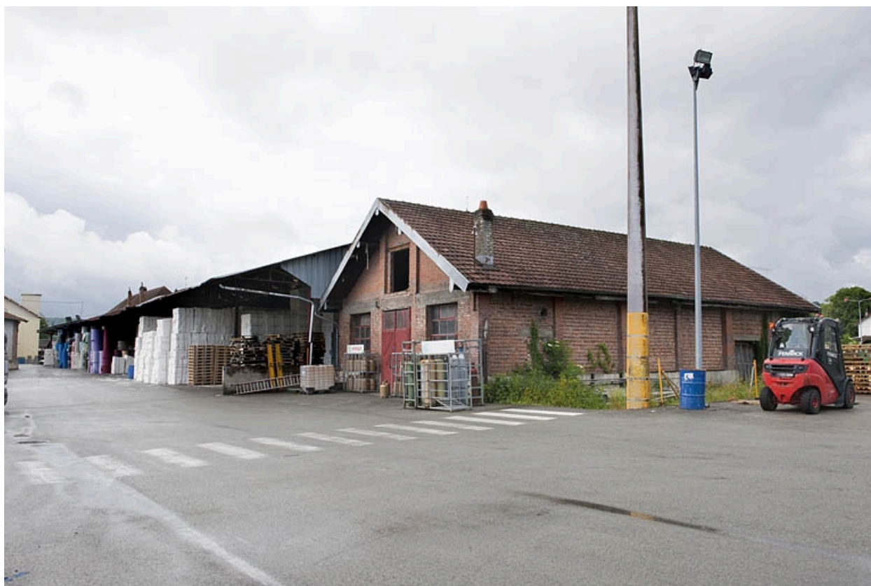
Entrepôts industriels depuis la cour.
