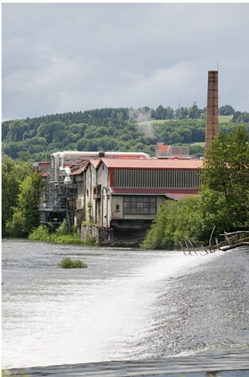
Barrage et bâtiments industriels depuis le nord.
