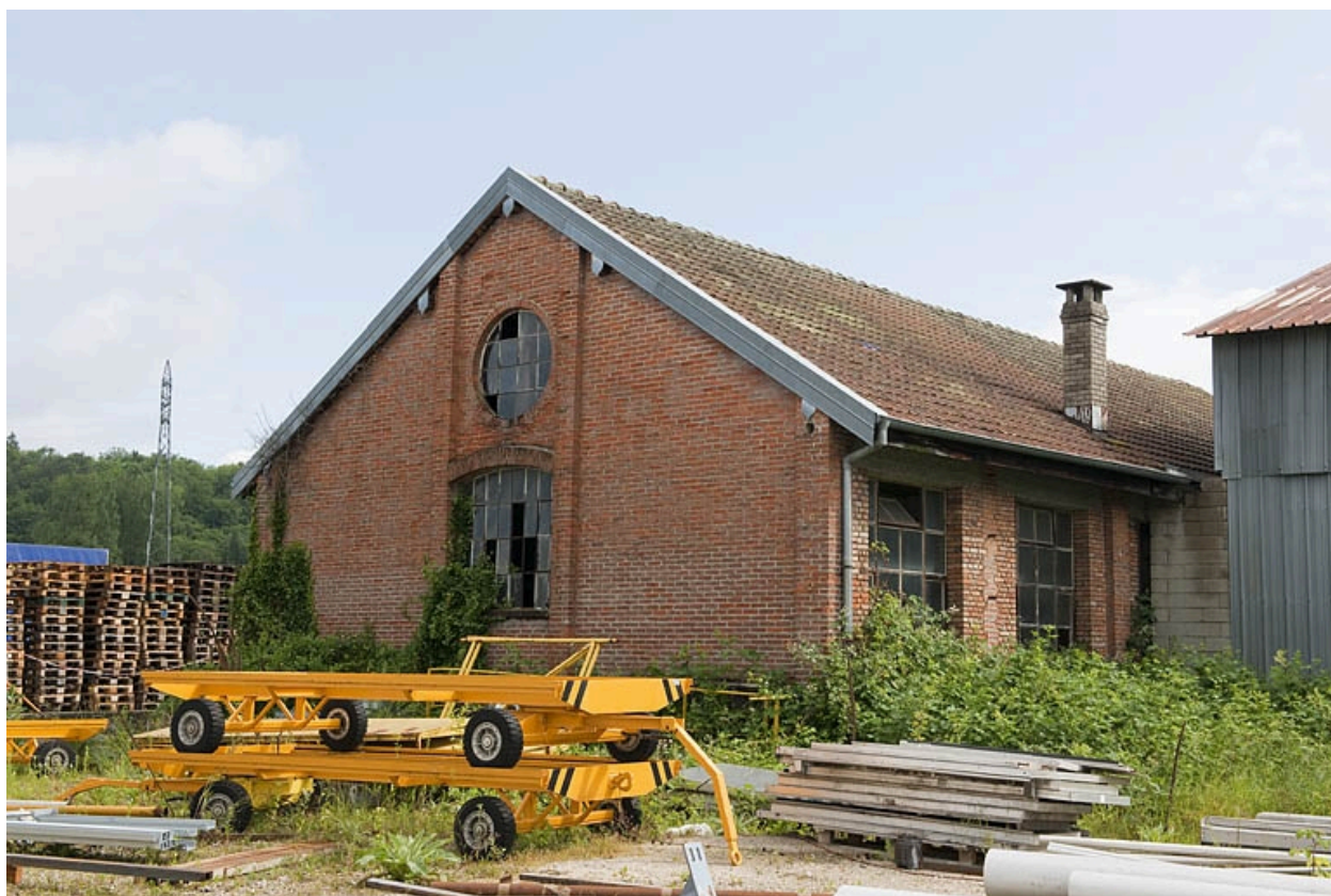
Entrepôt industriel vu de trois quarts arrière.
