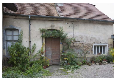
Façade antérieure. Phot. Jérôme Mongreville IVR43_20127000656NUC4A
