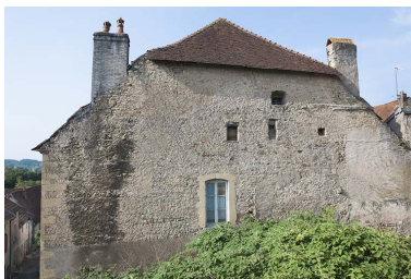
Façade latérale droite. Phot. Jérôme Mongreville IVR43_20127000653NUC4A
