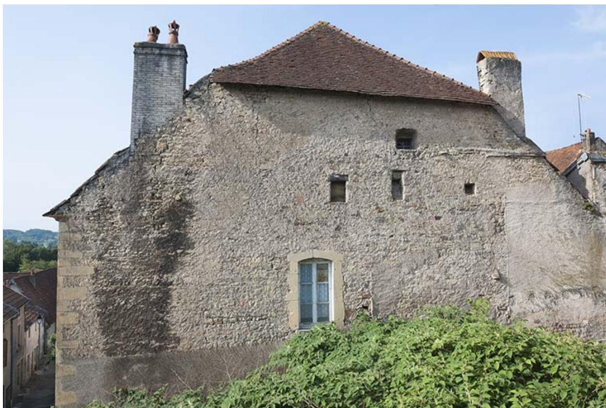
Façade latérale droite.
