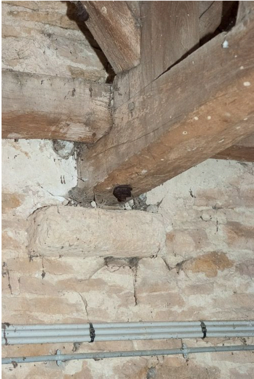
Détail d'un support en pierre du beffroi.
