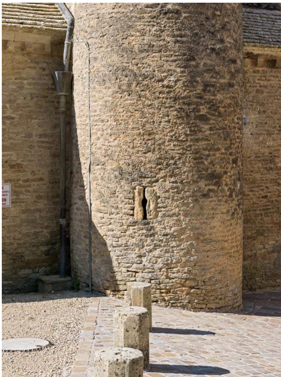
Tourelle d'escalier : détail du jour en archère.
