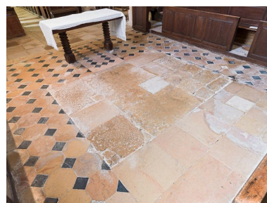
Dallage du chœur. Phot. Pierre-Marie Barbe-Richaud IVR26_20162100199NUC2A
