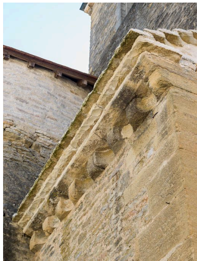
Élévation nord-est, détail des corniches. Phot. Pierre-Marie Barbe-Richaud IVR26_20162100438NUC2A
