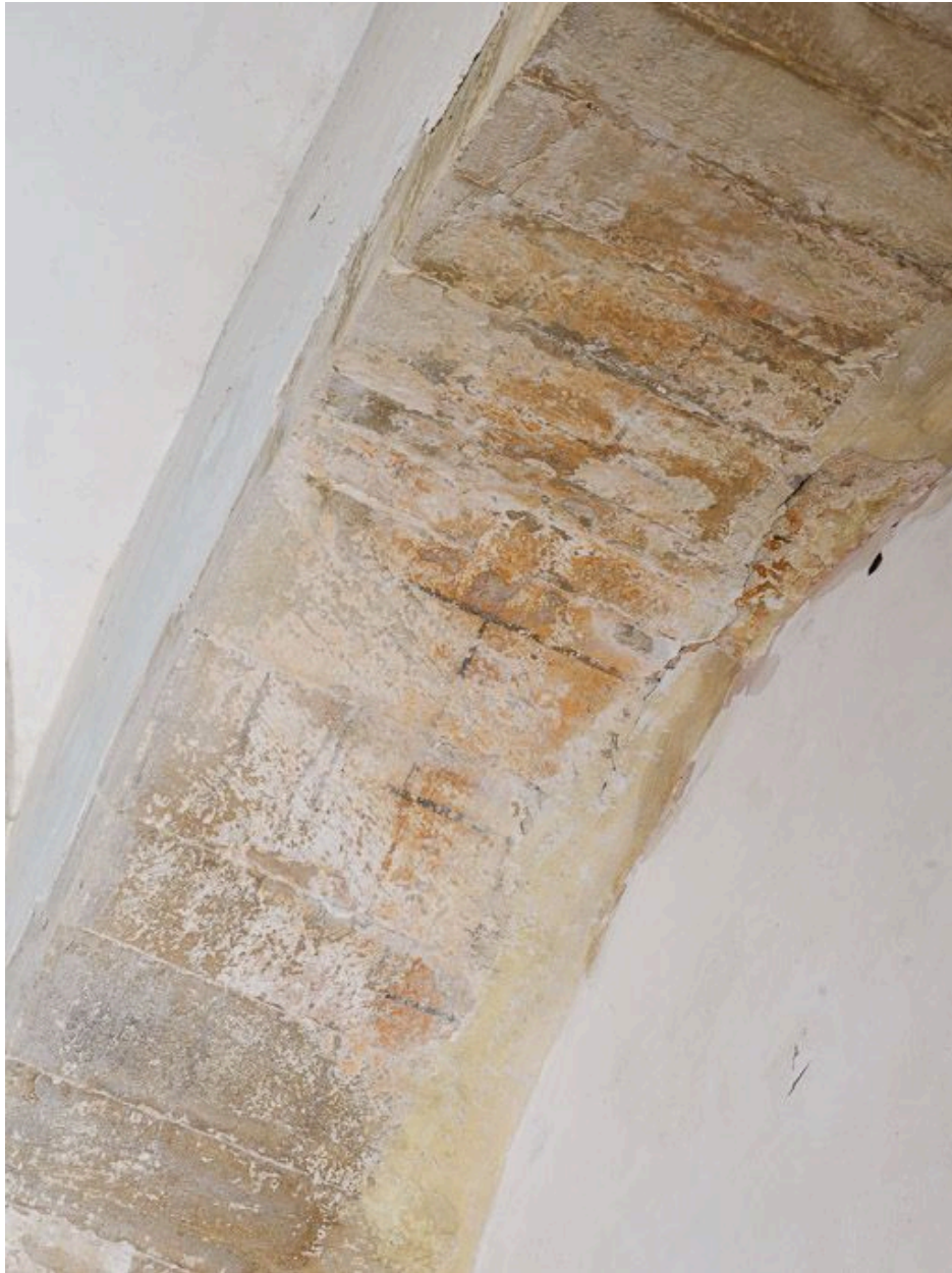
Détail des traces de peintures murales dessinant un faux appareillage, au niveau de la 1ère travée.
