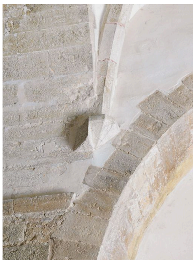
Culot de la voûte de la travée sous clocher. Phot. Pierre-Marie Barbe-Richaud IVR26_20162100187NUC2A
