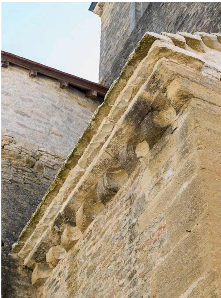
Elévation nord-est, détail des corniches.
