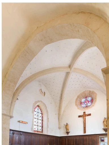
Voûte du chœur. Phot. Pierre-Marie Barbe-Richaud IVR26_20162100197NUC2A
