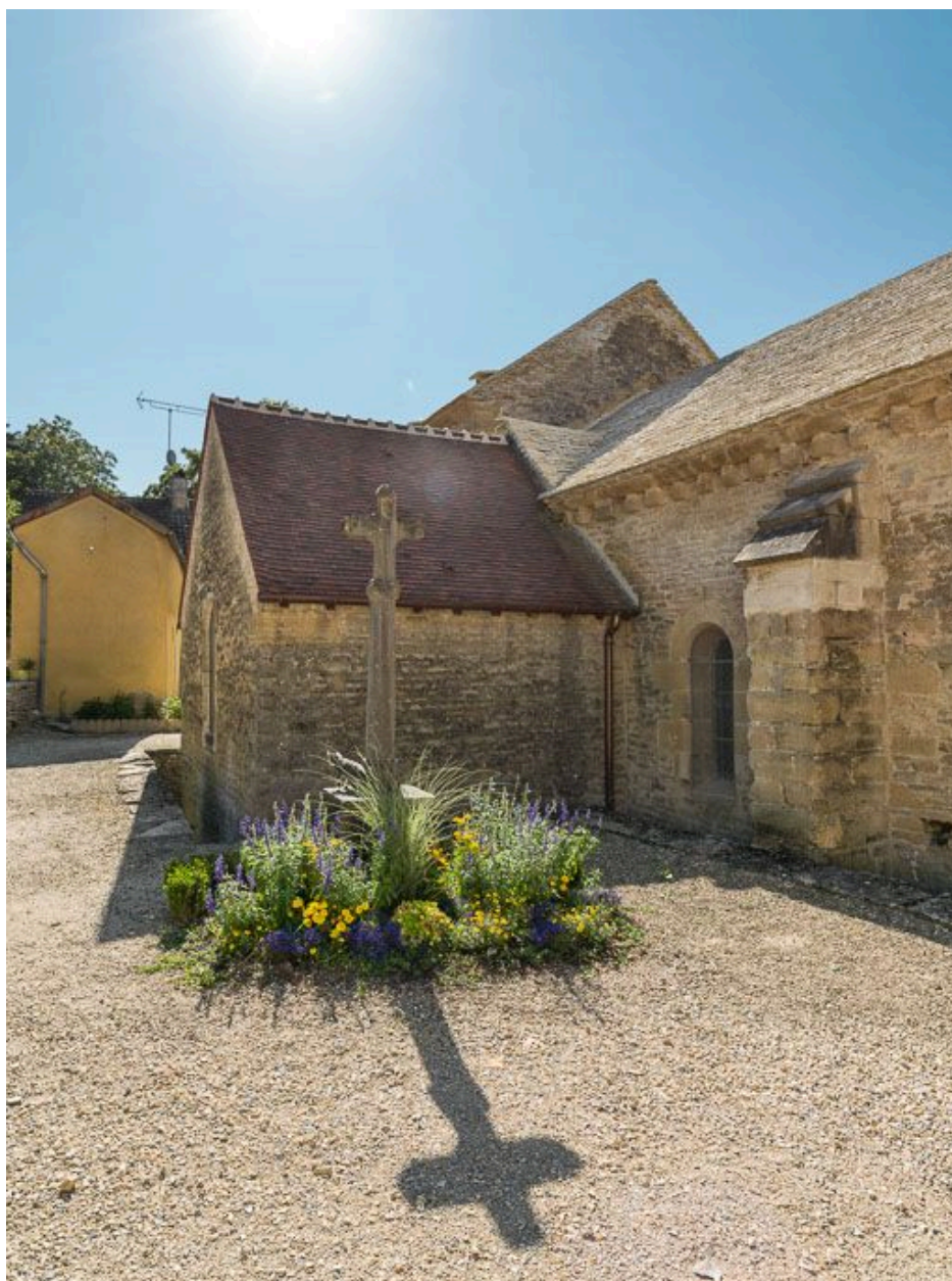
Croix monumentale et chapelle nord-est.
