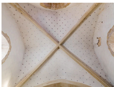
Voûte du chœur. Phot. Pierre-Marie Barbe-Richaud IVR26_20162100198NUC2A
