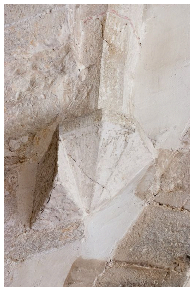
Détail d'un culot de la voûte de la travée sous clocher. Phot. Pierre-Marie Barbe-Richaud IVR26_20162100188NUC2A
