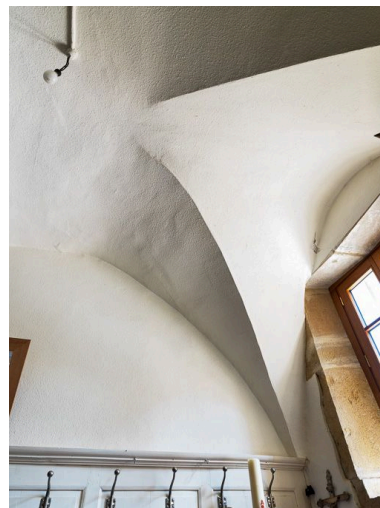
Voûte de la sacristie. Phot. Pierre-Marie Barbe-Richaud IVR26_20162100248NUC2A
