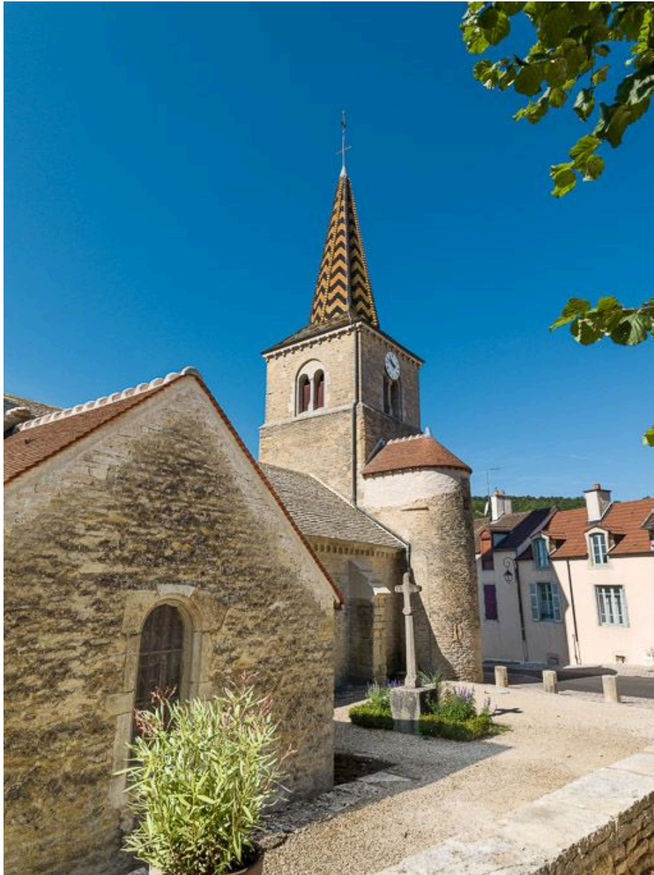
Chapelle nord-est, clocher et tourelle d'escalier.
