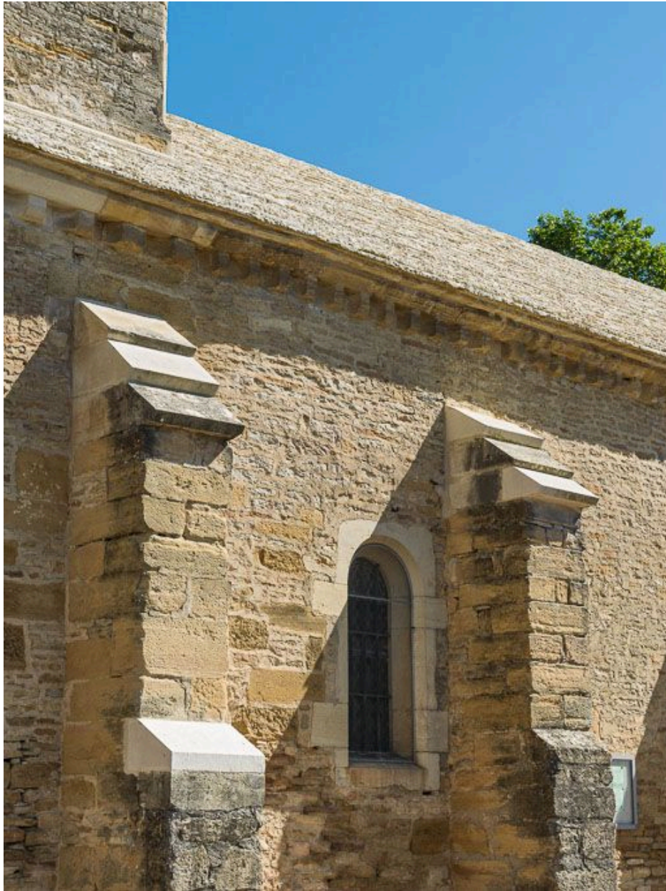
Elévation sud-ouest, détail de la travée.
