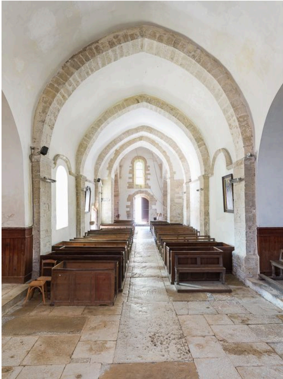
Vue d'ensemble depuis le chœur.
