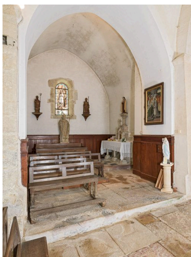
Chapelle nord-est de trois quarts. Phot. Pierre-Marie Barbe-Richaud IVR26_20162100235NUC2A
