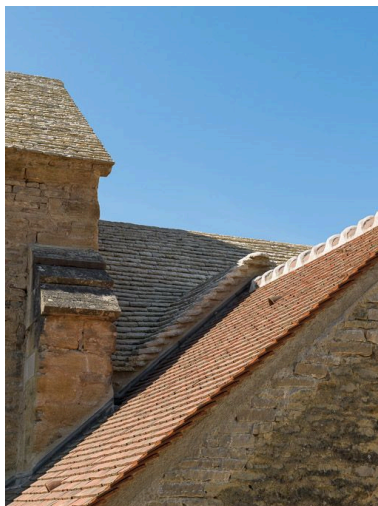
Détail des toitures du chœur, de la chapelle nord-est et de la nef. Phot. Pierre-Marie Barbe-Richaud IVR26_20162100455NUC2A
