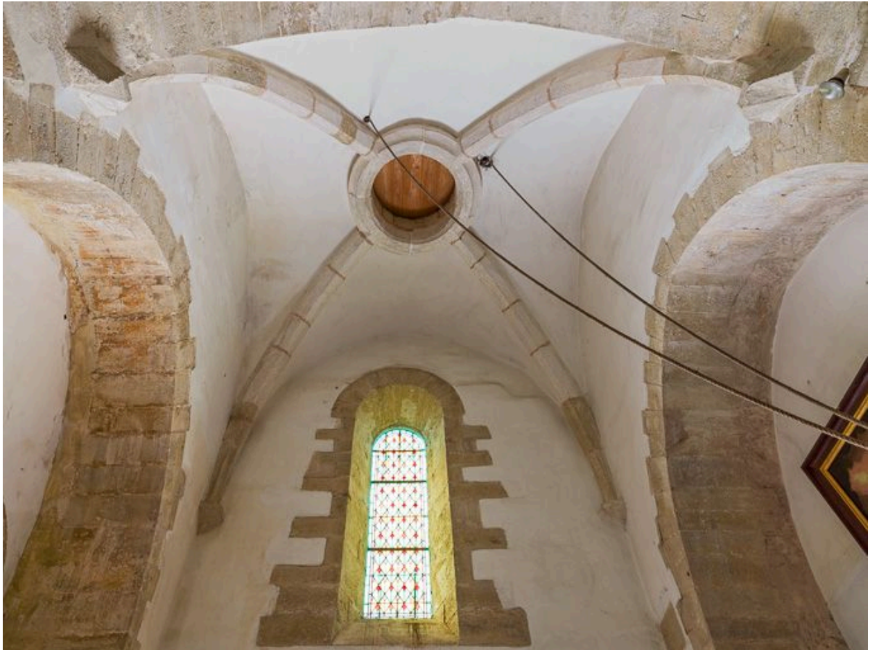
Voûte de la travée sous clocher.
