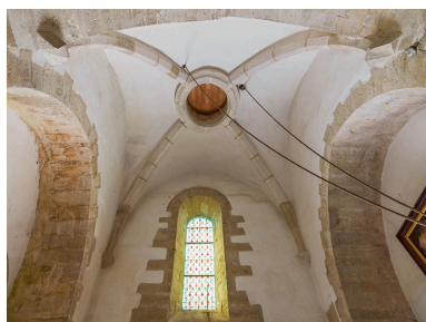
Voûte de la travée sous clocher. Phot. Pierre-Marie Barbe-Richaud IVR26_20162100186NUC2A
