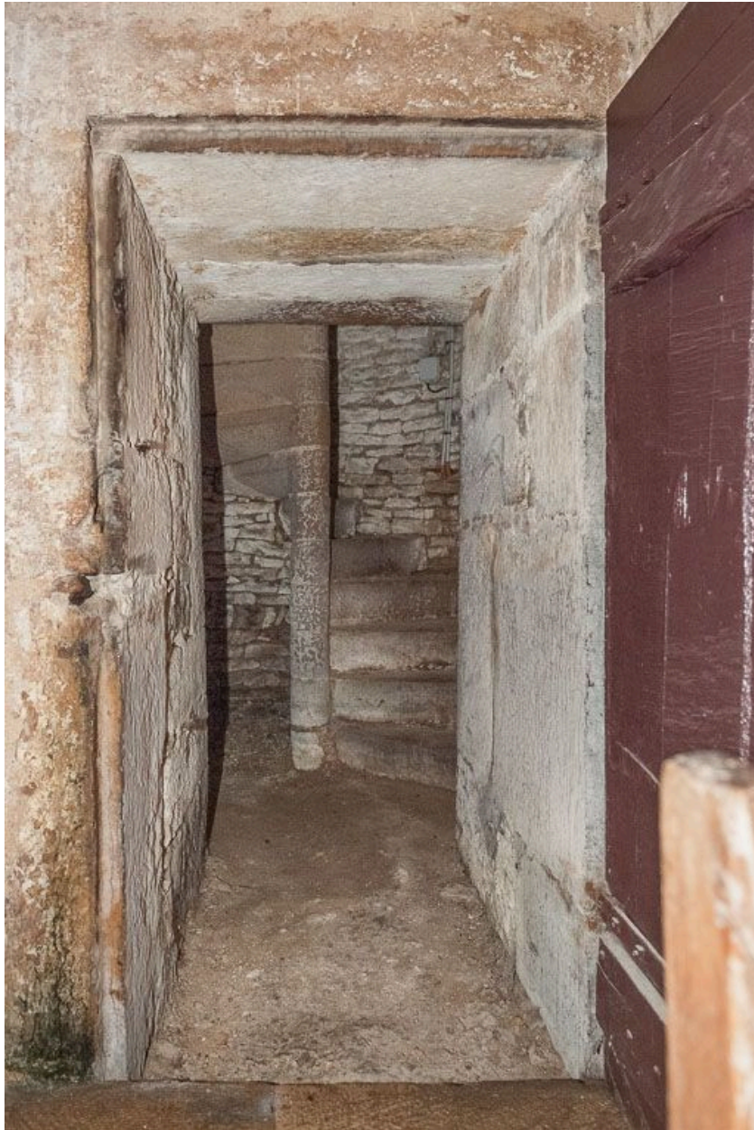
Départ d'escalier de la tourelle du clocher.
