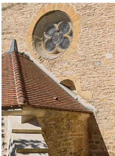
Détail de l'oculus et de la baie murée du choeur. Phot. Pierre-Marie Barbe-Richaud
