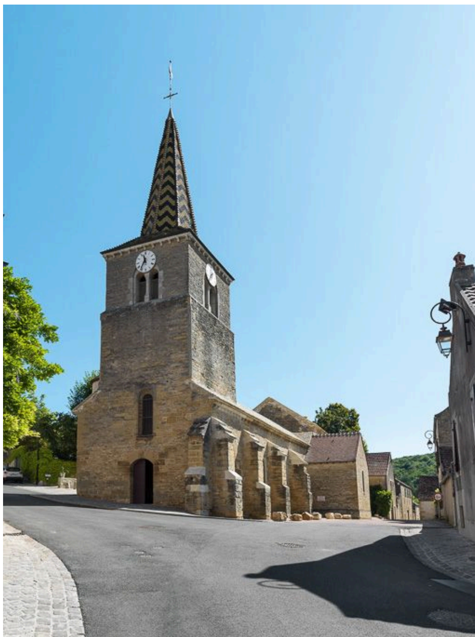
Vue d'ensemble, façade et élévation sud-ouest.
