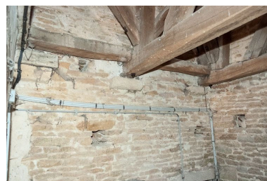
Beffroi du clocher. Phot. Pierre-Marie Barbe-Richaud IVR26_20162100218NUC2A
