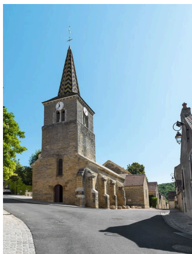
Vue d'ensemble, façade et élévation sud-ouest. Phot. Pierre-Marie Barbe-Richaud IVR26_20162100429NUC2A
