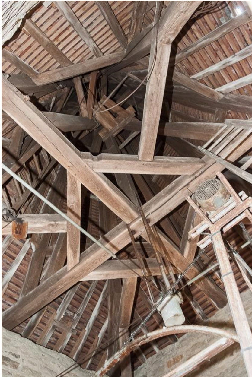
Charpente de la flèche du clocher.
