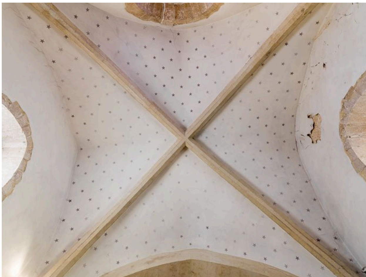
Voûte du chœur.
