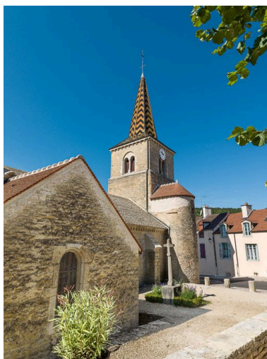
Chapelle nord-est, clocher et tourelle d'escalier. Phot. Pierre-Marie Barbe-Richaud IVR26_20162100446NUC2A
