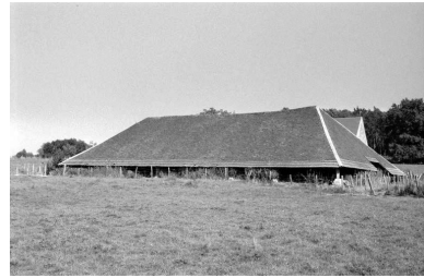
Halle de séchage, depuis l'ouest. Phot. Laurent Poupard IVR43_19883900538Z
