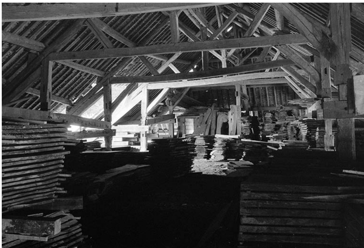
Intérieur de la halle de séchage.
