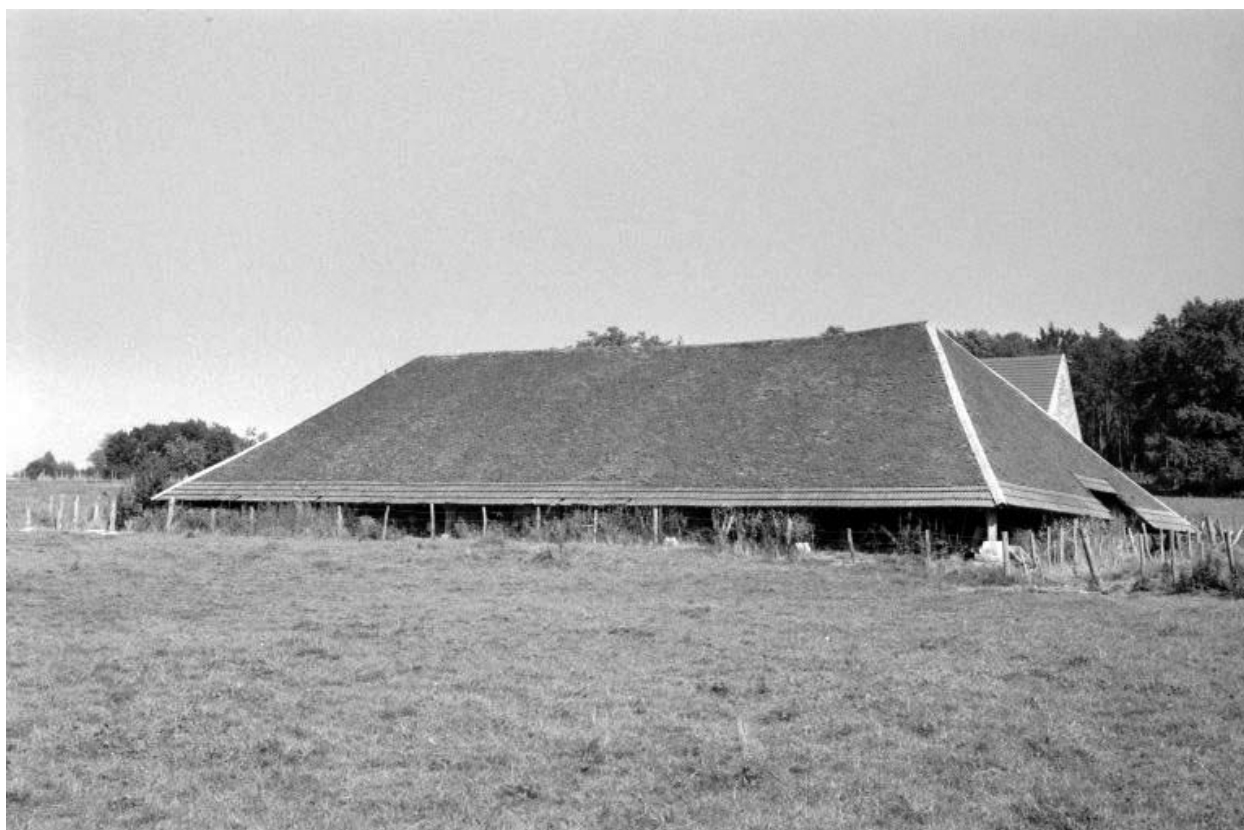
Halle de séchage, depuis l'ouest.
