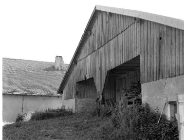
Façade postérieure. Phot. Yves Sancey IVR43_19782500180X
