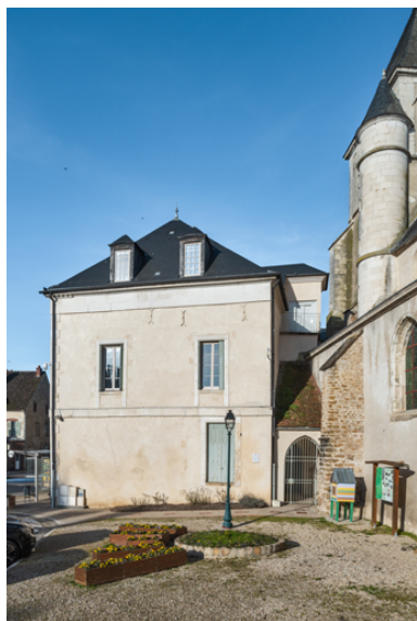
Façade latérale droite. Phot. Pierre-Marie Barbe-Richaud IVR26_20238900340NUC4A
