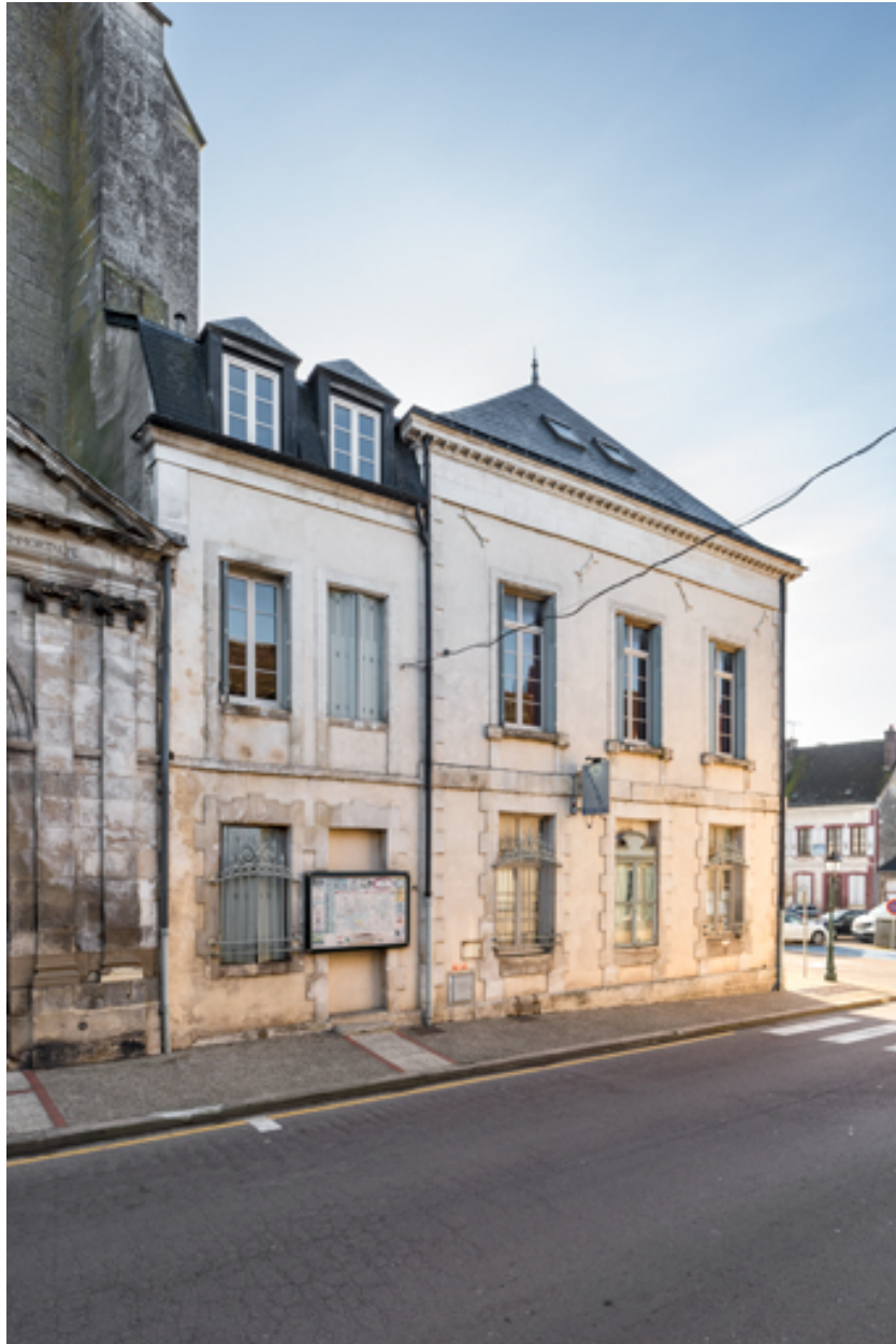
Façade latérale gauche, de trois quarts droite.
