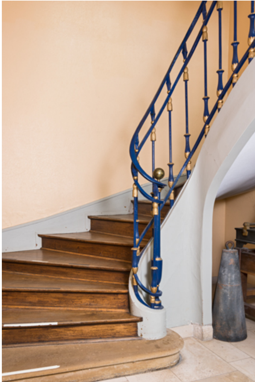
Escalier donnant accès au 1er étage : départ de rampe.
