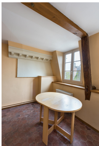
Etage en surcroît de l'extension (au nord) : loge d'acteur. Le retour de la corniche à modillons extérieure est toujours visible. Phot. Pierre-Marie Barbe-Richaud IVR26_20238900359NUC4A
