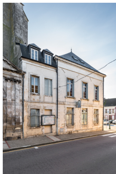
Façade latérale gauche, de trois quarts droite. Phot. Pierre-Marie Barbe-Richaud IVR26_20238900341NUC4A
