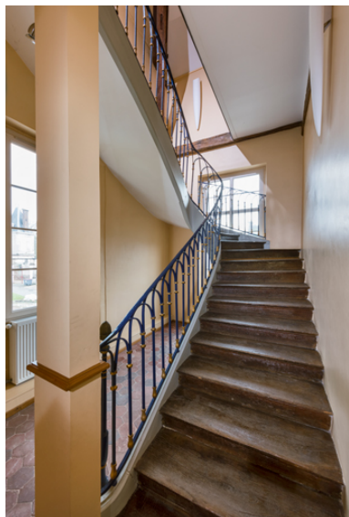
Escalier donnant accès à l'étage en surcroît. Phot. Pierre-Marie Barbe-Richaud IVR26_20238900358NUC4A
