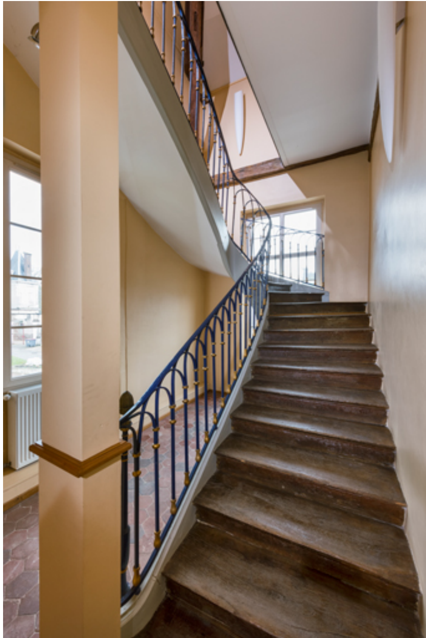
Escalier donnant accès à l'étage en surcroît.
