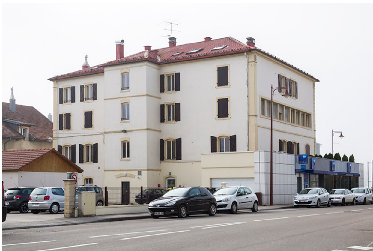
Façades postérieure et latérale gauche.
