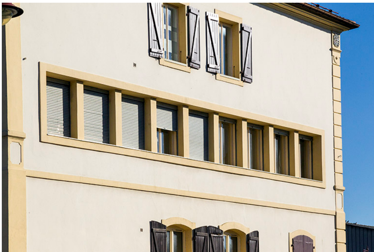
Fenêtres multiples sur la façade latérale gauche.
